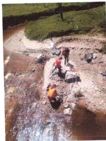
Foto 12: Demolición mole de concreto espíritu santo.
