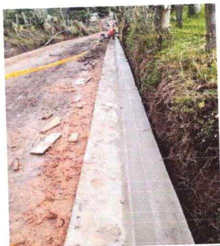
Foto 7: Vaciado y desencofrado de cunetas.
