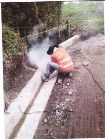
Foto 10: Juntas de dilatación.
