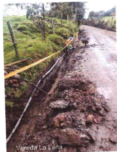
Foto 8: Excavación para la construcción del filtro.
