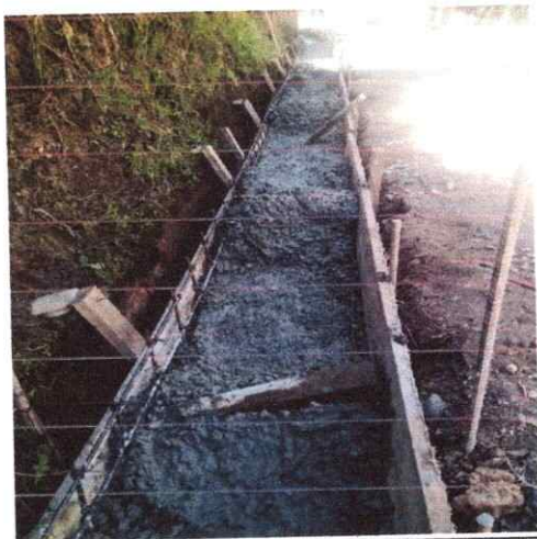
Foto 3: Vaciado triturado de 1".
