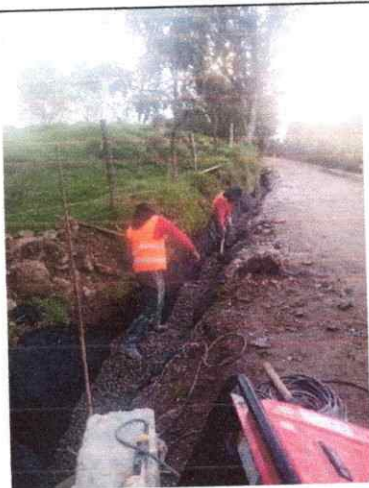
Foto 9: Colocación del geotextil en el filtro.
