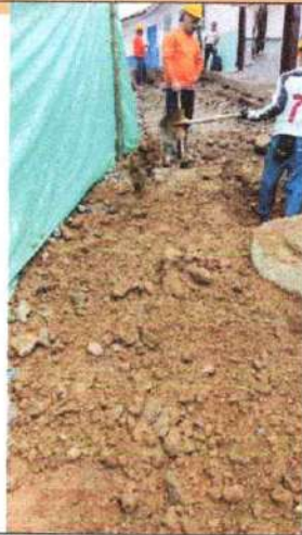
Foto 9. Lleno con material de préstamo
