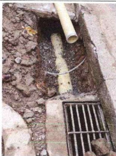
Foto 17. Instalación de Tubería Novafort
