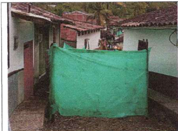
Foto 27. Señalización prevención y cerramiento de vía
