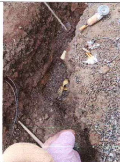
Foto 18. Brechas de excavación
