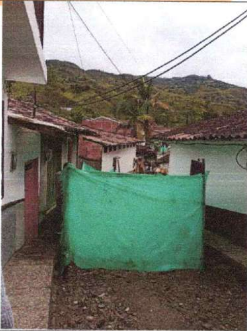
Foto 1. Estado inicial del proyecto
