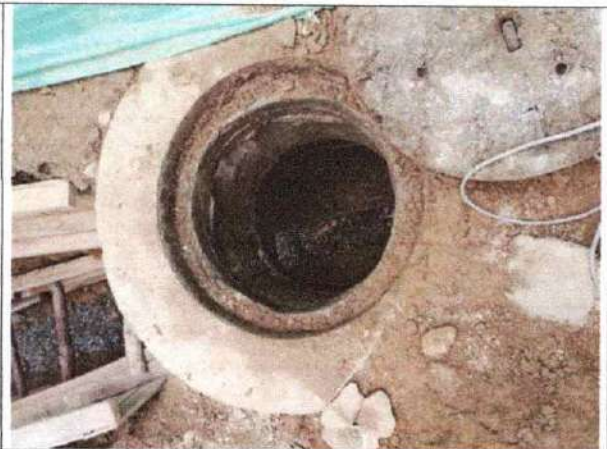
Foto 20. Pozo de Inspección Existente
