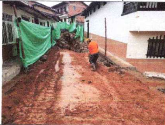
Foto 11. Lleno con material de préstamo
