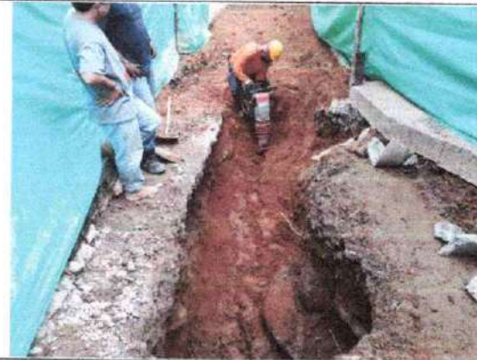
Foto 12. Compactación de material
