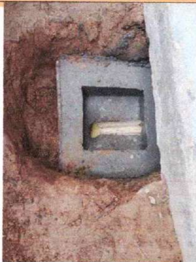
Foto 15. Cajas de Inspección Domiciliarias
