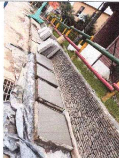
Foto 22. Tapas fabricadas In Situ
