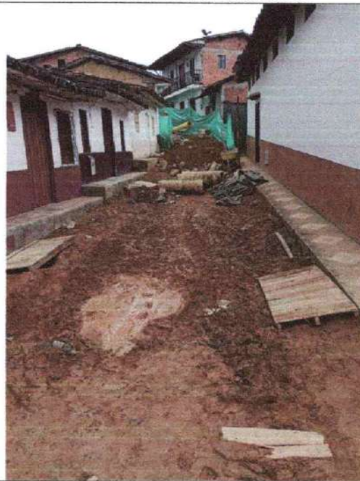
Foto 8. Riego de Material para Lleno
