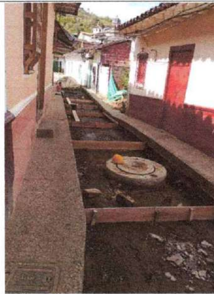
Foto 26. Acabado de Proyecto
