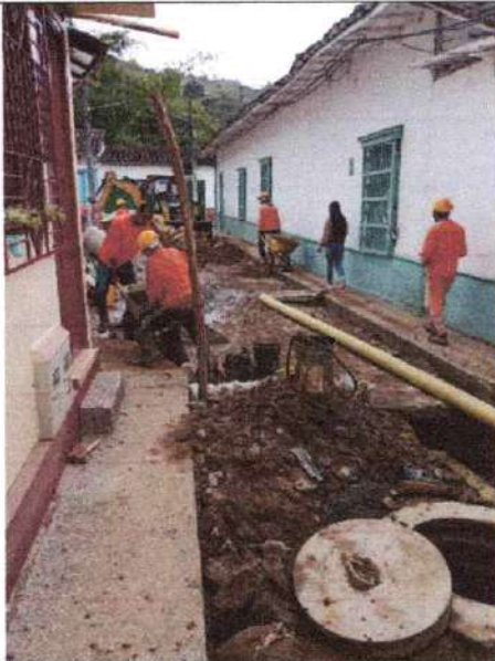
Foto 29. Uso de casco, para labores donde se presentan riesgo de caída de elementos.
