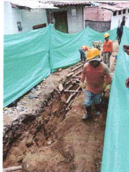
Foto 4. Excavación de material común.
