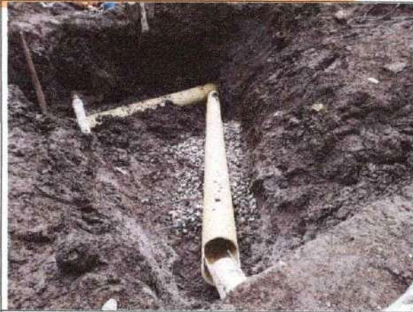
Foto 19. Instalación de Provisionales domiciliaria
