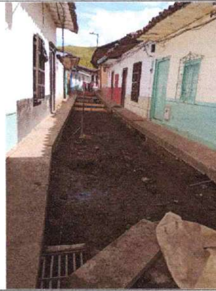
Foto 24. Acabado de Proyecto
