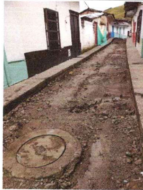
Foto 2. Estado inicial del proyecto
