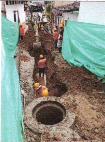
Foto 3. Excavación de material común.
