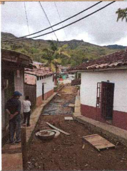
Foto 23. Acabado de Proyecto
