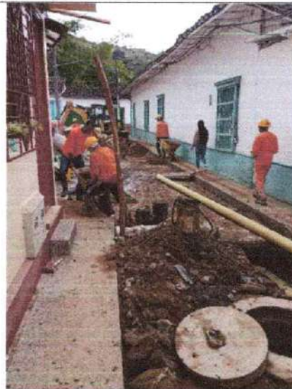
Foto 6. Excavación de Brechas
