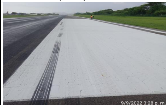
Foto 5. Recorrido de la señalización horizontal de la pista
