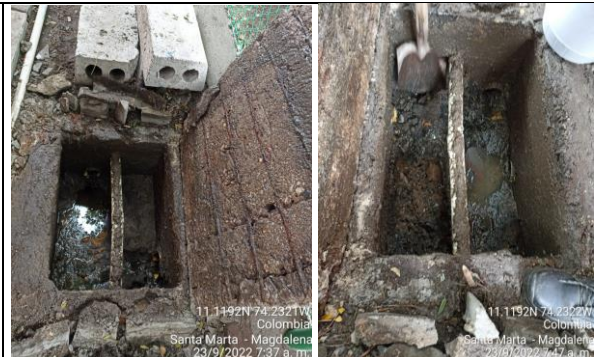
Foto 5. Limpieza de caja de Inspección en edificio SEI
