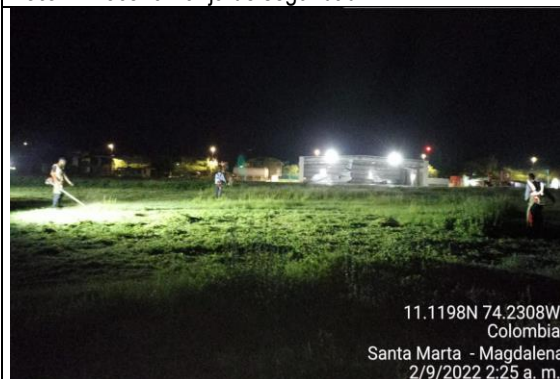
Foto 3 Rocería franja de seguridad
