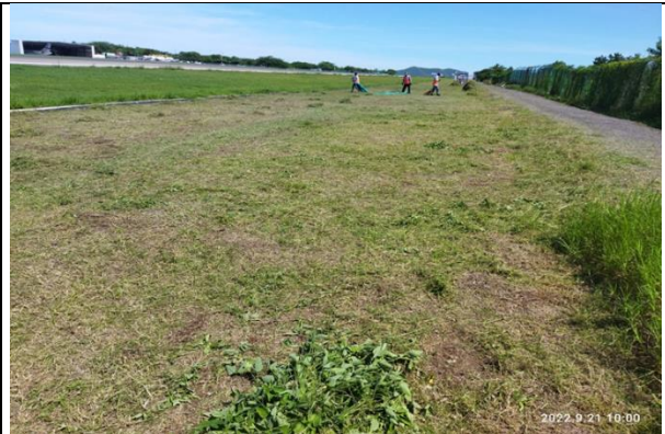
Foto 2. Rocería franja de seguridad
