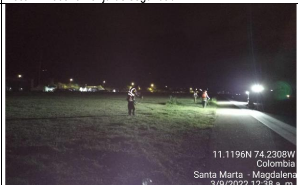
Foto 4 Rocería franja de seguridad
