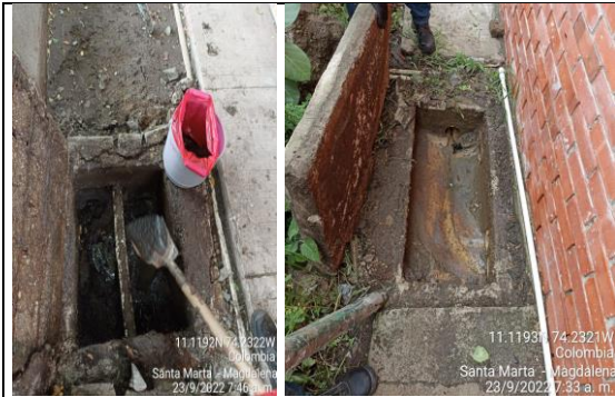
Foto 5. Limpieza de caja de Inspección en edificio SEI
