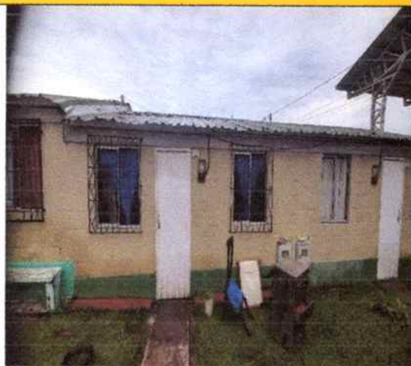
Foto 1: Fachada de vivienda
