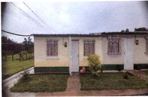
Foto 1: Fachada de vivienda
