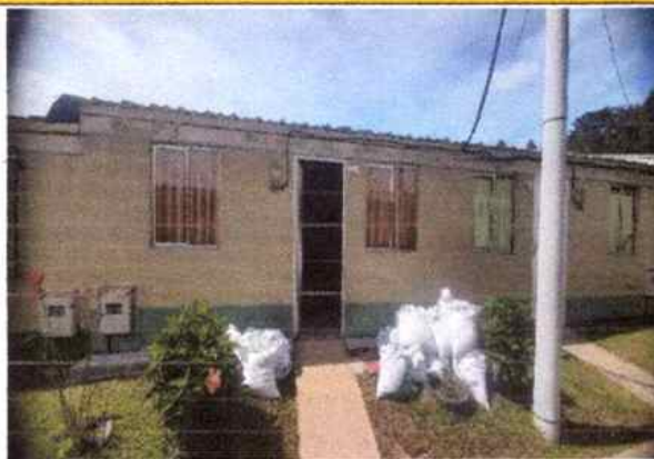
Foto 1: Fachada de vivienda
