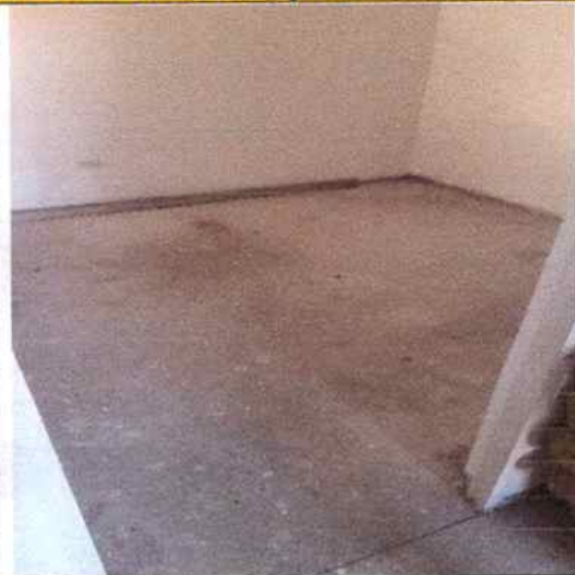
Foto 2: Estado inicial del piso
