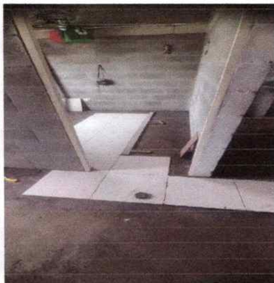
Foto 4: se limpia el espacio para el mortero
