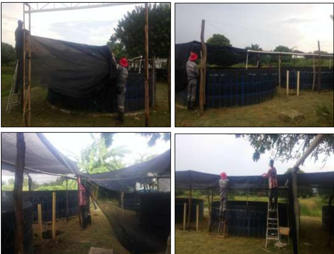
Figura 4. Instalación de la malla polisombra en el área de investigación del policultivo de tilapia roja y camarón blanco en la Estación Piscícola de Repelón.
