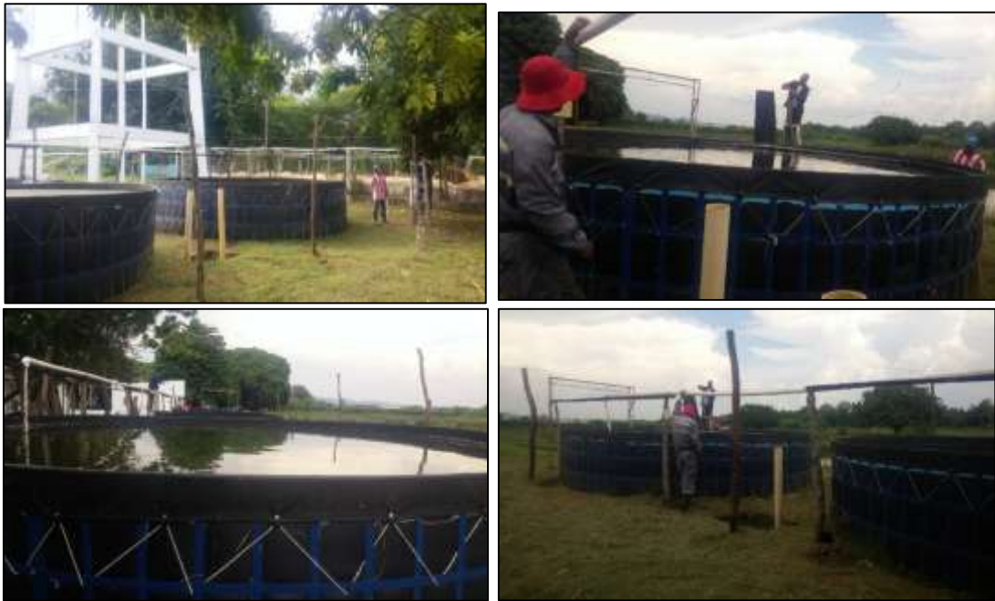
Figura 3. Ubicación de alambre galvanizado para soporte de malla polisombra.
