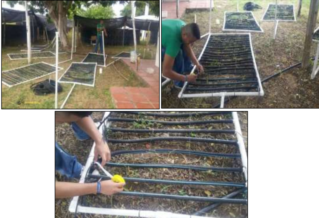
Figura 6. Adecuación de parrilla de aireación en mal estado con nuevos accesorios requeridos.
