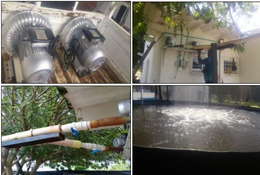
Figura 6. Adecuación de parrilla de aireación en mal estado con nuevos accesorios requeridos.
