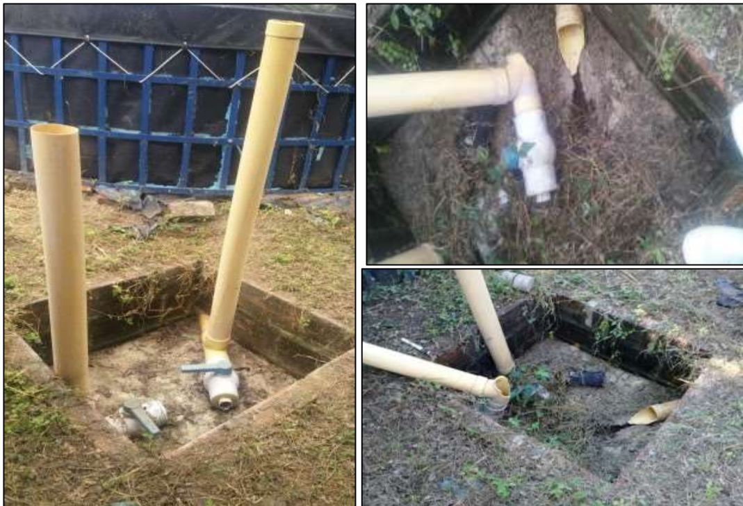
Figura 6. Adecuación del sistema de drenaje de las unidades experimentales que requerían mantenimiento.
