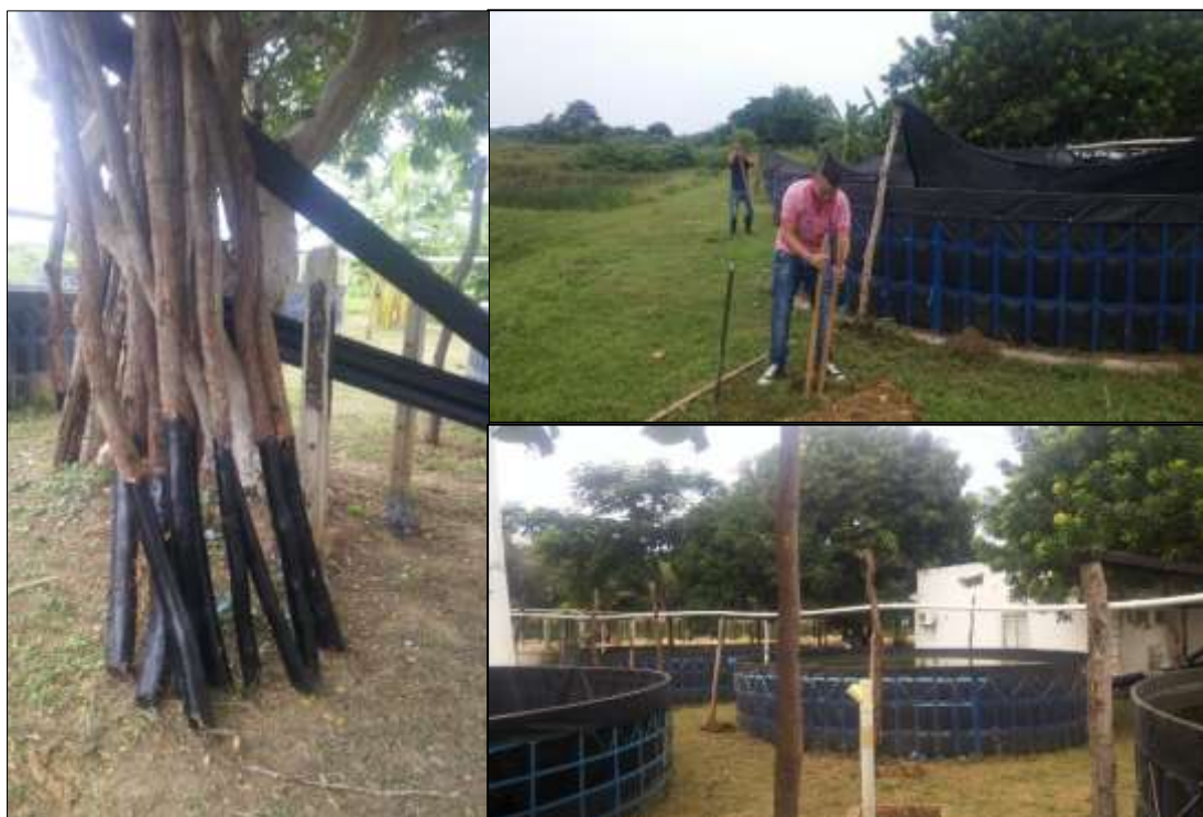
Figura 2. Organización de estructuras en madera para el sostenimiento del techo en polisombra del proyecto
