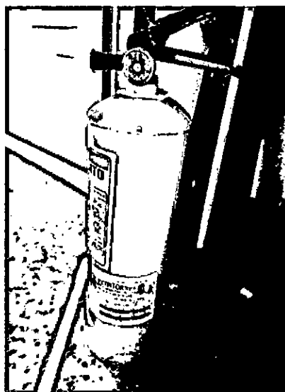
Imagen 3. Extintor Estadio El Campin.
