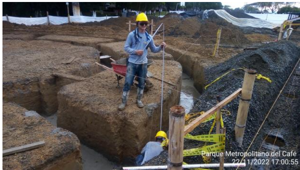
Foto N.17 Concreto de solado y nivelación cimentación Auditorio.
