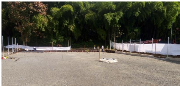
Foto N.19 Construcción cerramiento contra-impacto cancha múltiple.
