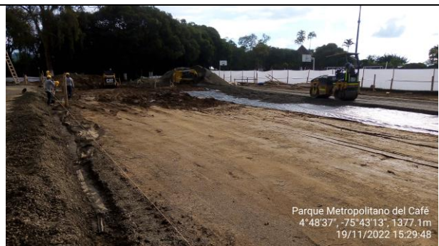
Foto N.8 estabilización de Subrasante en cancha de tenis
