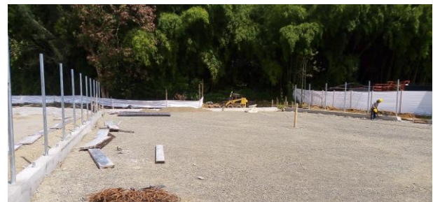
Foto N.20 Construcción cerramiento contra-impacto cancha múltiple.
