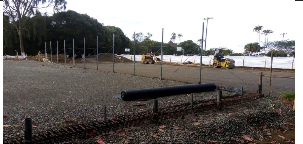
Orden y aseo en las actividades de obra
