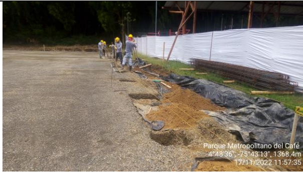
Foto N.15. Excavación para pilotines de cimentación cerramiento contraimpacto. Cancha Múltiple
