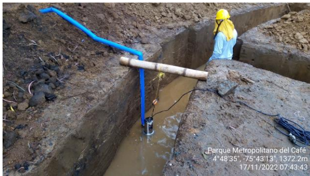
Foto N.5 Afectación lluvias en Auditorio.
