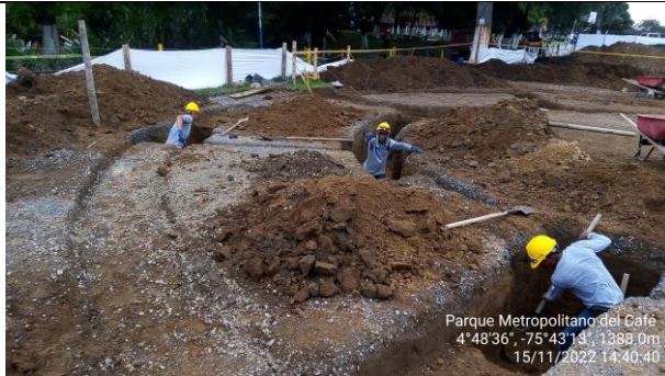
Foto N.3 Excavaciones cimentación Auditorio
