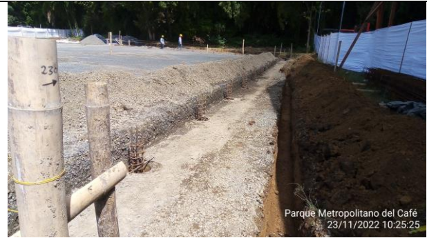
Foto N.16 Acero de refuerzo pilotines vigas de cimentación cerramiento contraimpacto.
