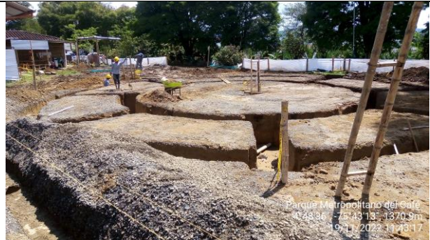
Foto N.4 Excavación y descapote.
