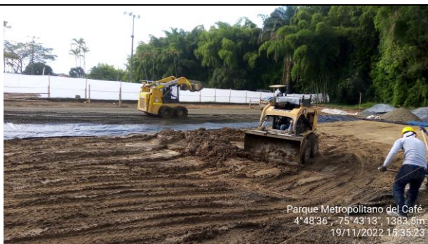
Foto N.7. Excavación para estabilización de Subrasante en cancha de tenis.
