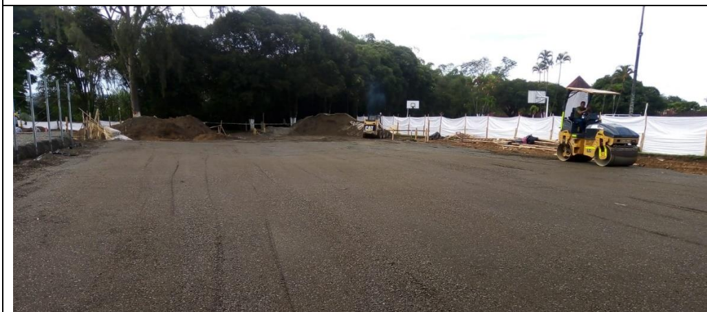
Instalación del cerramiento de obra
