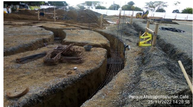
Foto N.18 Instalación acero de refuerzo para cimentación Auditorio.
