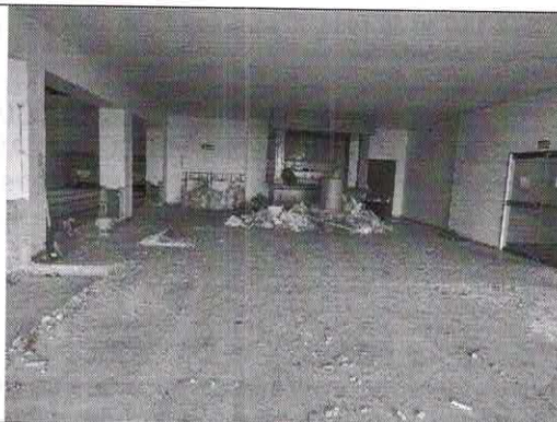
Demolición enchape
