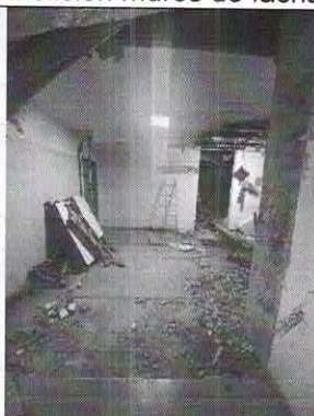
Demolición Baños trabajadores
