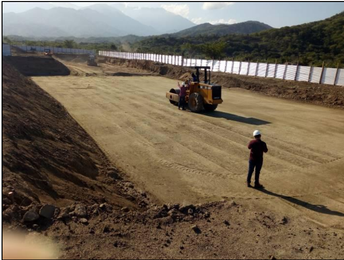
Imagen No. 17. Compactación capa de sub-base de 30cm de espesor.
