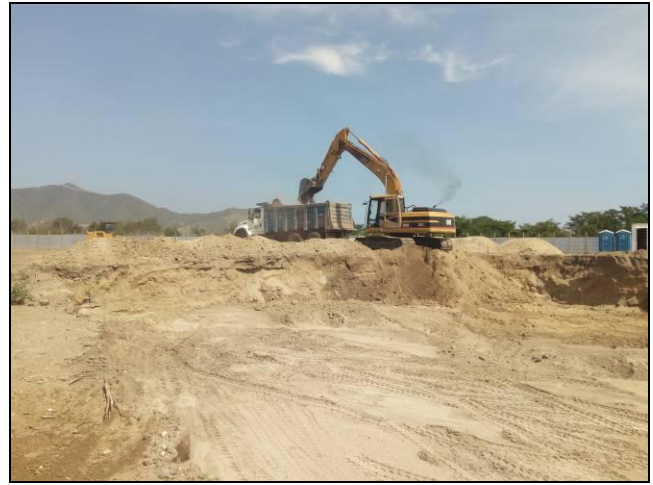
Imagen No. 12. Cargue y transporte proveniente de la excavación.
