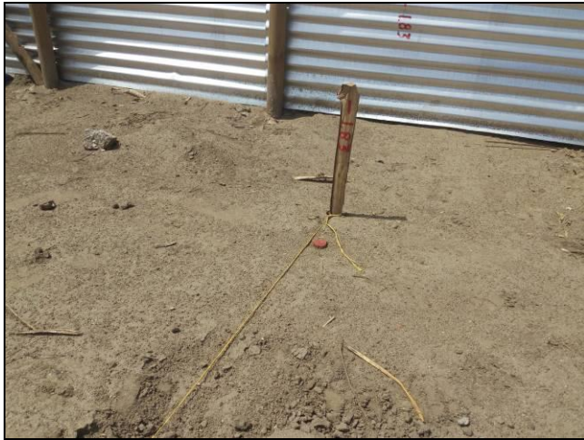
Imagen No. 11. Ubicación de niveles de excavación.
