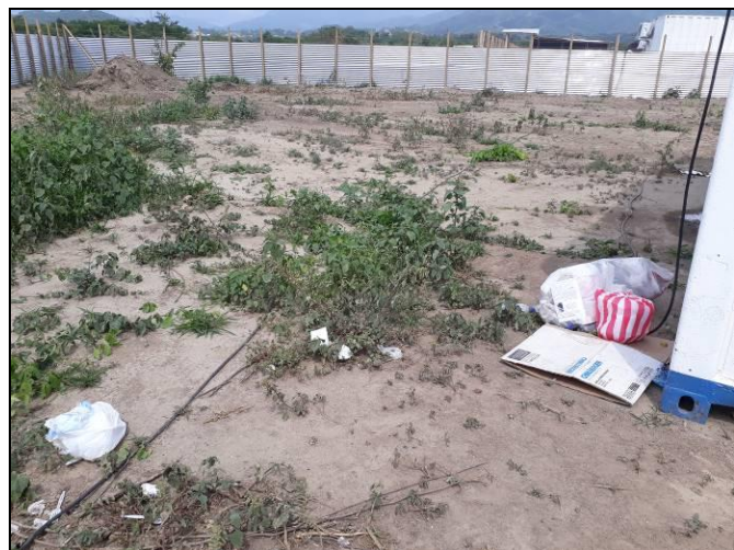
Imagen No. 21. Presencia de residuos en obra por falta de punto ecológico.
