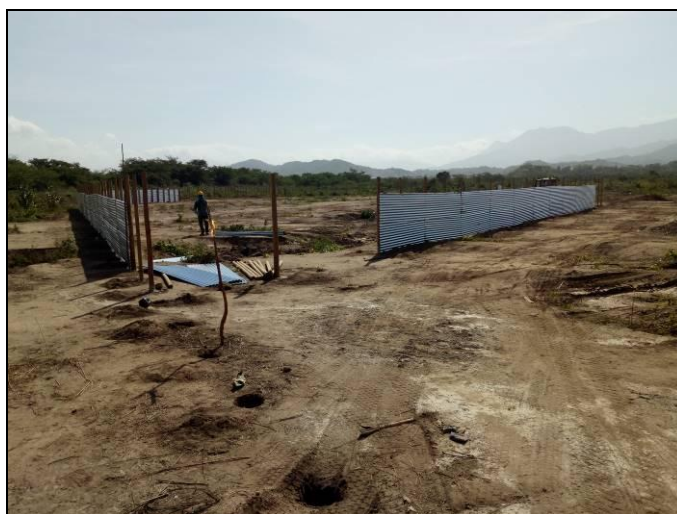
Imagen No. 4. Construcción de cerramiento.
