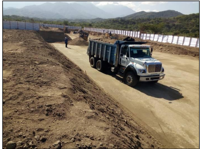
Imagen No. 18. Suministro de material para relleno.
