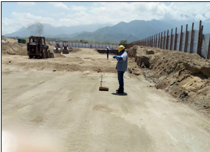
Imagen No. 19. Ensayos de densidad por capa de material.
