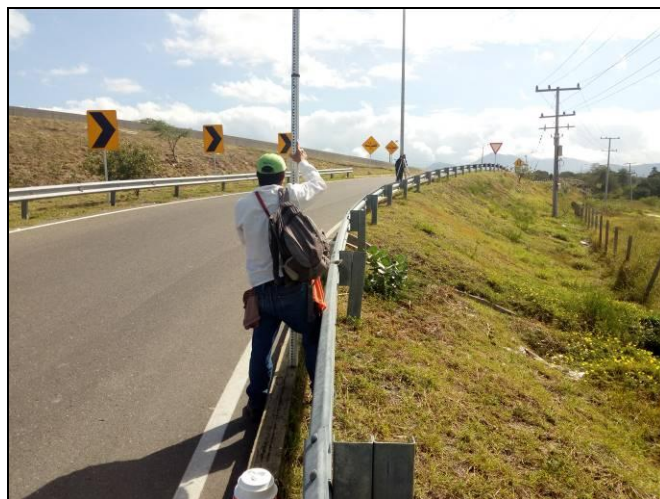
Imagen No. 2. Replanteo topográfico.
