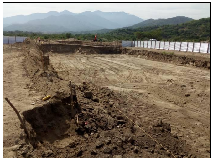
Imagen No. 10. Avance en la actividad de excavación.
