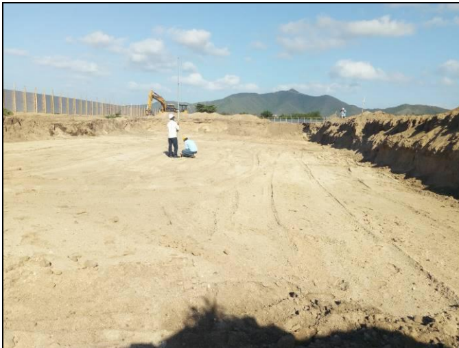
Imagen No. 13. Verificación nivel de excavación.
