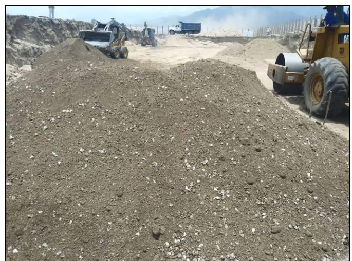
Imagen No. 16. Colocación de material de sub-base para relleno.
