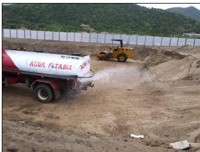
Imagen No. 15. Compactación de terreno en el fondo de la excavación.
