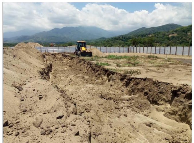
Imagen No. 8. Inicio actividad de excavación.
