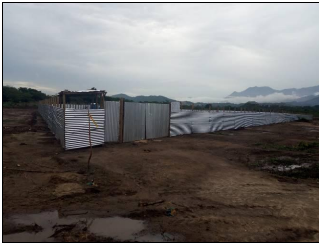
Imagen No. 5. Cerramiento provisional proyecto.
