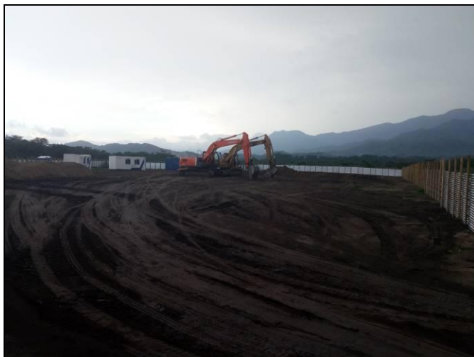
Imagen No. 9. Nivelación de terreno zona de obra.
