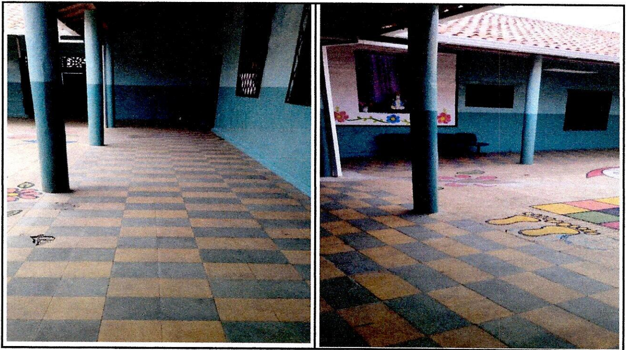
Imagen 18 y Foto 18. Aseo General
