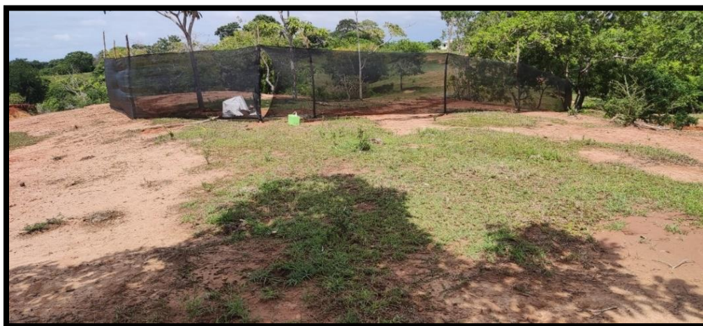
Imágenes. No. 71, No. 72 y No. 32. Disposición final de la Estación Remota (receptor y baterías) en sector rural del municipio de San Bernardo del Viento. Fuente propia.
