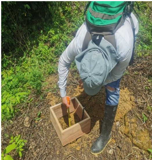
Imagen No. 43. Materialización de vértices geodésicos de 4to. Orden. Fuente propia.
