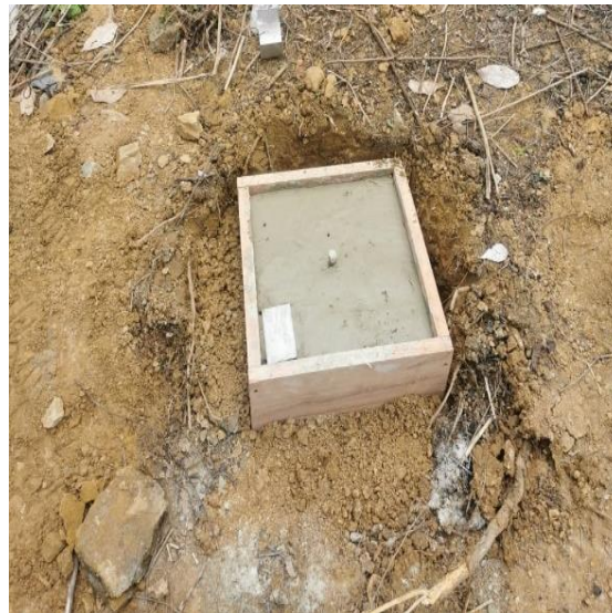
Imagen No. 43. Materialización de vértices geodésicos de 4to. Orden. Fuente propia.
