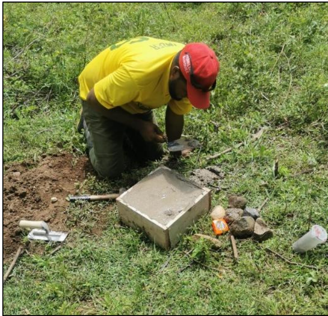
Imagen No. 363. Materialización de vértices geodésicos de 4to orden en el sector El Cerrito y vía Calamar. Fuente propia.
