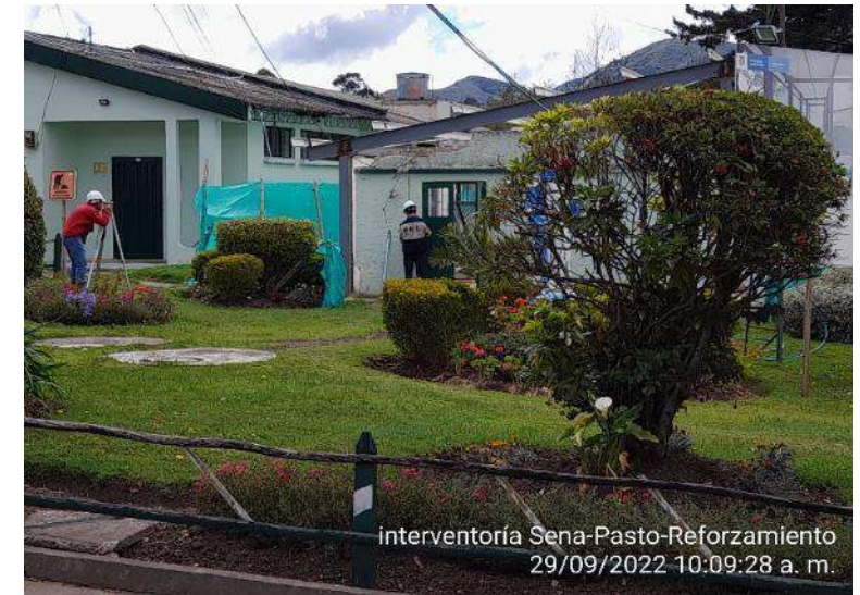
Control de asentamiento con equipo de topografía.
