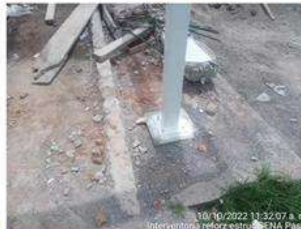
Detalle de columna PTE rellena de ccto 3000psi / platina base pernada/ mortero de nivelación /Pedestal en ccto reforzado
