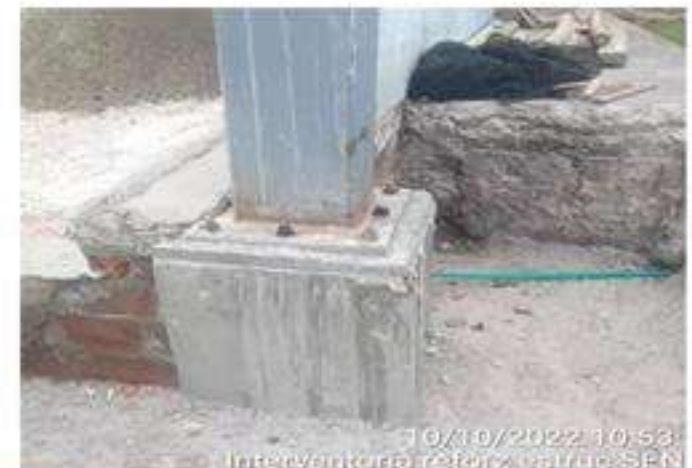
Detalle de columna PTE rellena de ccto 3000psi / platina base pernada/ mortero de nivelación /Pedestal en ccto reforzado
