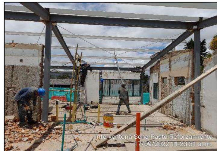
Montaje de estructura metálica reforzamiento correas PHR y contravientos.
