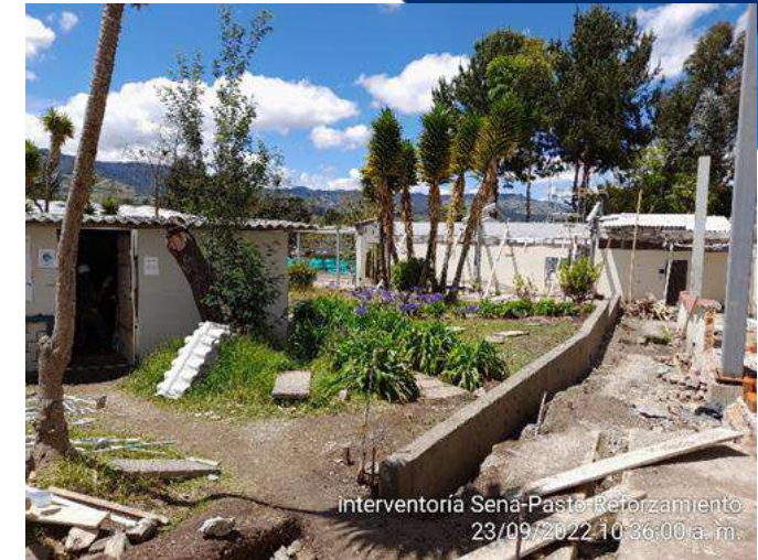
Armado de acero y concreto 3000 psi para muro de contención.
