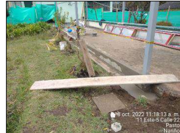
Alistado de pisos con mortero impermeabilizado.
