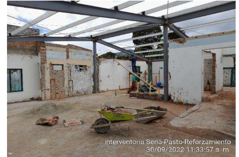
Muros e= 12 cm en ladrillo tolete
