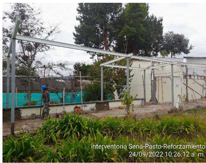
Montaje de estructura metálica (vigas IPE)
