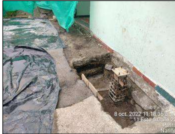
Armado de acero y concreto para zapata.
