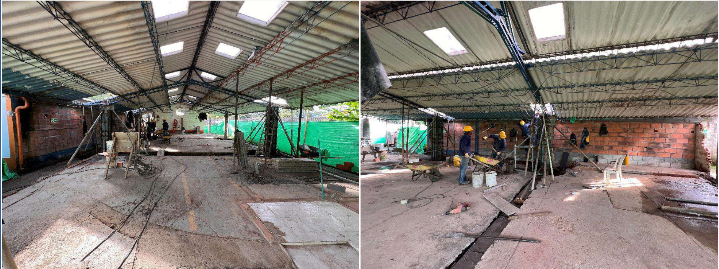
Vista general intervención de reforzamiento estructural edificio 42.
