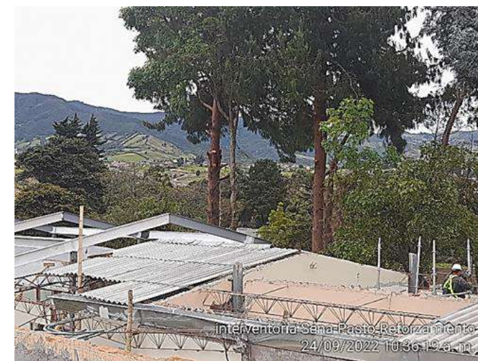
Montaje de estructura metálica (vigas IPE)
