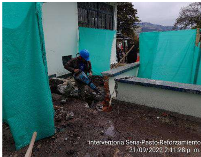
Demolición mecánica y excavación de zapata.
