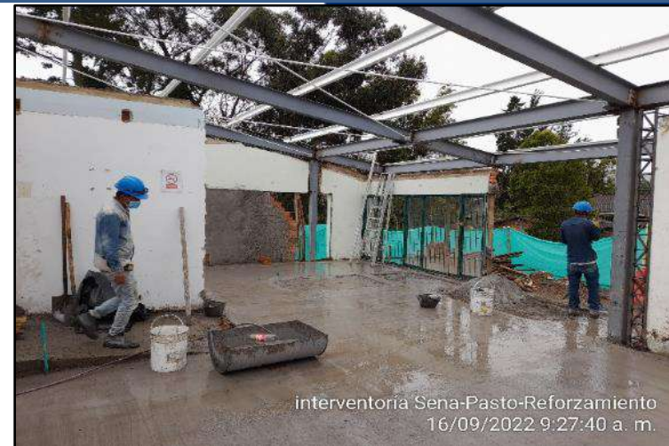
Alistado de pisos con mortero impermeabilizado,
