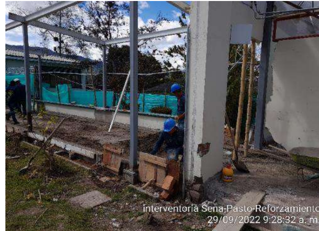
Mortero de nivelación para piso.
