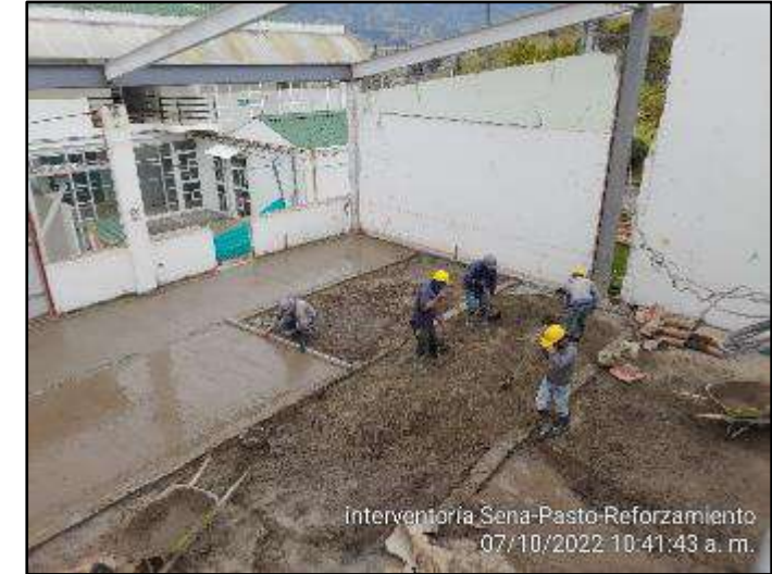
Alistado de pisos con mortero impermeabilizado
