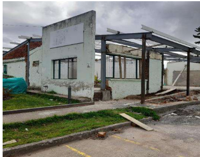
Muros e= 12 cm en ladrillo tolete
