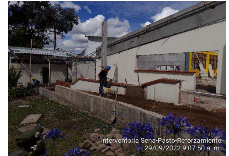
Compactación mecánica de recebo para rampa.
