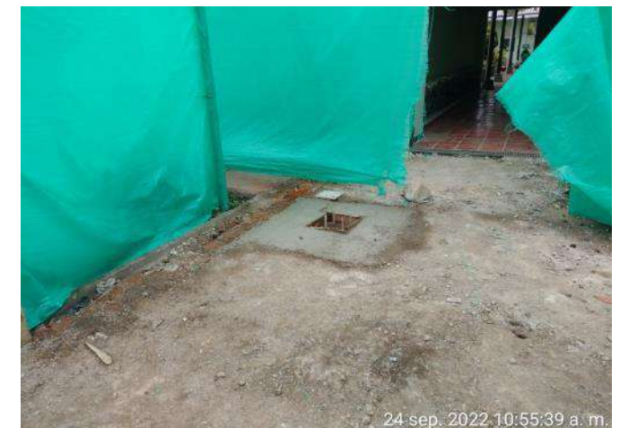
Mortero de nivelación para piso.
