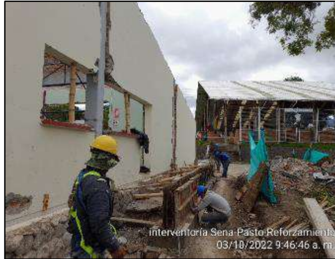
Armado acero y montaje de formaleta para muro de contención.
