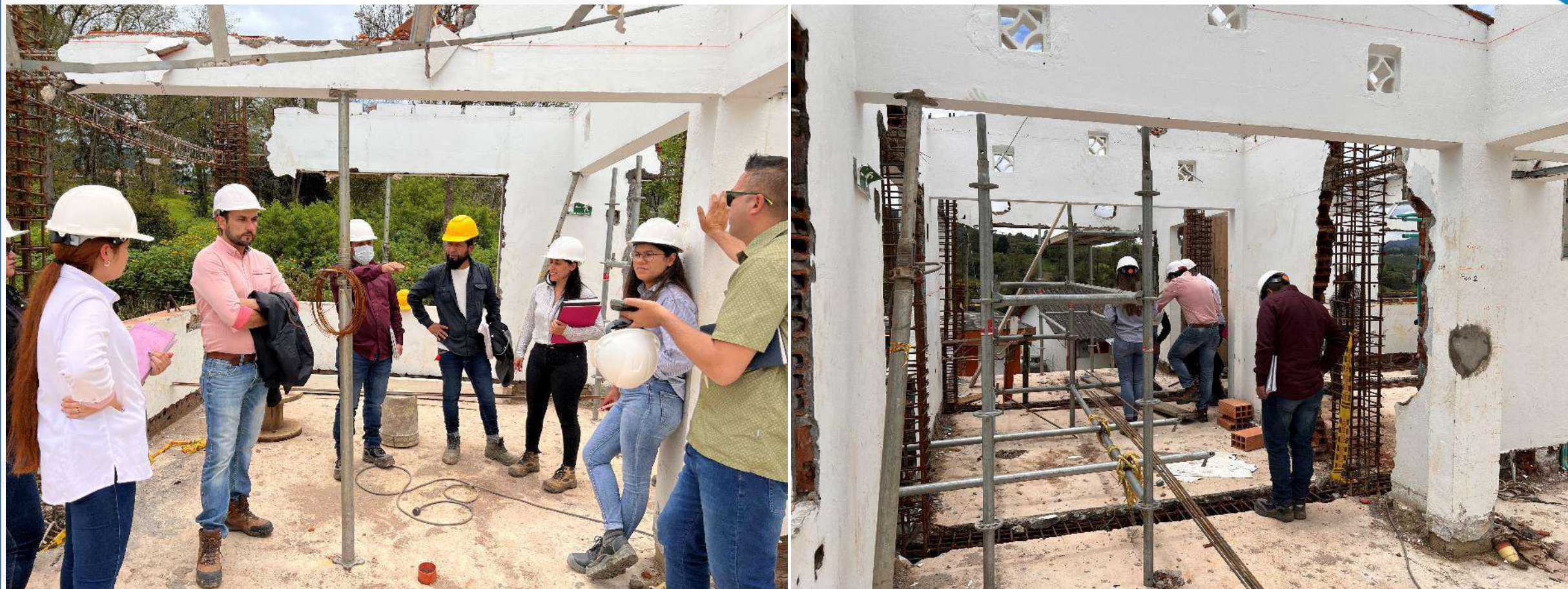
Vista general de intervención de reforzamiento estructural edificio 66.1 y 66.2
