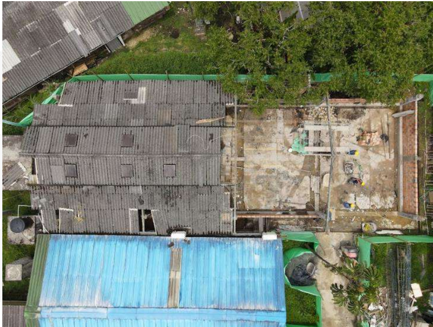
Vista general intervención de reforzamiento estructural edificio 42.
