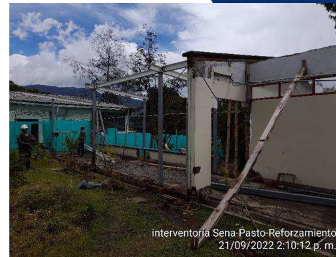
Montaje de estructura metálica (vigas IPE)
