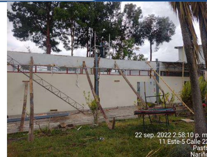
Montaje de estructura metálica (columnas)
