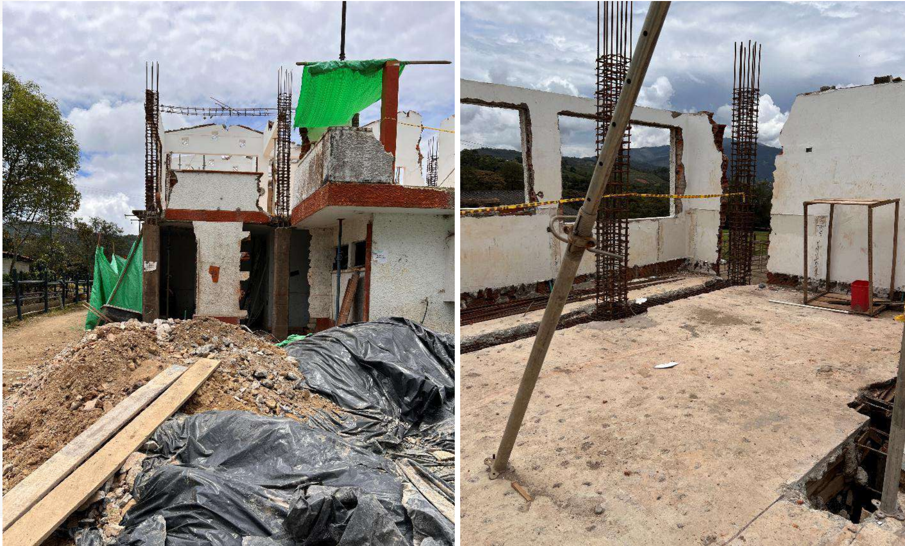
Vista general de la intervención de reforzamiento estructural edificio 66.1 y 66.2
