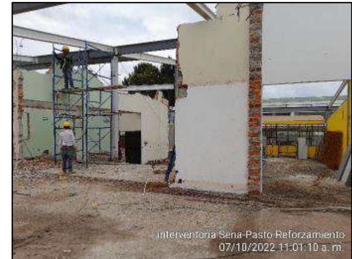
Demolición mecánica de muros internos..
