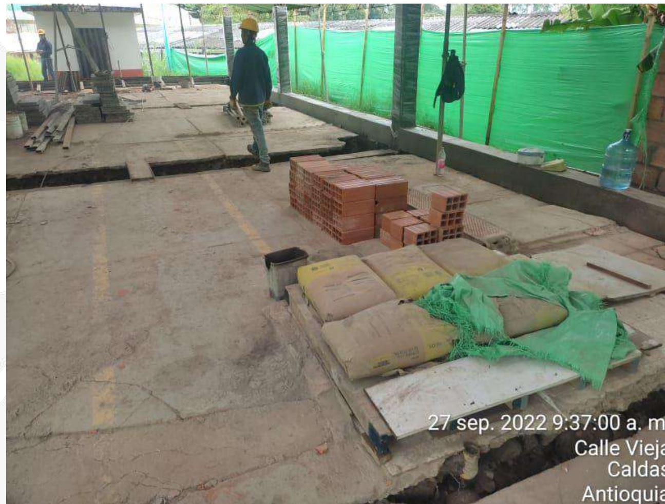
Vista general intervención de reforzamiento estructural edificio 42.
