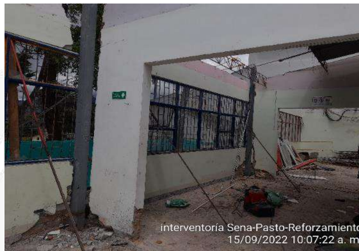
Demolición de muros y columnas para montaje de estructura metálica.
