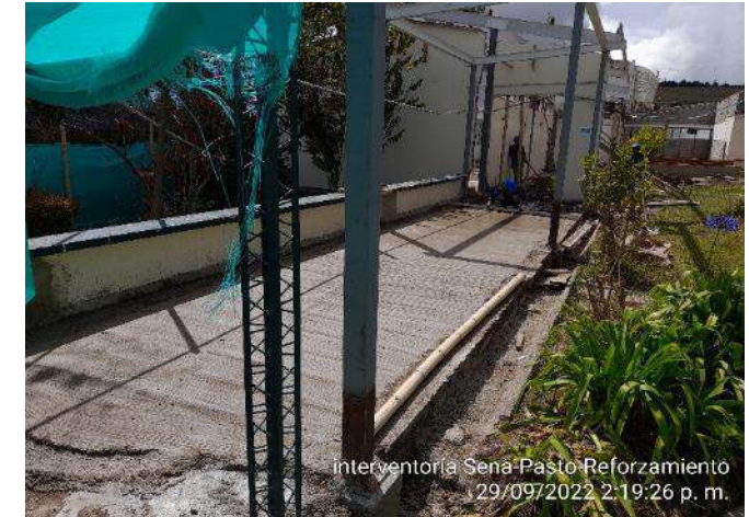
Mortero de nivelación para piso.
