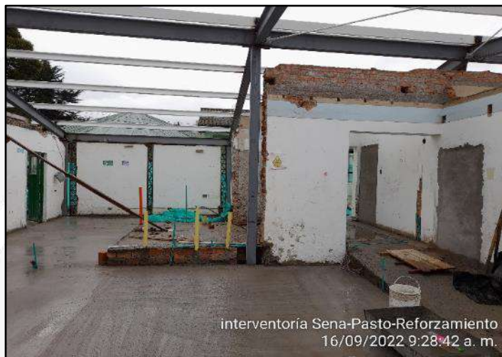
Alistado de pisos con mortero impermeabilizado
