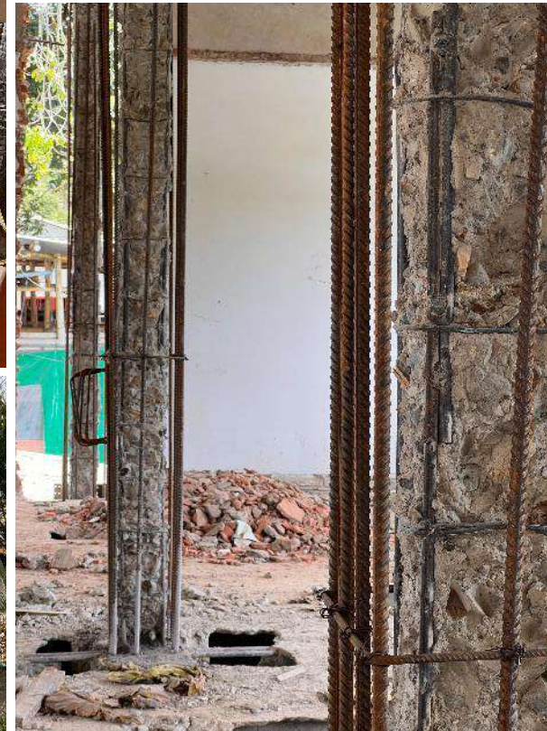
Vista general intervención de reforzamiento estructural edificio 16,1 y 16,2.
