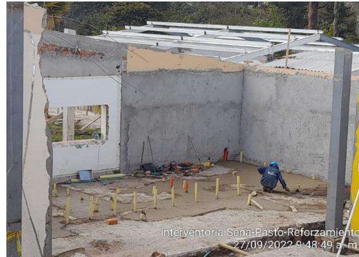
Concreto 3000 psi para contrapiso.
