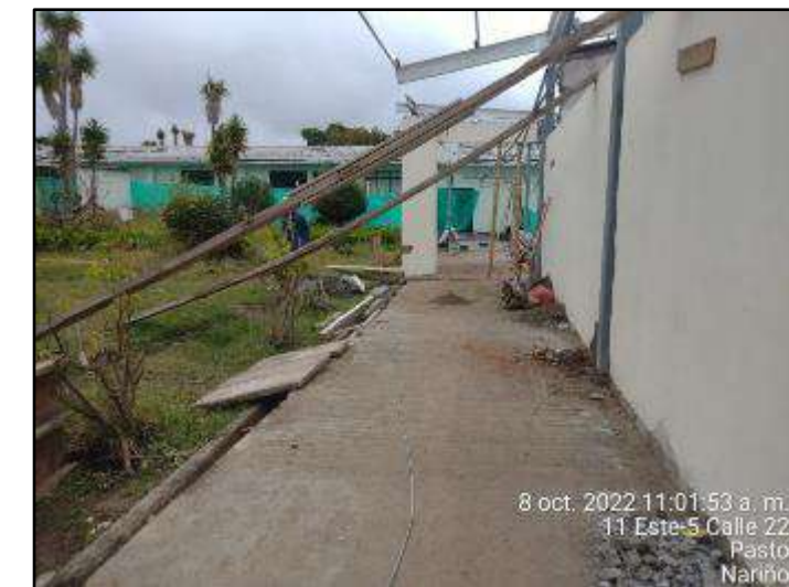
Alistado de pisos con mortero impermeabilizado
