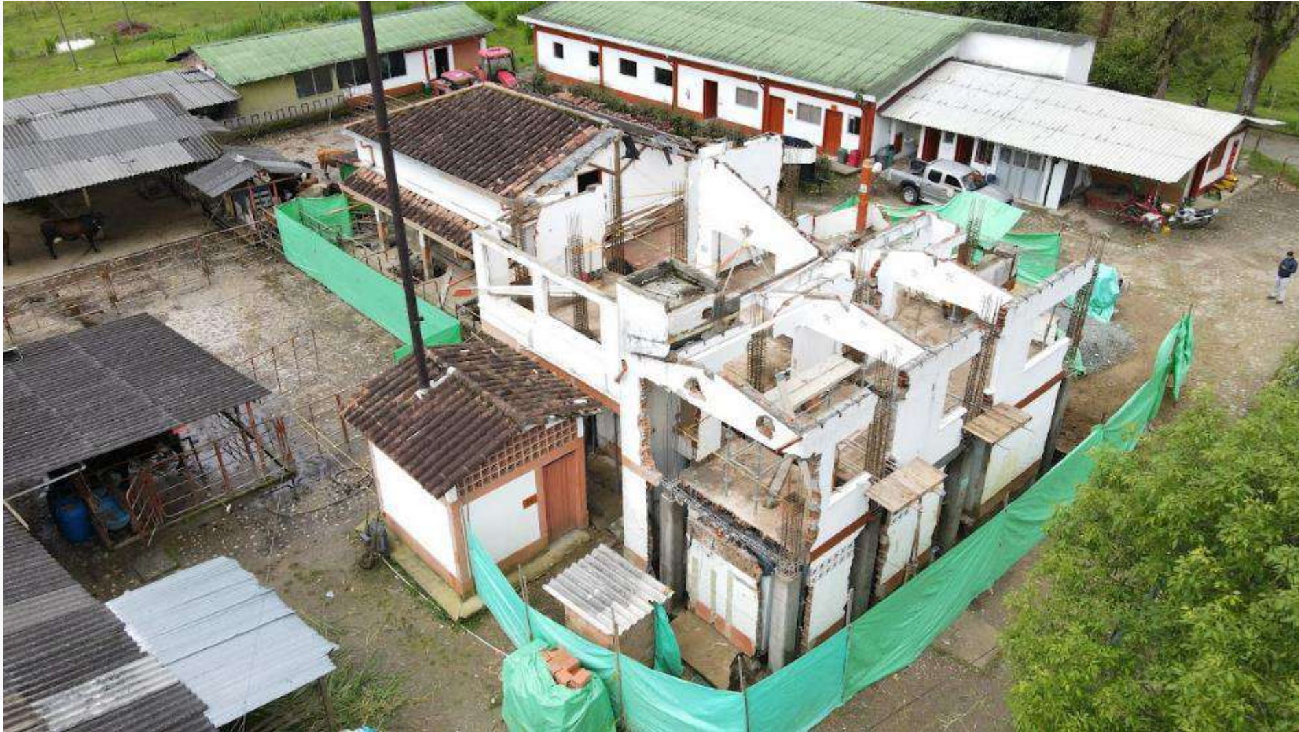
Vista general intervención de reforzamiento estructural edificio 42.
