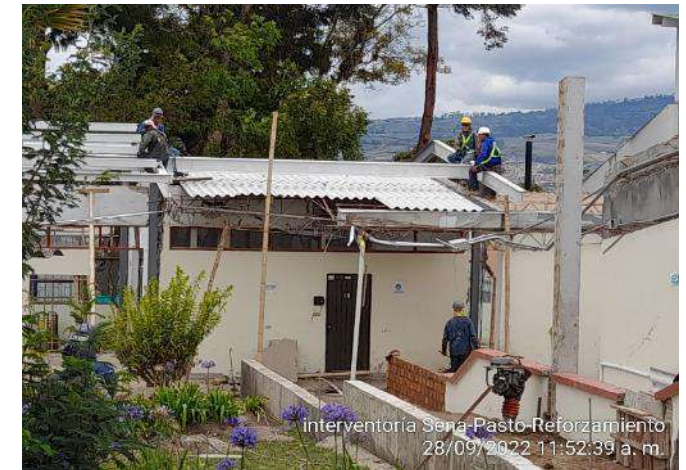
Montaje de estructura metálica (vigas IPE)
