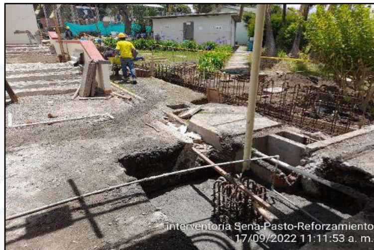
Concreto premezclado 3000 psi para zapatas.
