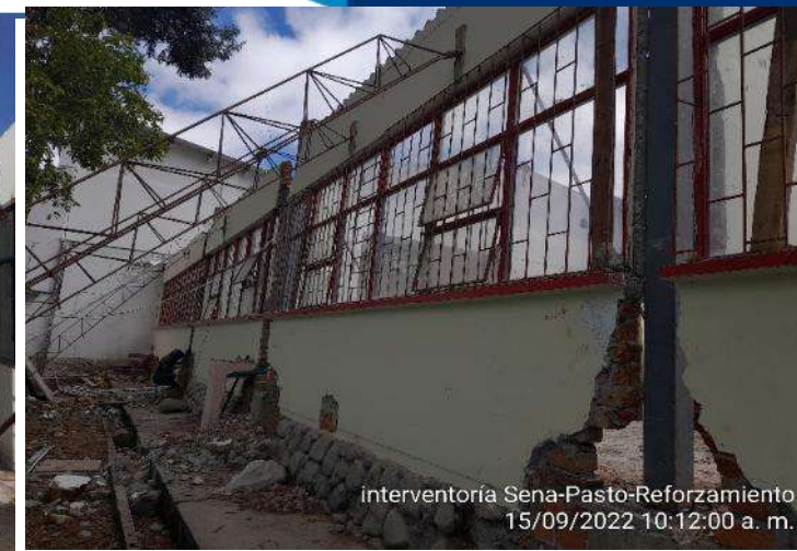
Montaje de estructura metálica (columnas)
