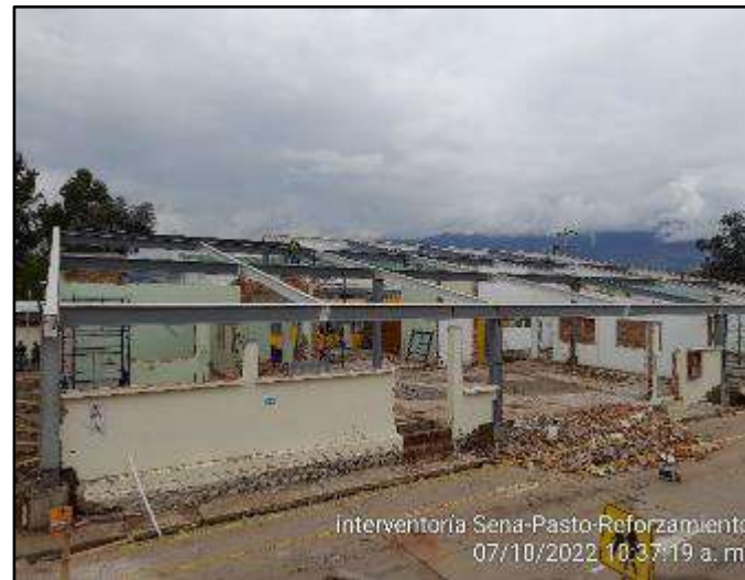
Montaje de estructura metálica (vigas IPE 360) .
