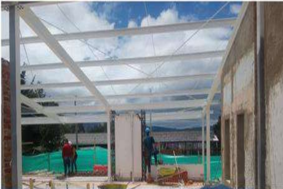
Vista general cubierta vigas IPE 240 –correas PHR C-150 – Contravientos - Tensores
