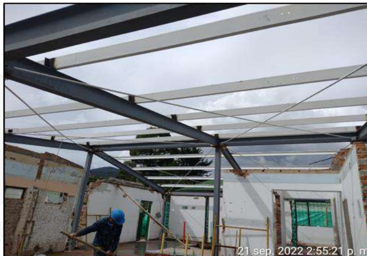
Reforzamiento de correas PHR y contravientos.
