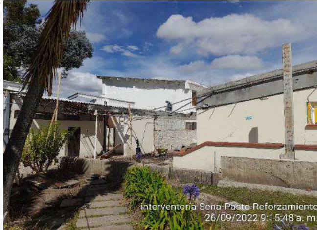
Demolición mecánica de muros y columnas
