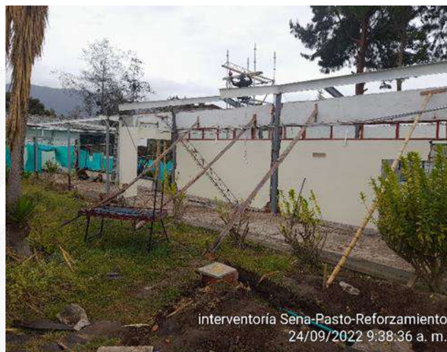
Montaje de estructura metálica (vigas IPE)
