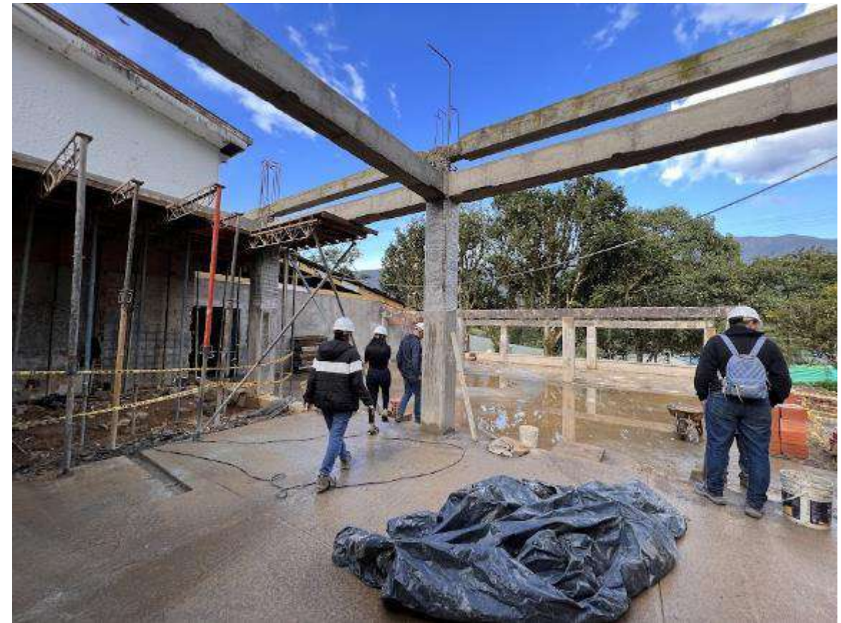
Vaciado de concretos en vigas y losas aéreas en edificio 16.
