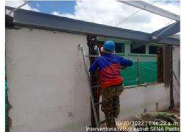
Construcción de Muros e= 12 cm en ladrillo tolete común.
