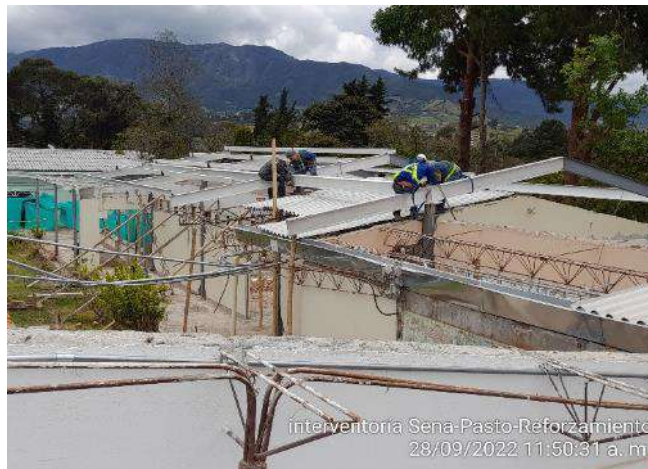
Montaje de estructura metálica (vigas IPE)
