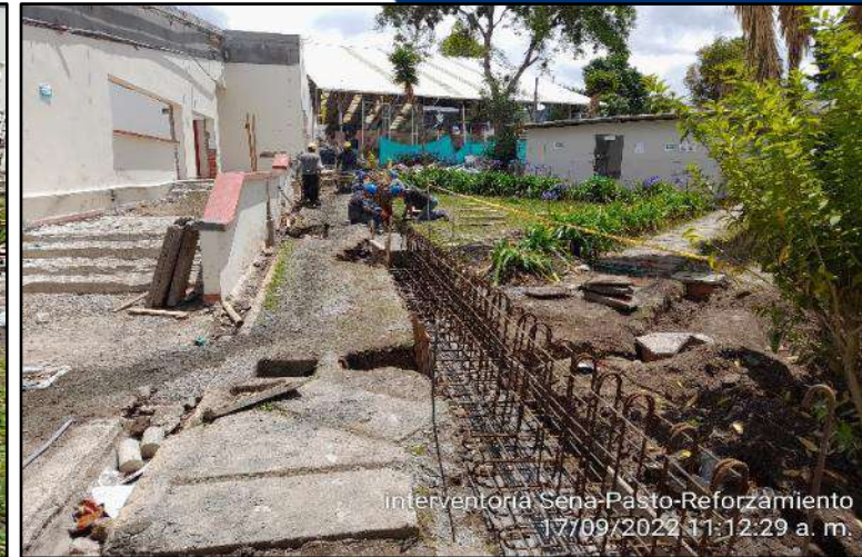
Excavación , mejoramiento y armado de acero para muro de contención.
