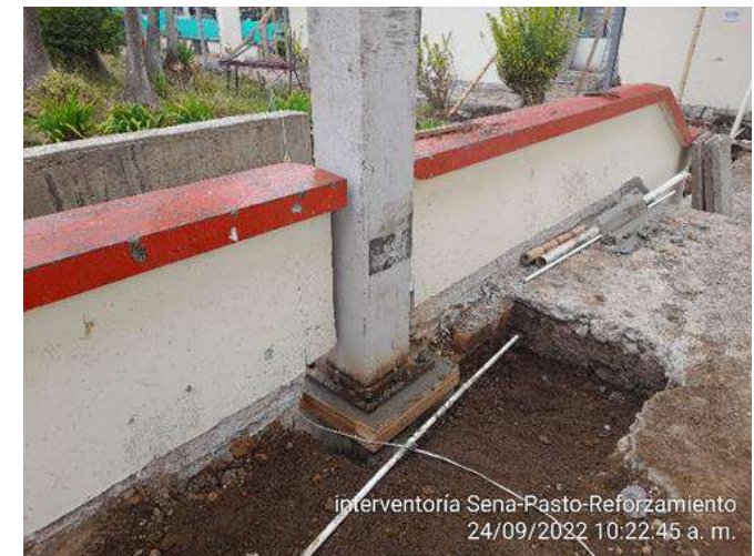
Armado de acero y concreto 3000 psi para muro de contención.
