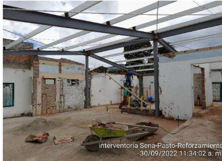
Muros e= 12 cm en ladrillo tolete.
