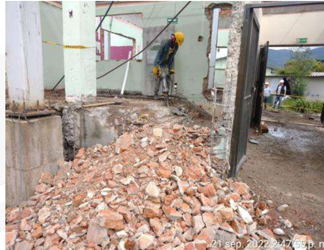
Demolición mecánica de concreto.
