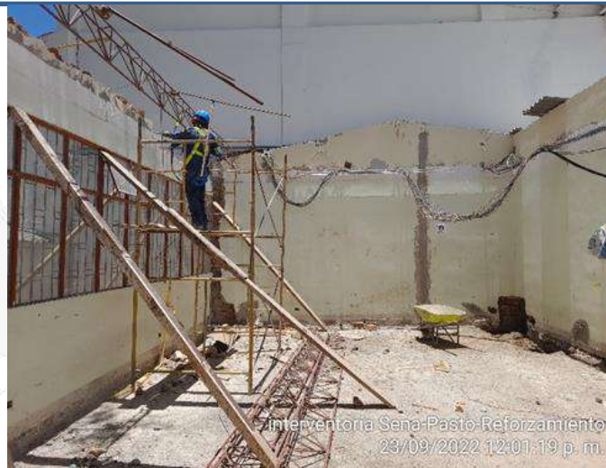
Demolición de muros y columnas para montaje de estructura metálica.
