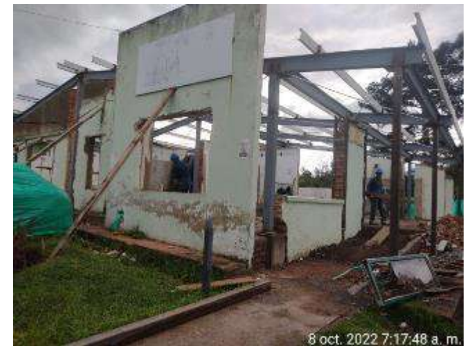
Desmonte de ventaneria.
