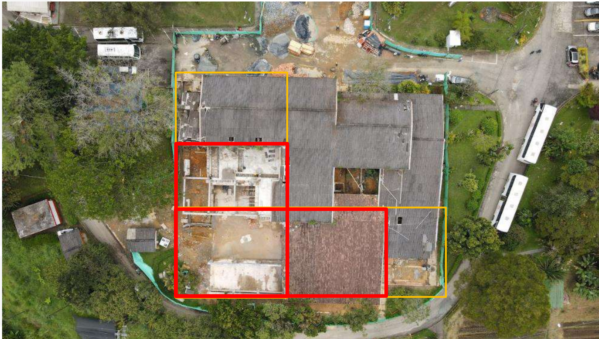
Actividades desarrolladas en edificio bloque 16.
