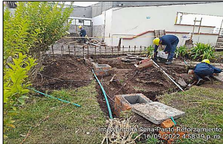
Suministro e Instalación de Sistema puesta a Tierra
