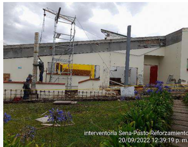
Demolición mecánica de concreto.
