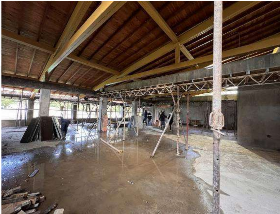
Vaciado de concretos en vigas y losas aéreas en edificio 16.
