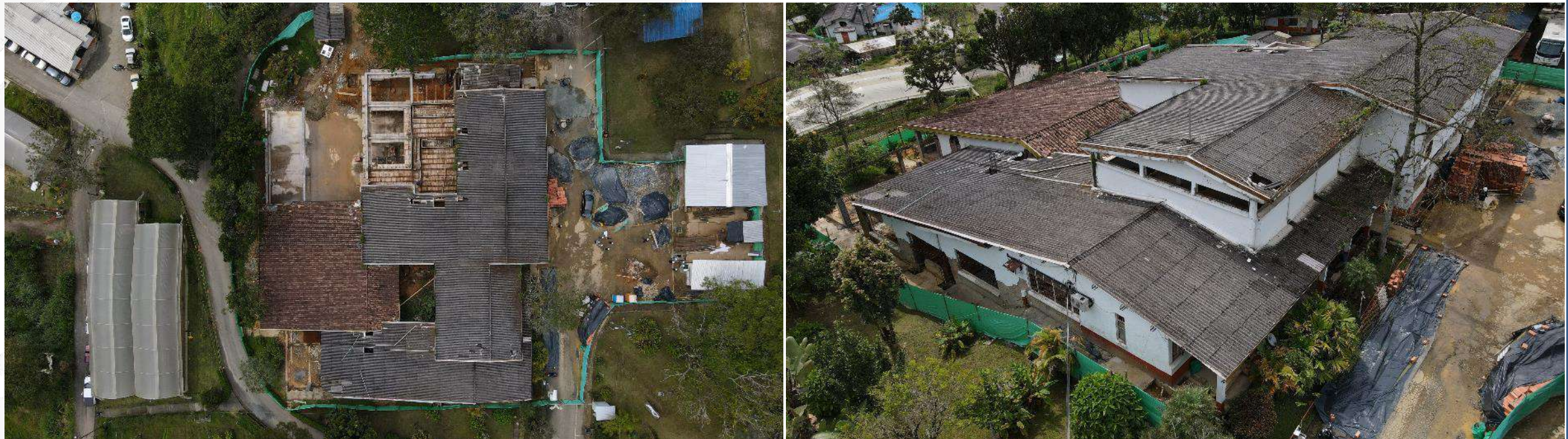
Vista aérea intervención de reforzamiento estructural edificio 16,1 y 16,2.
