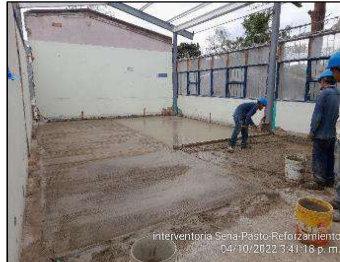
Alistado de pisos con mortero impermeabilizado
