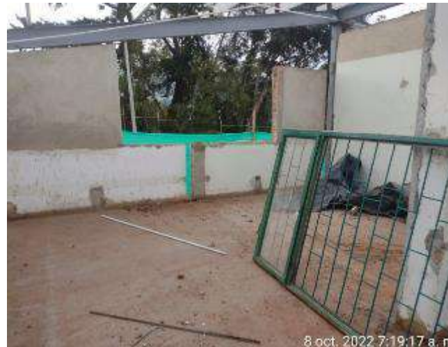
Desmonte de ventaneria.
