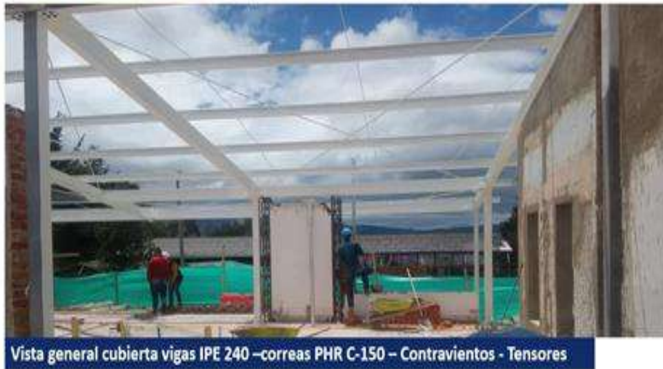
1. Estado de la estructura metálica autoportante de reforzamiento y cubierta NP-1.
