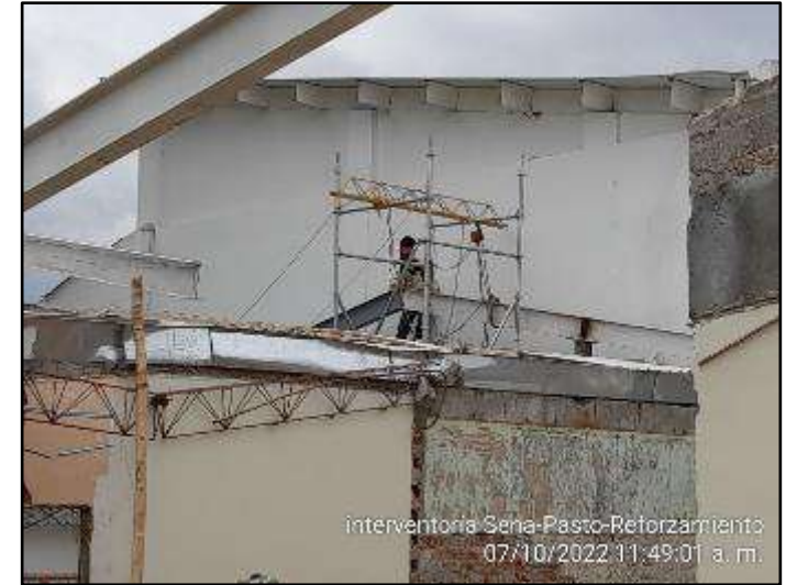
Montaje de estructura metálica (vigas IPE)
