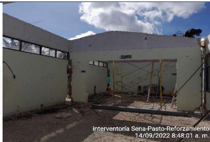
Demolición de muros y columnas para montaje de estructura metálica.
