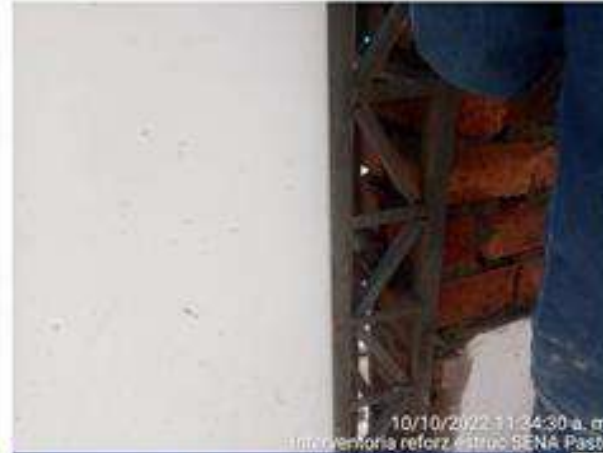
Construcción de Muros e= 12 cm en ladrillo tolete común.
