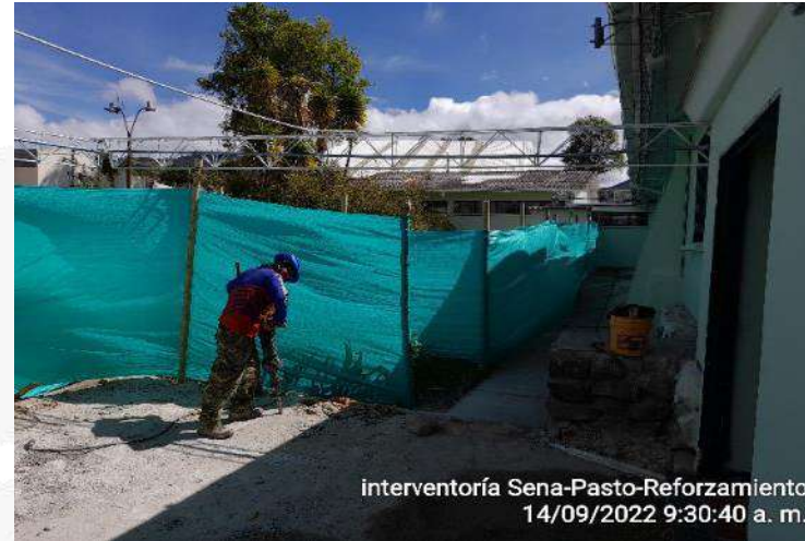
Relleno manual con recebo B-200. Incluye extendido
