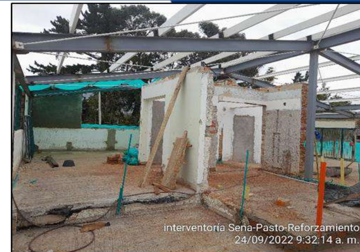
Reforzamiento de correas PHR y contravientos.
