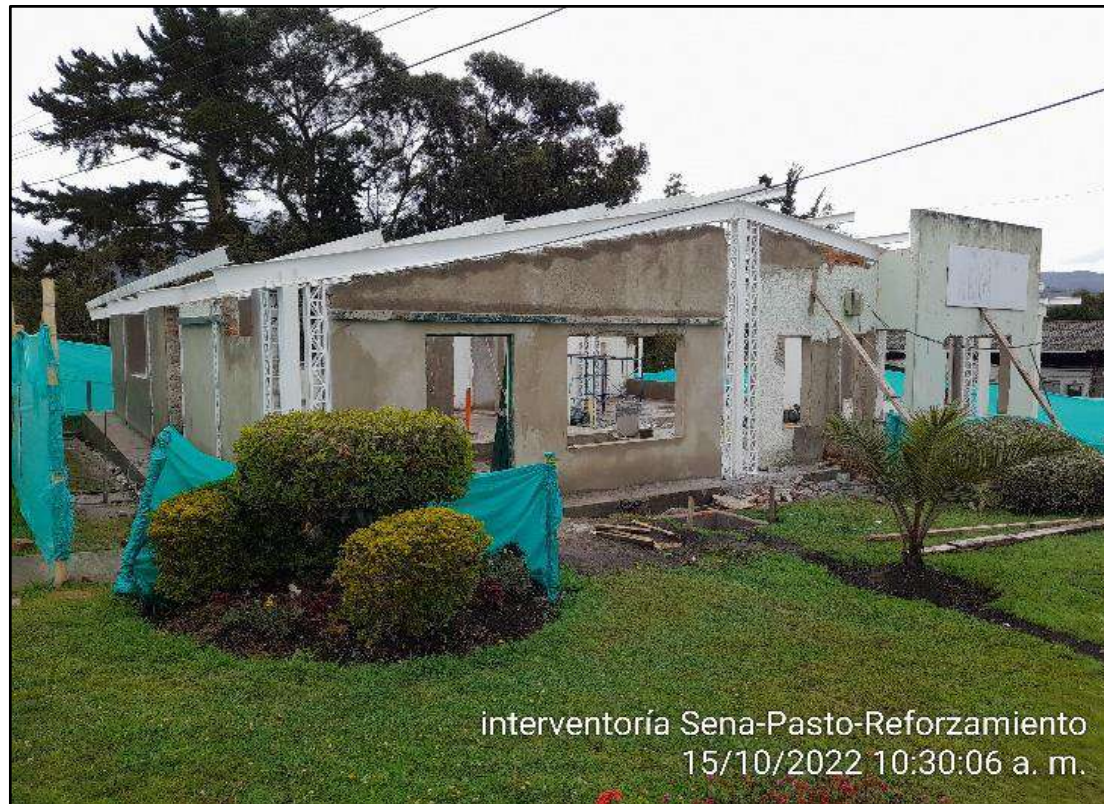
Montaje de columnetas para confinamiento de muros
