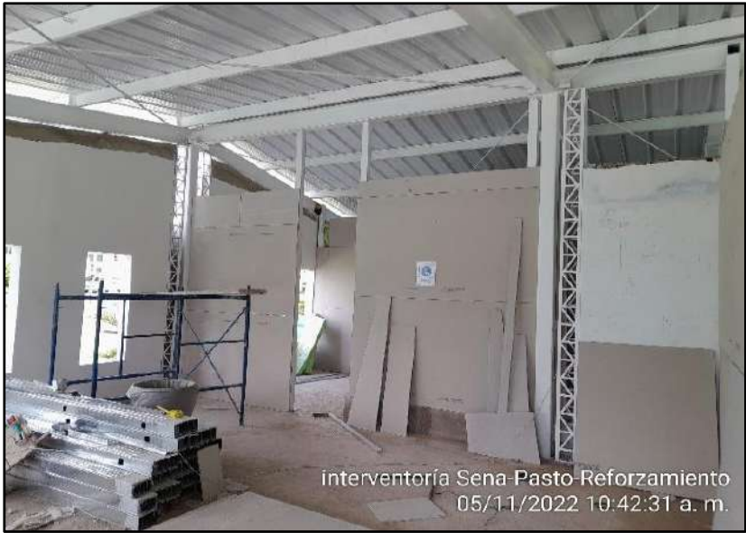
Construcción de muros livianos en fibrocemento
