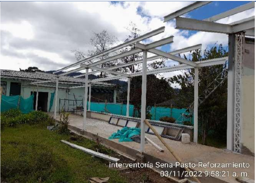
Montaje de estructura metálica(aplicación de pintura anticorrosiva correas.)
