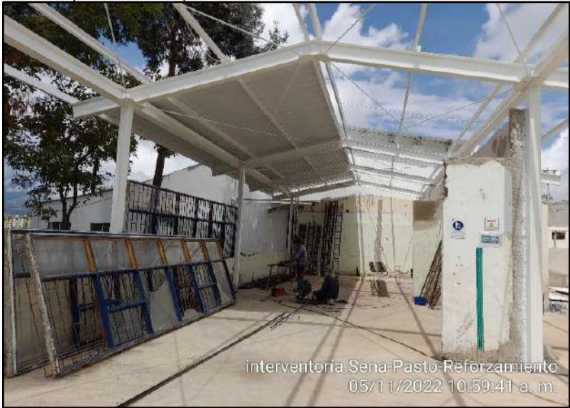
Montaje de teja upvc para cubierta.
