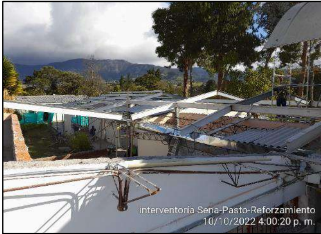
Montaje de estructura metálica (vigas IPE)
