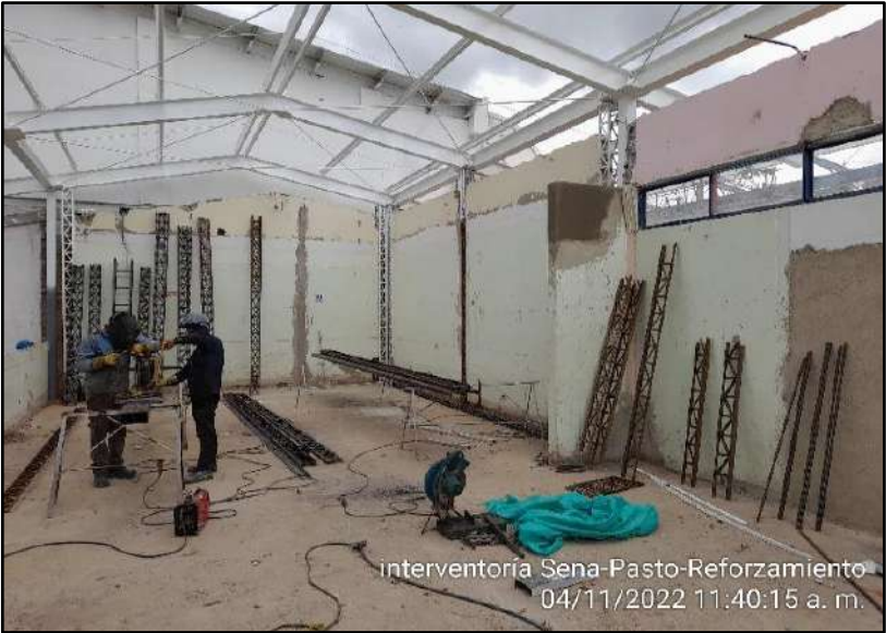
Montaje de estructura metálica para columnetas de confinamiento.
