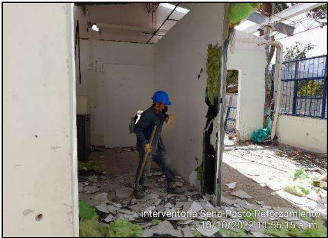
Demolición de muro
