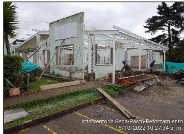
Muros e= 12 cm en ladrillo tolete
