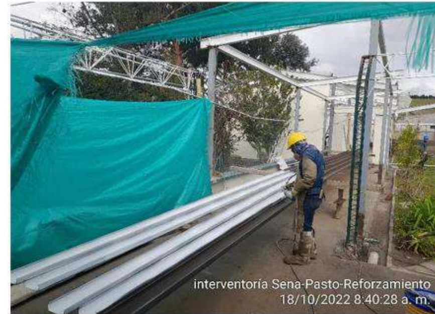
Aplicación de pintura anticorrosiva correas
