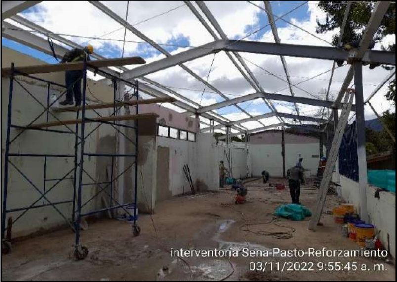
Aplicación de pintura anticorrosiva en la estructura metálica (cerchas PHR, tensores y contravientos.)
