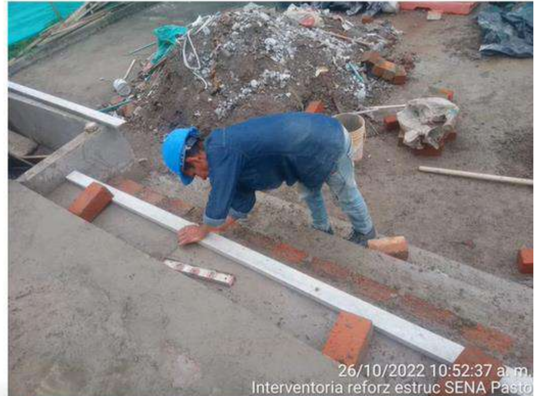
Alistado de pisos con mortero impermeabilizado –filos en escaleras
