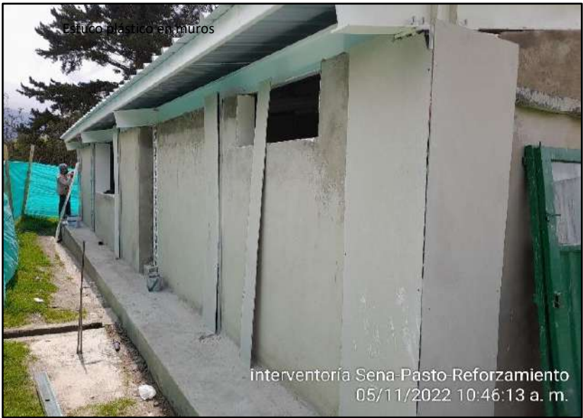
Montaje de estructura y laminas de fibrocemento para revestimiento de columnetas de confinamiento
