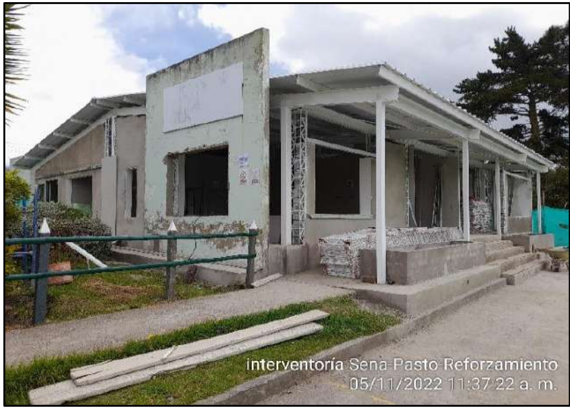
Instalación de teja upvc para cubierta
