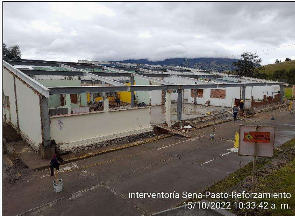
Montaje de estructura metálica (vigas IPE 360) .
