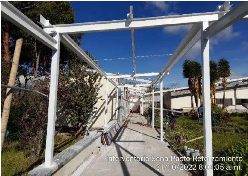
Montaje de estructura metálica(reforzamiento vigas IPE 160)
