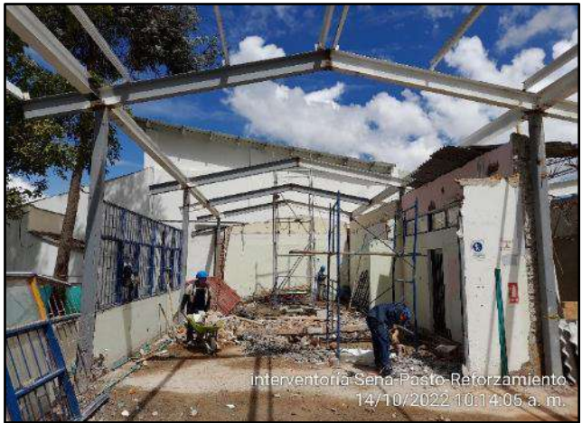
Demolición de muro y acarreo de material
