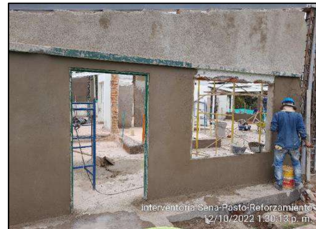
Pañetes sobre Muros
