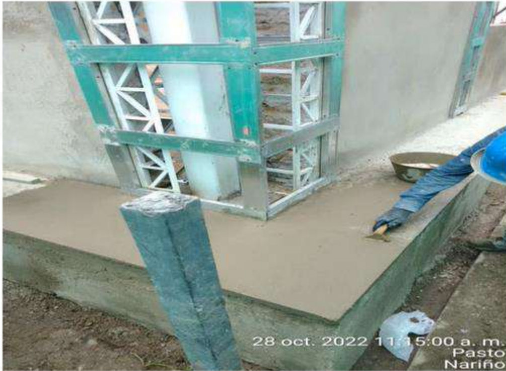
Alistado de pisos con mortero impermeabilizado –filos en andenes
