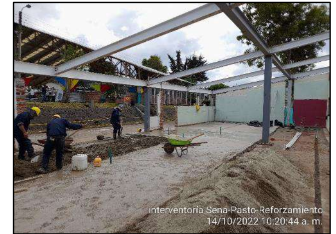
Alistado de pisos con mortero impermeabilizado
