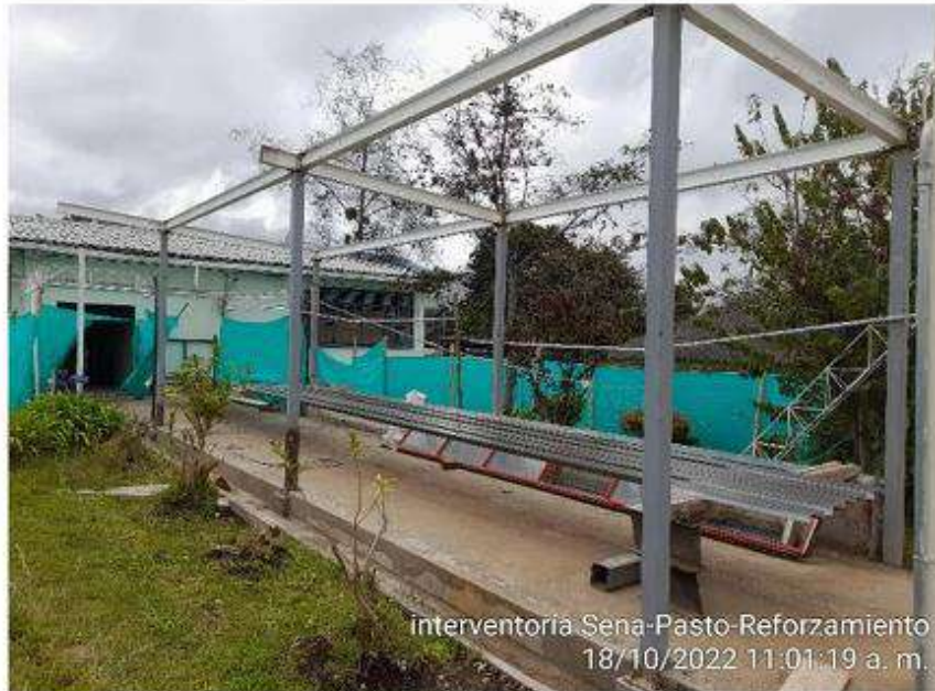
Soldadura en estructura metálica
