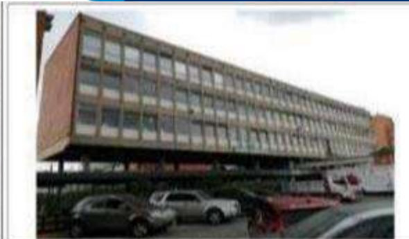
Fotografía 4. Parte de la fachada de la Torre Oriental
