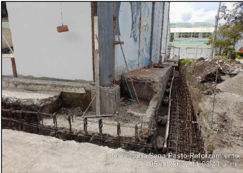
Armado de acero para muro de contención
