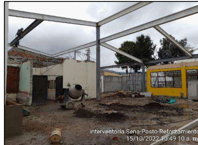
Montaje de estructura metálica (vigas IPE 360) .
