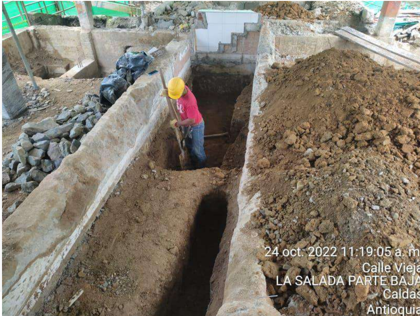
Vista general intervención de reforzamiento estructural edificio 42.
