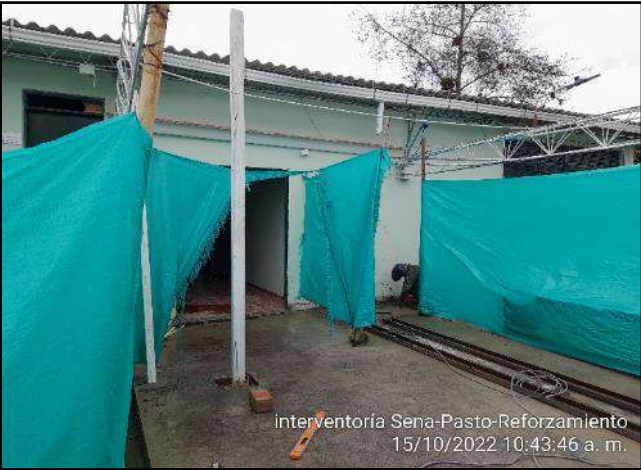
Montaje de estructura metálica (columna 100x100x6mm)
