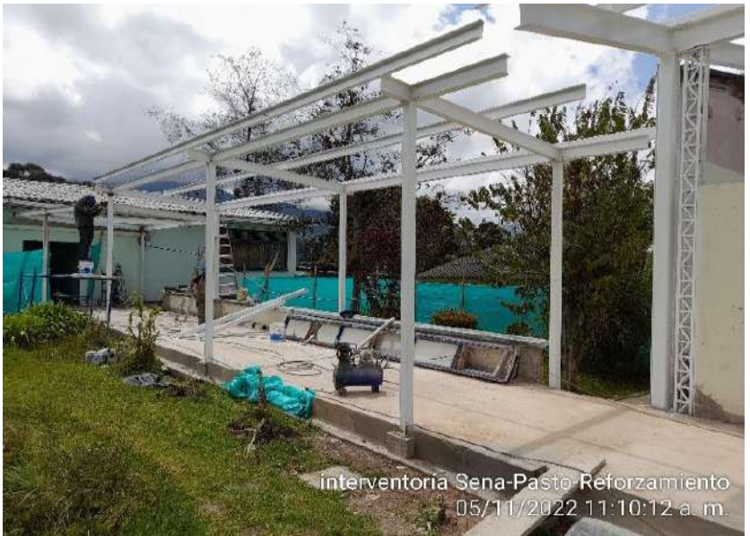
Montaje de estructura metálica (reforzamiento vigas IPE 160)
