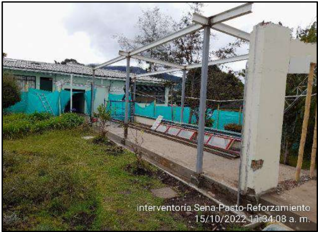
Montaje de estructura metálica (reforzamiento vigas IPE 160)
