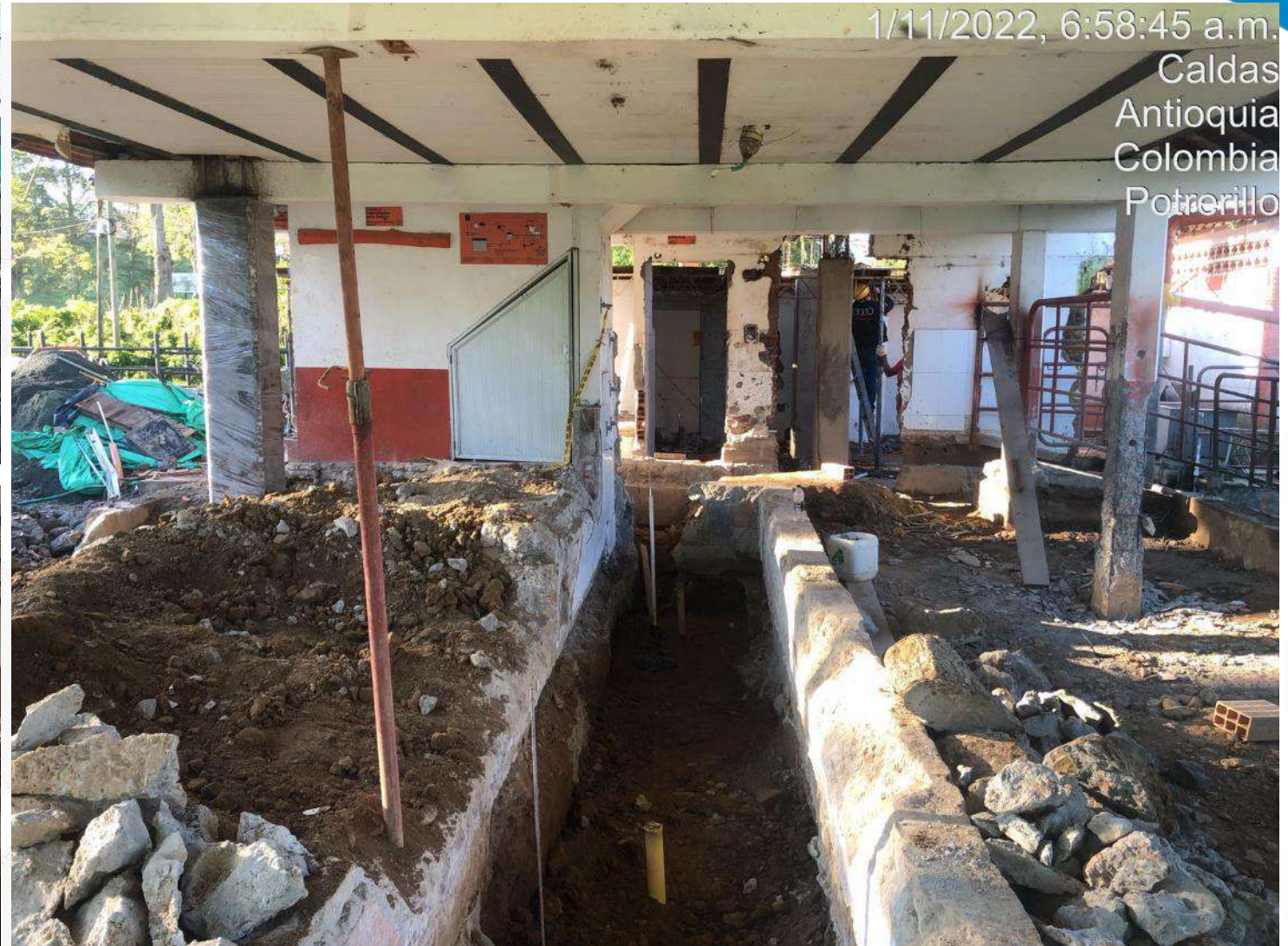
Vista general intervención de reforzamiento estructural edificio 42.
