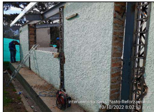
Montaje de columnetas para confinamiento de muros
