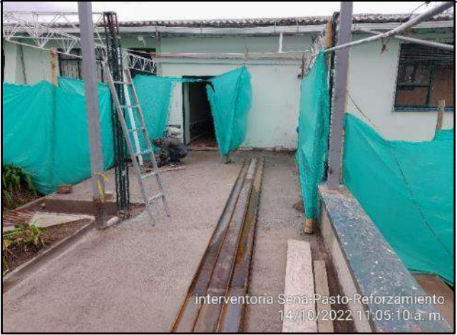
Montaje de estructura metálica (columna 100x100x6mm)
