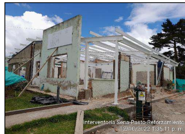
Pintura con anticorrosivo blanco, estructura autoportante.
