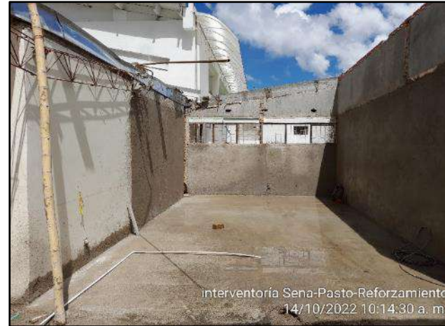
Pañetes sobre Muros
