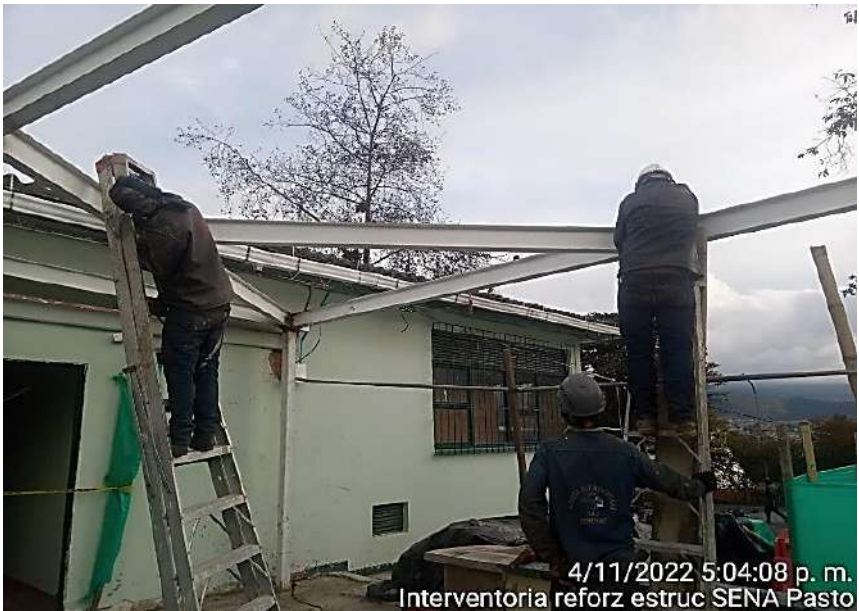
Montaje de estructura metálica (reforzamiento vigas IPE 160)
