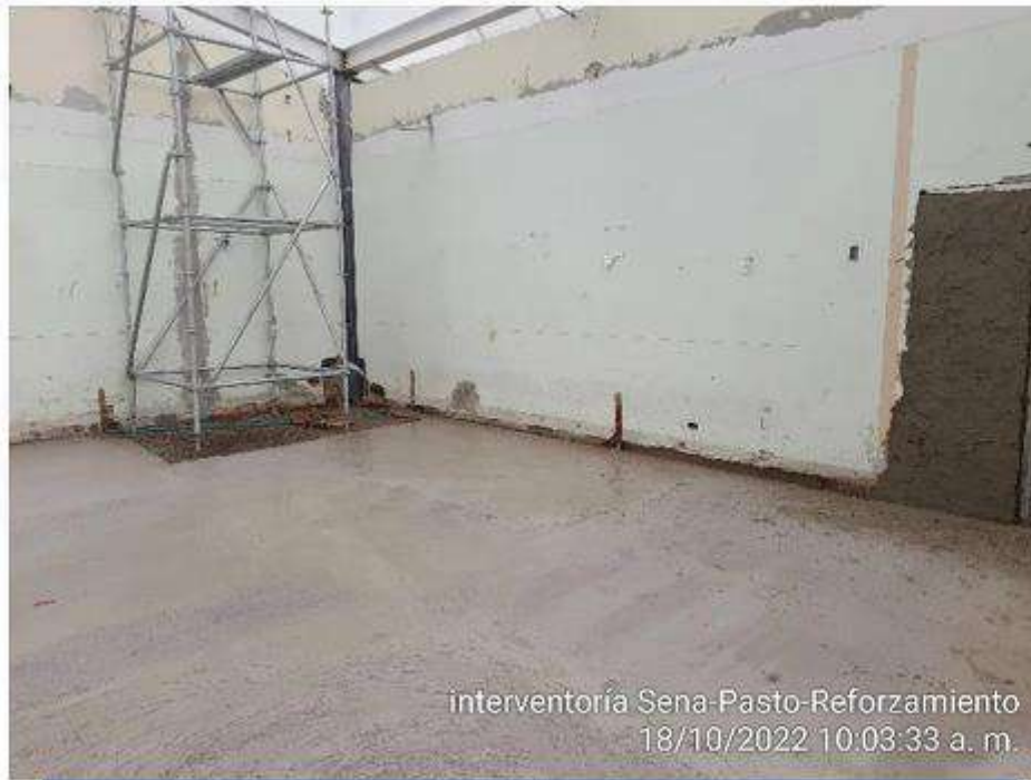
Alistado de pisos con mortero
