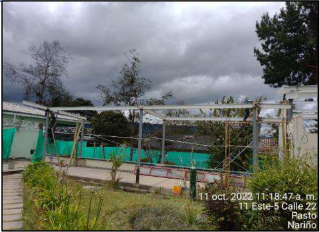
Montaje de estructura metálica (columna 100x100x6mm)
