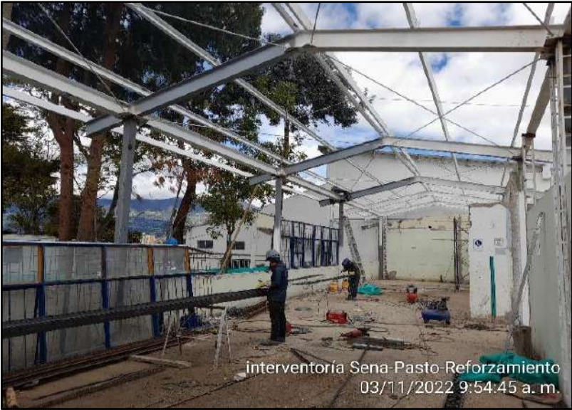
Montaje de estructura metálica (cerchas PHR, tensores y contravientos.)
