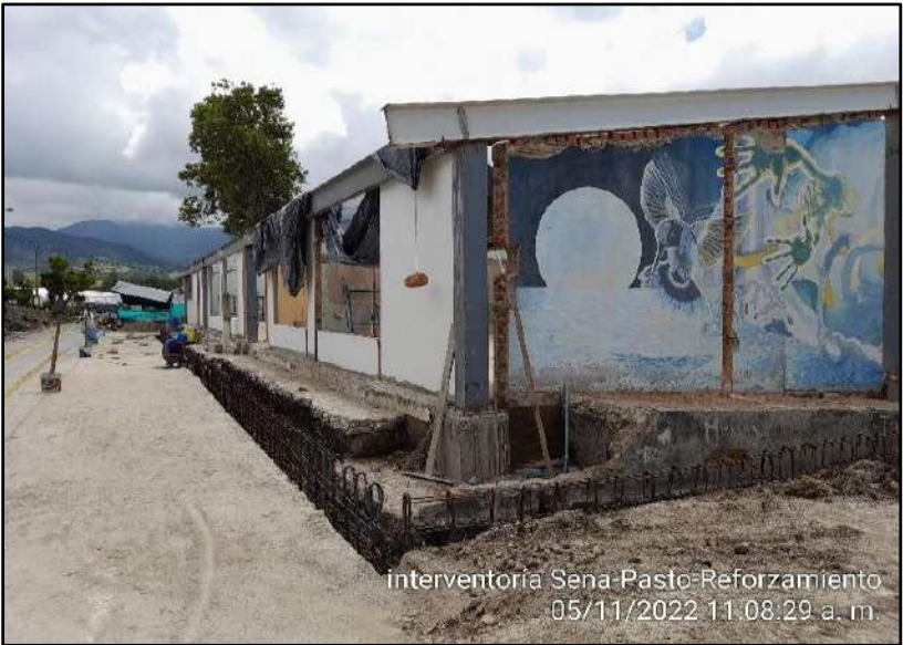
Armado de acero para muro de contención
