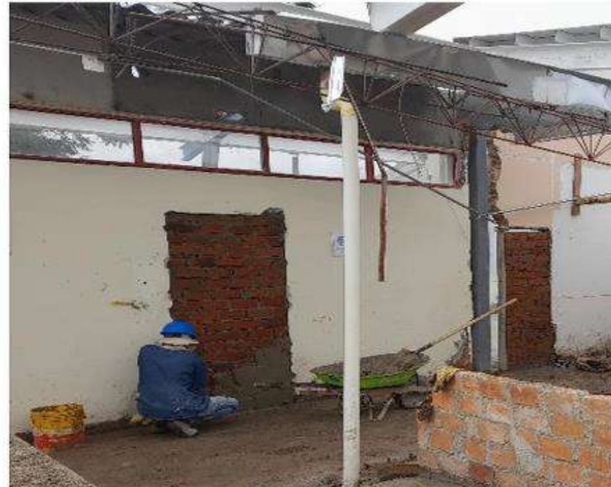
Muros de mampostería
