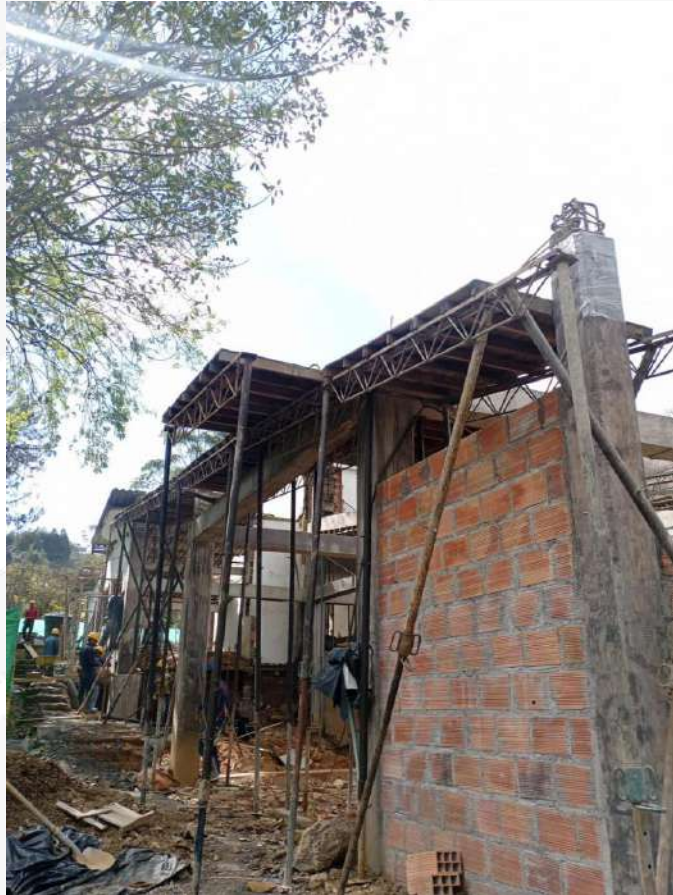
Vista general intervención de reforzamiento estructural edificio 42.
