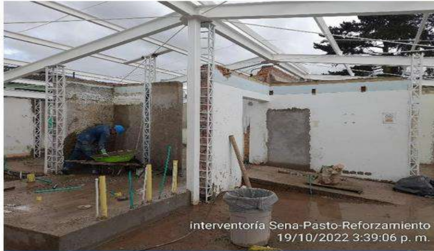
Pañete liso común 1:3 sobre muros
