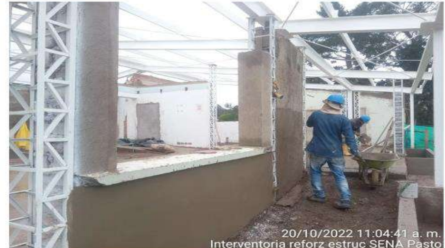
Pañete liso común 1:3 sobre muros
