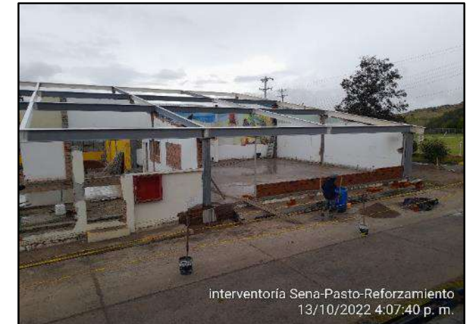
Alistado de pisos con mortero impermeabilizado
