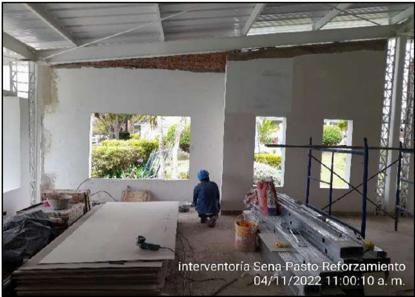
Estuco plástico en muros
