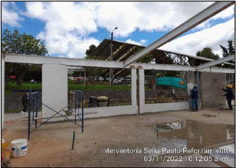
Estuco plástico muros internos
