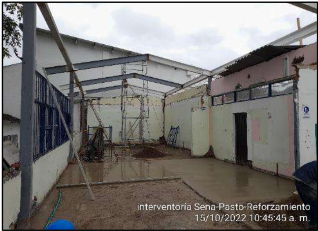
Alistado de pisos con mortero impermeabilizado
