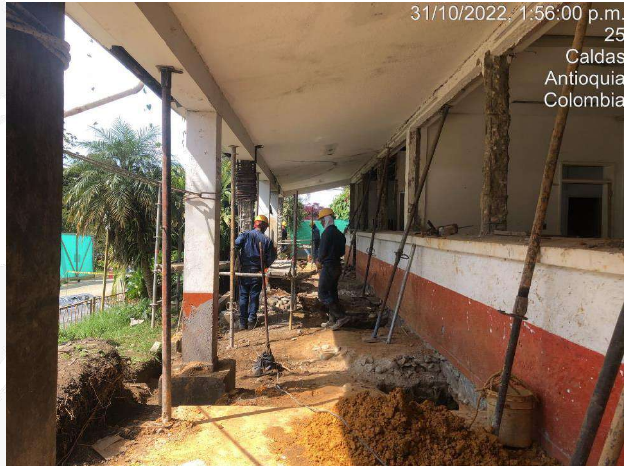
Actividades desarrolladas en edificio bloque 16
