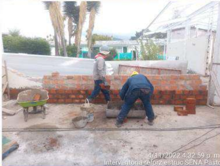
Muro de mampostería en ladrillo tolete común.
