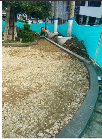
Fotografía 12: mejoramiento de piso con material de afirmado
