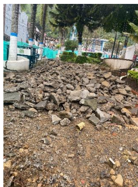
Fotografía 6: demolición andén y bordillo en concreto
