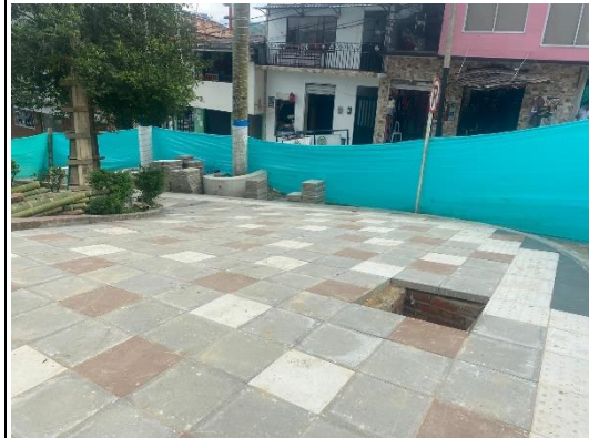
Fotografía 18: construcción de andén con loseta de colores y línea de toperol
