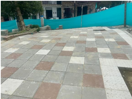
Fotografía 17: construcción de andén con loseta de colores y línea
