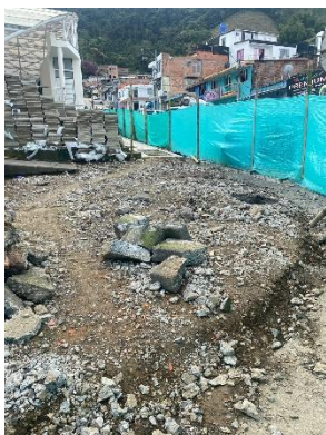
Fotografía 5: demolición esquina calle 4 con carrera 7
