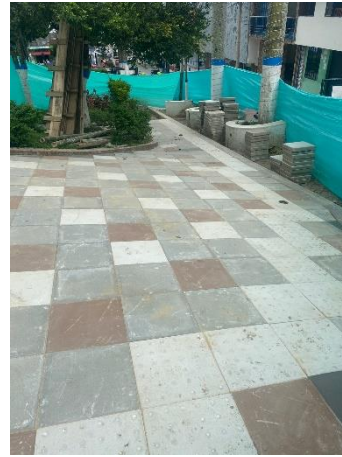
Fotografía 16: construcción de andén con loseta de colores y línea de toperol
