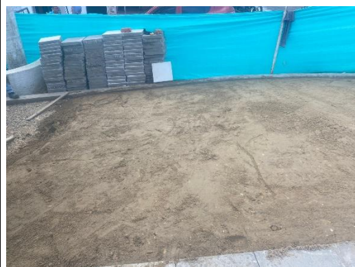
Fotografía 14: base de arena cemento
