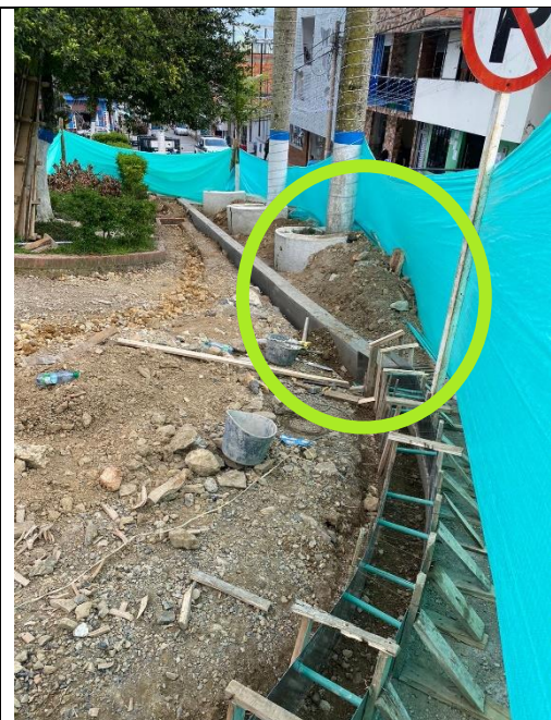
Fotografía 1. Acopio de material RCD y producto de excavación
