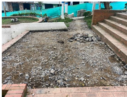
Fotografía 4: demolición accesos al parque
