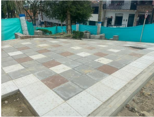
Fotografía 15: construcción de andén con loseta de colores y línea de toperol
