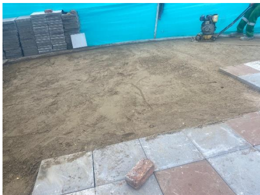
Fotografía 13: base de arena cemento
