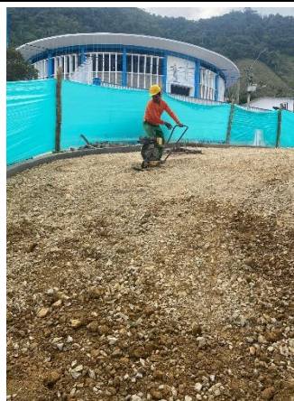
Fotografía 10: mejoramiento de piso con material de
