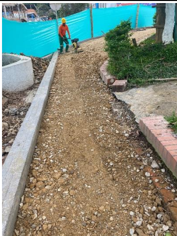
Fotografía 11: mejoramiento de piso con material de afirmado
