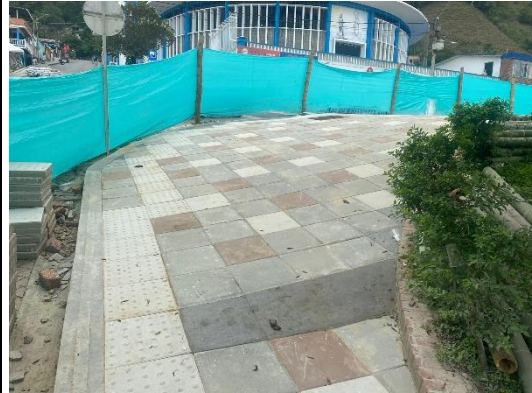
Fotografía 20: construcción de andén con loseta de colores y línea de
