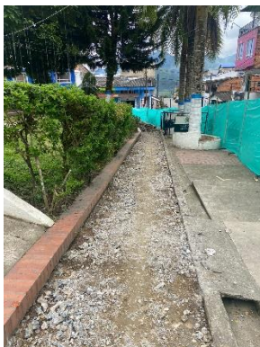
Fotografía 3: demolición andén frente alcaldía
