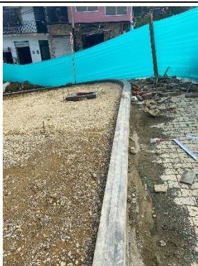
Fotografía 7: construcción de bordillo fundido en sitio
