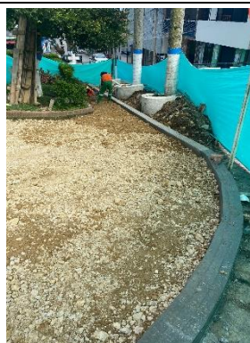
Fotografía 8: construcción de bordillo fundido en sitio
