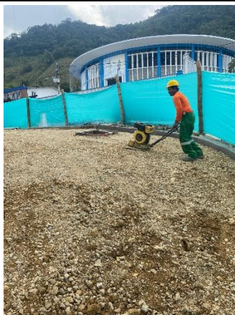
Fotografía 9: mejoramiento de piso con material de afirmado
