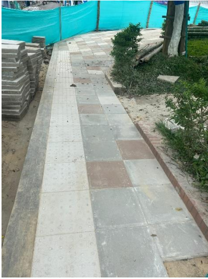
Fotografía 19: construcción de andén con loseta de colores y línea de
