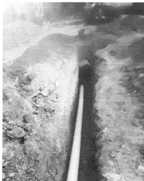
FOTOFAGRIA 14- Suministro e instalación de tubería PVC de 6"
