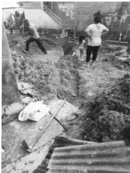
FOTOFAGRIA 17- Relleno con material proveniente de la excavacion
