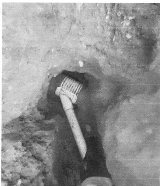
FOTOFAGRIA 15- Suministro e instalación de tubería PVC de 6" con su respectiva silla yee
