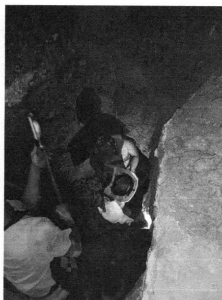
FOTOFAGRIA 16- Suministro e instalación de silla yee
