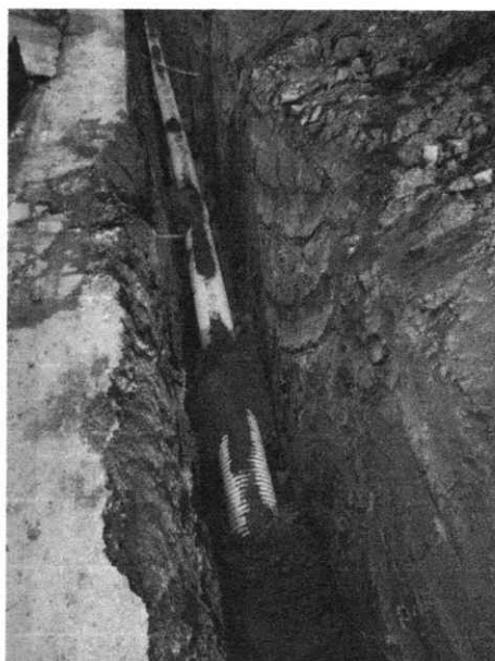
FOTOFAGRIA 12- Suministro e instalación de arena para sentar tubería.
