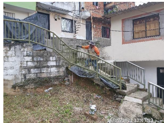
Fotografía # 12: Acompañamiento en aplicación de anti corrosivo
