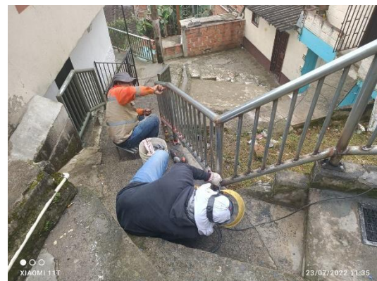
Fotografía # 14: Acompañamiento en actividad de soldadura
