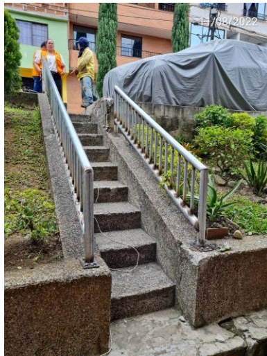
Fotografía # 19: frente de obra en barrio Manrique oriental cr 41 cl 68-75
