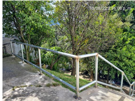
Fotografía # 18: frente de obra en barrio el salvador cr 34 f cl 34b
