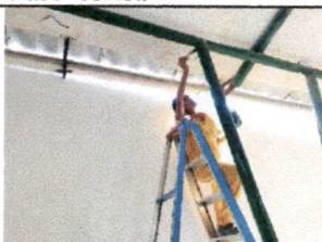
aplicación de pintura esmalte en barandas del cielo raso en el taller de pintura
