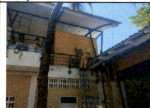
mantenimiento de baluarte de san miguel de chambacu con aplicación de pintura al temple
