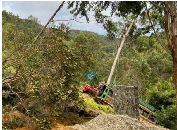
Figura No 7. Deslizamiento sector palmichal - Fuente MiOriente
