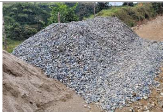
Imagen 10. Acopio temporal de materiales en la vereda Saltillo.
