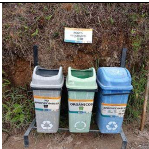
Imagen 31. Instalación de punto ecológico de la vereda Las Palmas del municipio de Granada.
