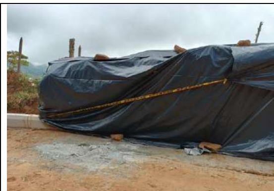
Imagen 5. Almacenamiento temporal de cemento.
