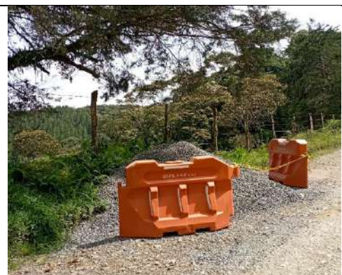
Imagen 17. Maletines demarcando área de almacenamiento de material.
