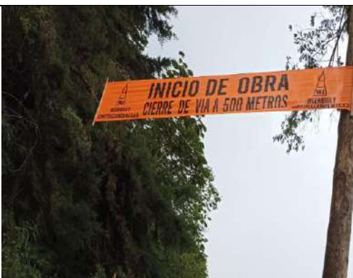
Imagen 16. Señalización inicio de obra.
