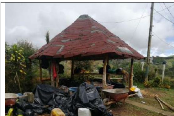
Imagen 8. Acopio temporal de materiales.
