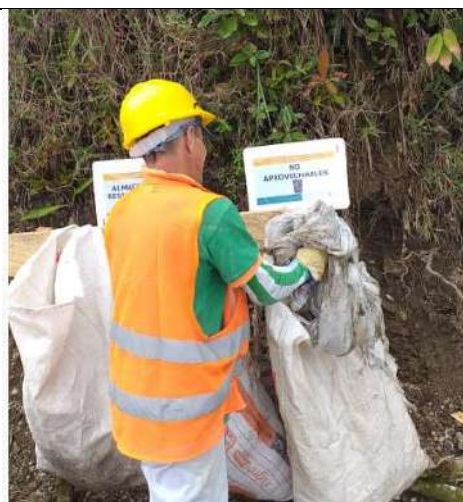
Imagen 32. Instalación de punto ecológico en frente de obra en el municipio de Concepción, vereda Sonadora.
