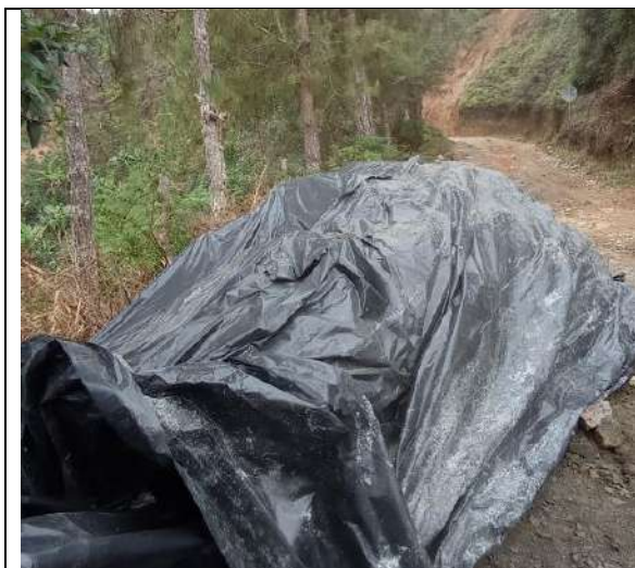
Imagen 7. Almacenamiento temporal de materiales.
