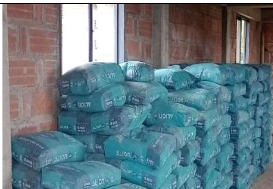
Imagen 6. Almacenamiento temporal de cemento.
