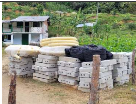
Imagen 11. Almacenamiento de materiales en la vereda Saltillo.
