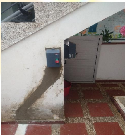
Arrancador directo de la electrobomba sumergible
