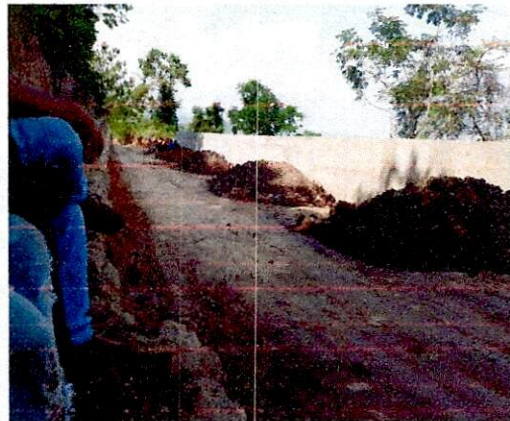
Foto 4. Avance de obra – San Vicente de Chucurí hasta la fecha.
