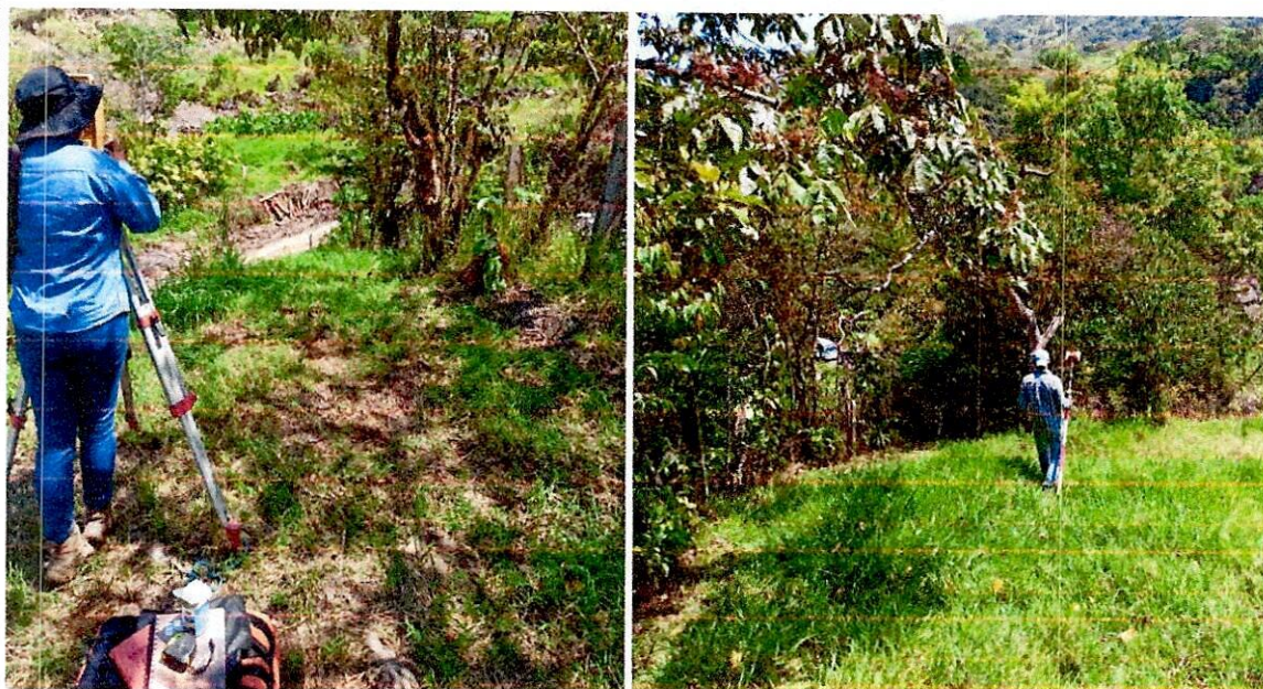
Foto 8. LOCALIZACIÓN Y REPLANTEO CON EQUIPO DE TOPOGRAFÍA
