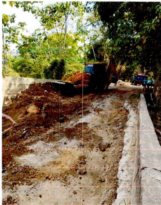
Foto 2. Avance de obra – San Vicente de Chucurí hasta la fecha.
