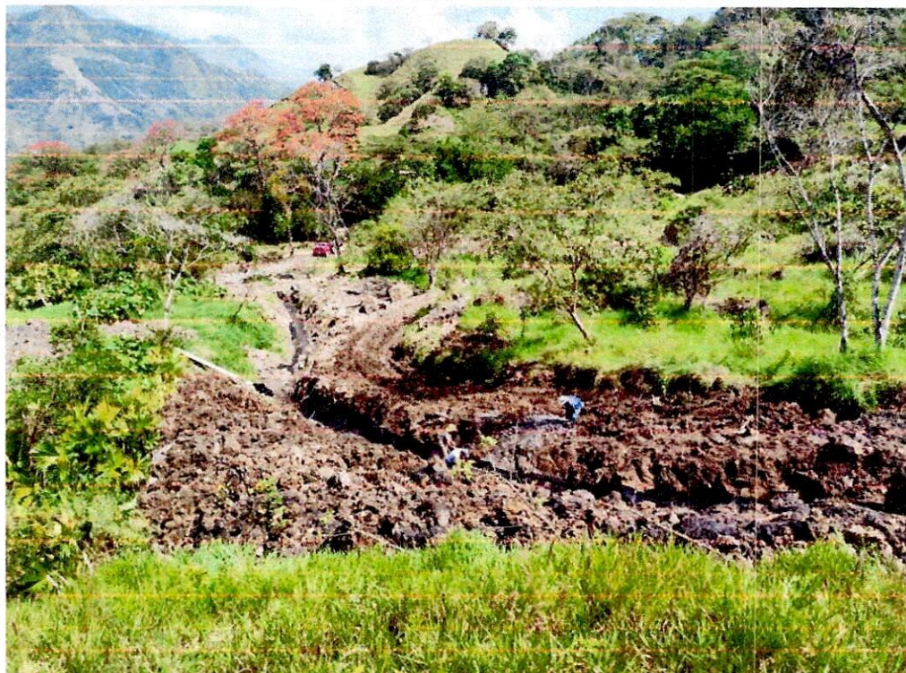
Foto 9. EXCAVACIONES VARIAS EN MATERIAL COMÚN EN SECO A MANO
