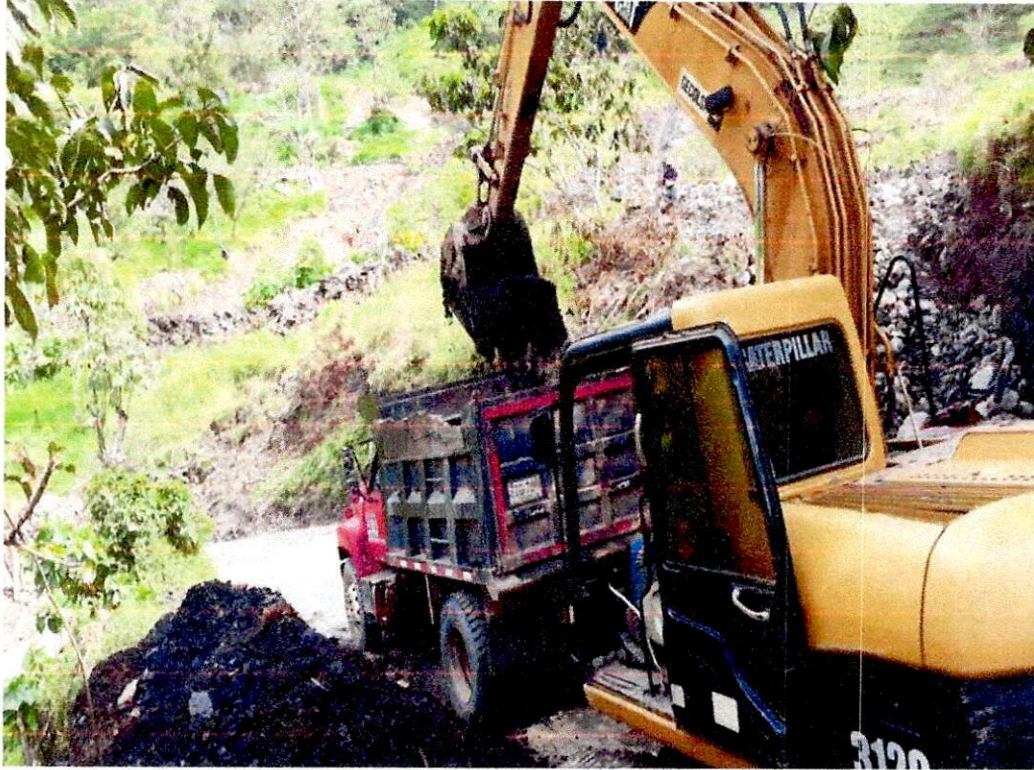
Foto 10. RETIRO DE MATERIAL SOBRENTE PRODUCTO DE LAS EXCAVACIONES
