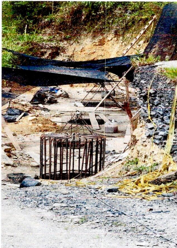
Foto 6. CONCRETO DE 2.000 PSI - FC 150 KG/CM2 SOLADO DE LIMPIEZA
