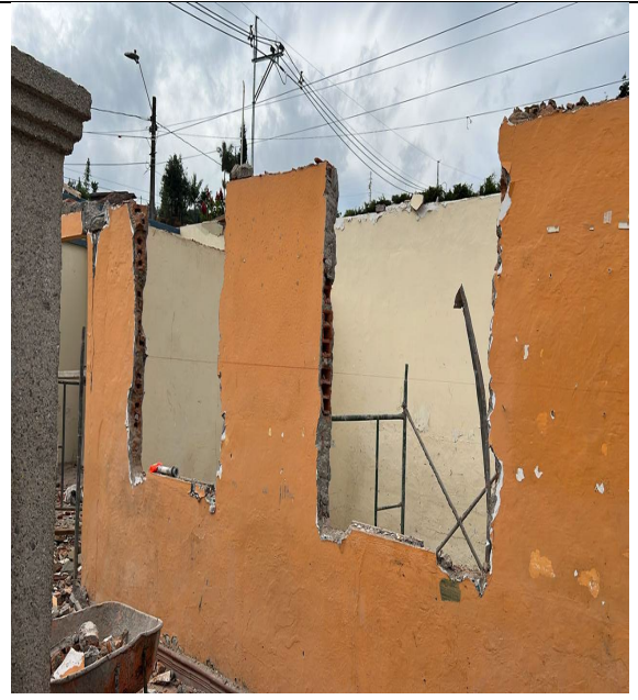
DESMONTES DE PUERTAS Y VENTANAS TRAMO # 2
