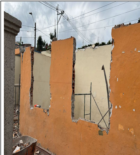
DESMONTES DE PUERTAS Y VENTANAS TRAMO # 2
