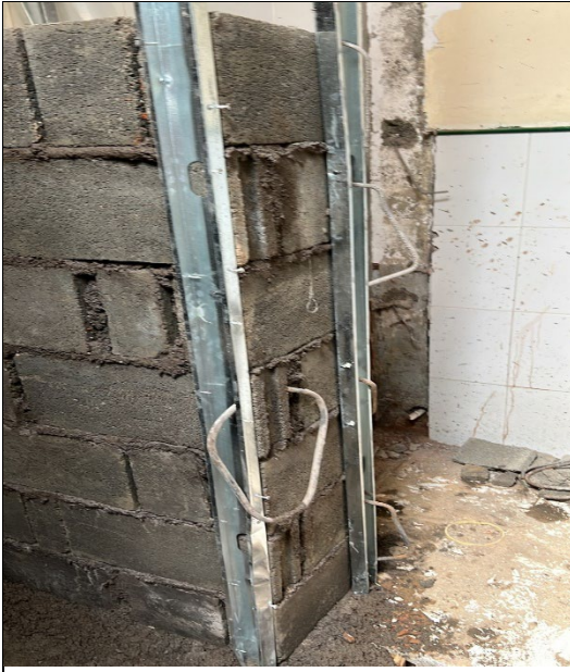
LEVANTE DE MAMPOSTERIA Y DOVELAS
