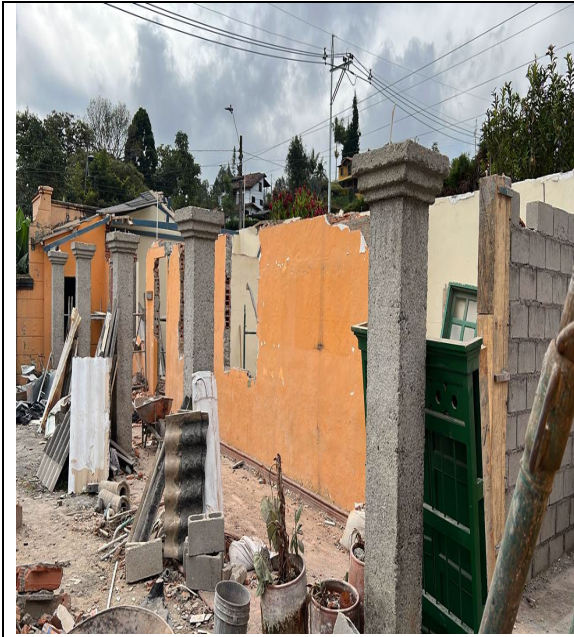
DESMONTES DE PUERTAS Y VENTANAS TRAMO # 2
