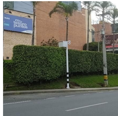
Ilustración 213 – LPR169, Montaje de gabinete
