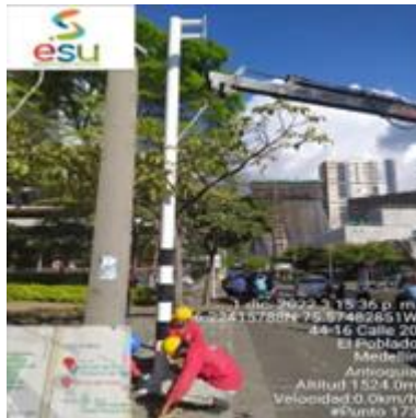
Ilustración 35 - LPR173, Instalación de vertical
