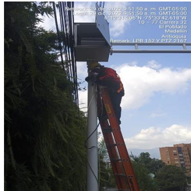
Ilustración 372 – LPR152, Instalación de acometida
