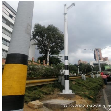
Ilustración 272 – LPR160, Hincado de verticales
