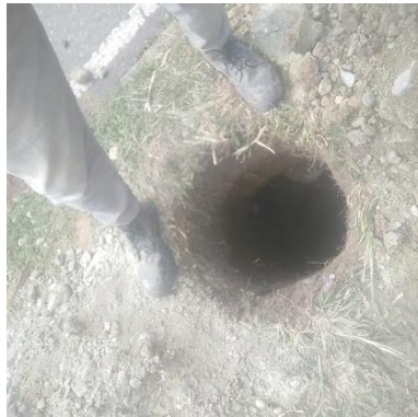
Ilustración 259 – P2138, Excavación para reubicación de poste
