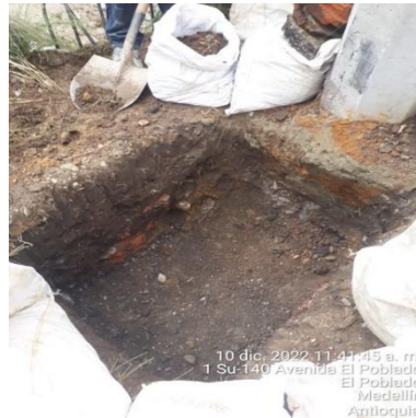
Ilustración 187 – P2140, Excavación de caja
