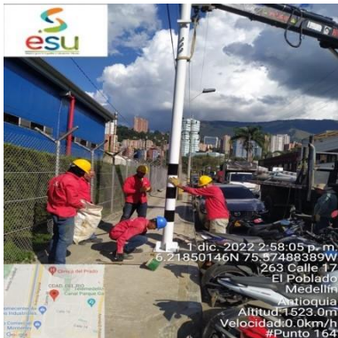
Ilustración 31 – LPR164, Instalación de vertical
