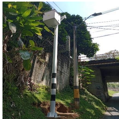
Ilustración 291 – LPR157, Instalación de gabinete
