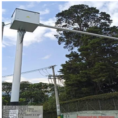
Ilustración 373 – LPR172, Instalación de coraza
