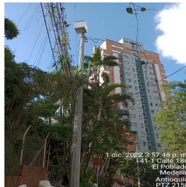
Ilustración 45 – P2150, Instalación brazo, coraza y tierra
