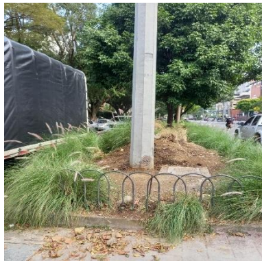
Ilustración 391 - P2140, Recolección de escombros (Después)
