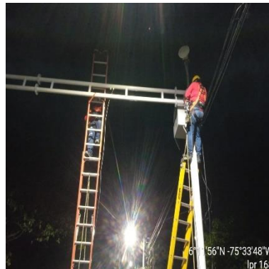
Ilustración 382 – LPR168, Cableado de cercha
