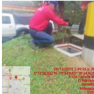
Ilustración 351 - P2155, Traslado de puesta a tierra (Después)
