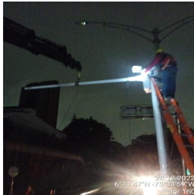
Ilustración 343 - LPR160, Instalación horizontal tipo L
