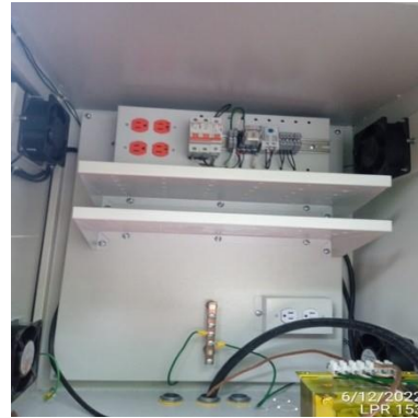
Ilustración 153 – LPR153, Instalación acometida
