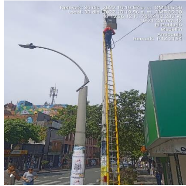
Ilustración 396 – P2154, Instalación de acometida
