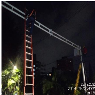
Ilustración 364 - LPR155, Cableado de cercha
