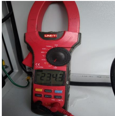
Ilustración 269 - P2148, Energización de punto
