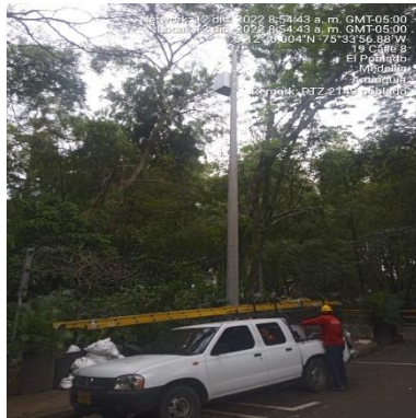
Ilustración 198 - P2149, Montaje de gabinete
