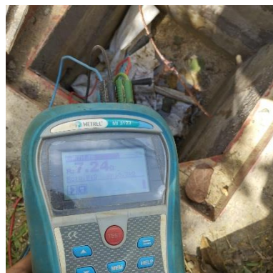
Ilustración 262 - P2156, Instalación puesta a tierra
