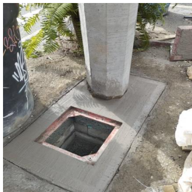
Ilustración 184 – P2164, Levantamiento de caja
