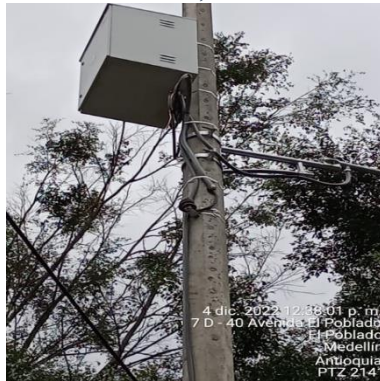
Ilustración 119 – P2141, Instalación coraza
