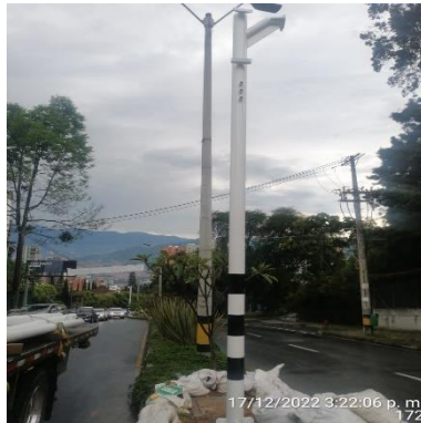
Ilustración 275 – LPR172, Hincado de verticales
