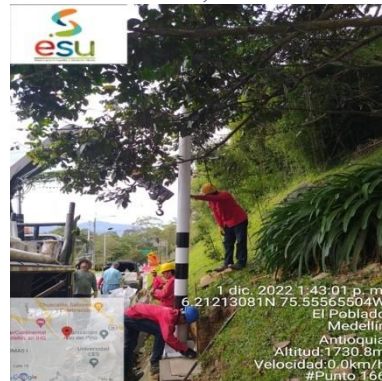
Ilustración 32 – LPR166, Instalación de vertical
