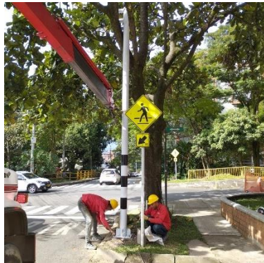
Ilustración 216 – LPR183, Hincado de verticales
