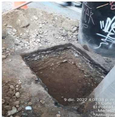
Ilustración 179 – P2164, Excavación de caja
