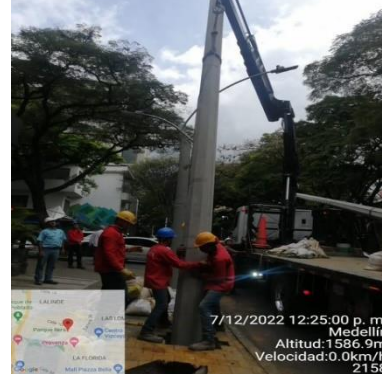
Ilustración 160 - P2158, Hincado de poste
