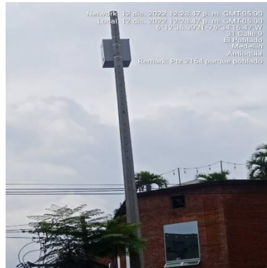
Ilustración 199 - P2164, Montaje de gabinete
