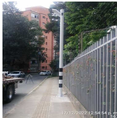
Ilustración 274 – LPR167, Hincado de verticales
