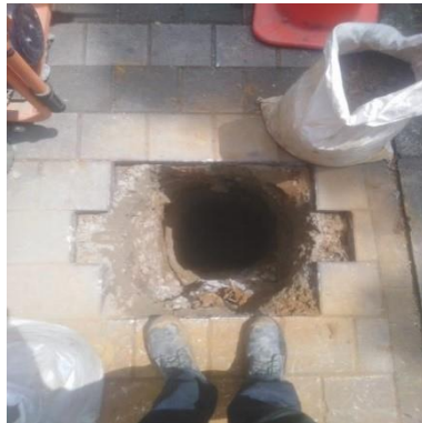
Ilustración 142 – P2158, Excavación para poste
