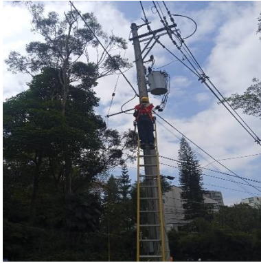
Ilustración 354 – LPR182, Instalación de acometida
