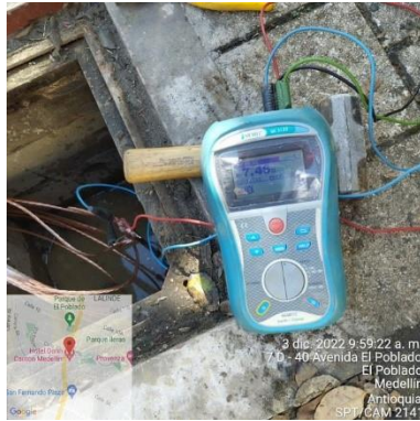
Ilustración 99 – P2141, Instalación puesta tierra
