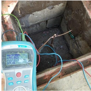
Ilustración 170 - LPR175, Instalación puesta tierra
