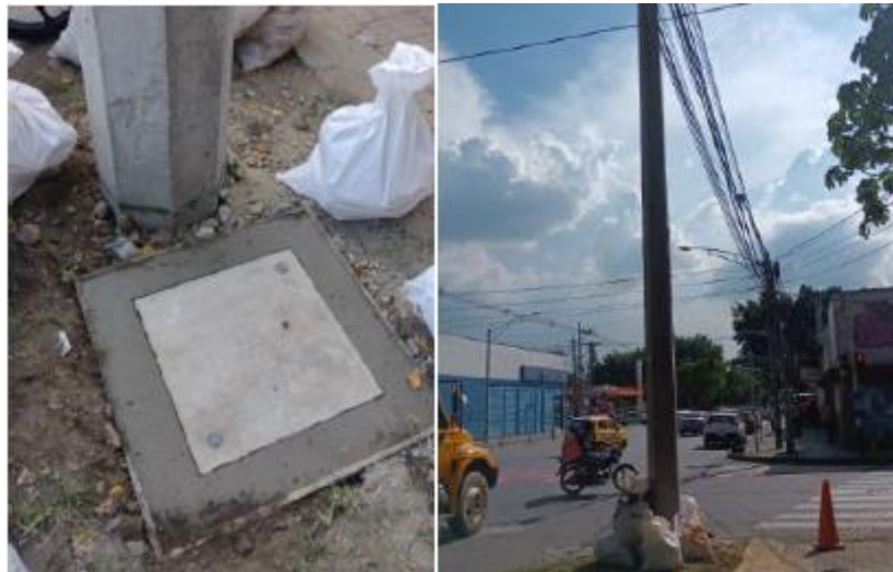
Ilustración 5 Obra civil punto 2125.
