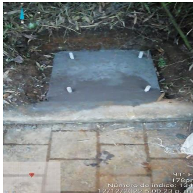
Ilustración 194 – LPR178, Levantamiento de pedestal
