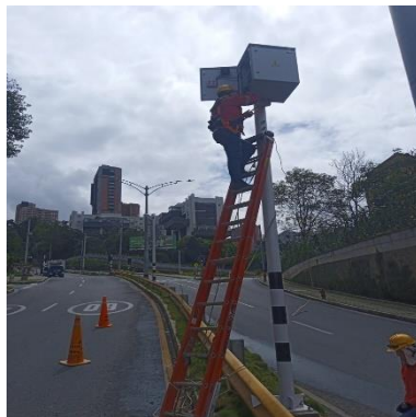
Ilustración 347 - LPR176, Instalación de acometida
