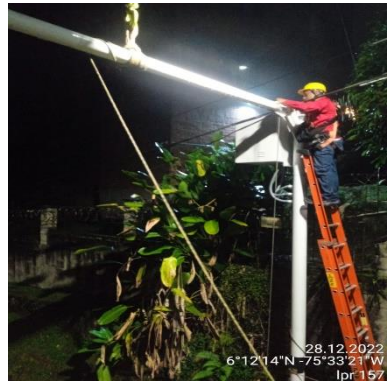
Ilustración 342 – LPR157, Instalación horizontal tipo L
