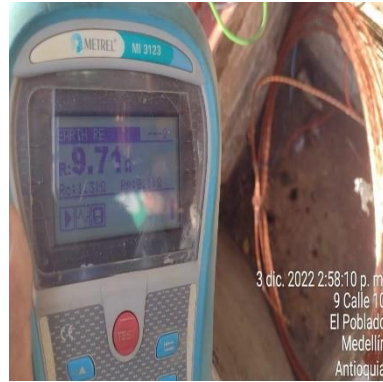
Ilustración 100 – P2154, Instalación puesta tierra
