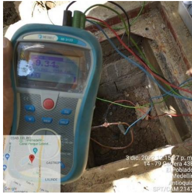
Ilustración 105 – P2147, Instalación puesta tierra
