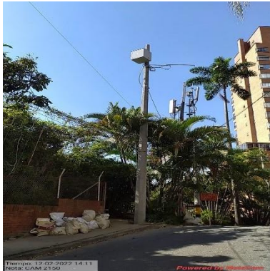
Ilustración 58 – P2150, Instalación coraza
