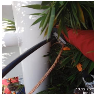
Ilustración 237 – LPR182, Instalación de acometida
