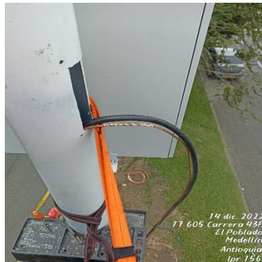
Ilustración 248 – LPR156, Instalación de acometida
