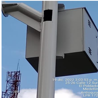
Ilustración 286 – LPR172, Instalación de gabinete
