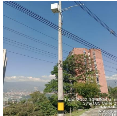
Ilustración 44 – P2160, Instalación coraza, tierra y acometida
