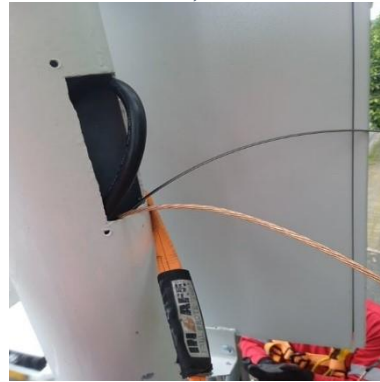
Ilustración 138 – LPR158, Instalación de acometida
