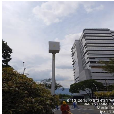
Ilustración 181 – LPR173, Instalación de gabinete
