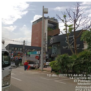
Ilustración 206 – P2153, Montaje de gabinete
