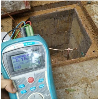
Ilustración 164 - LPR157, Instalación puesta tierra
