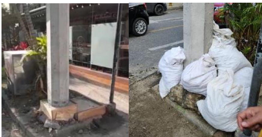
Ilustración 3 Obra civil punto 2096.
