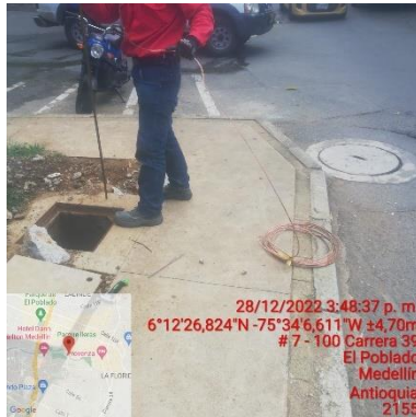
Ilustración 350 – P2155, Traslado de puesta a tierra (Antes)
