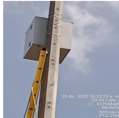
Ilustración 293 - P2166, Instalación de gabinete
