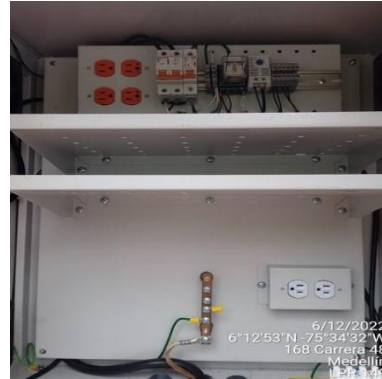
Ilustración 155 – LPR149, Instalación acometida
