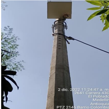
Ilustración 60 – P2146, Instalación coraza
