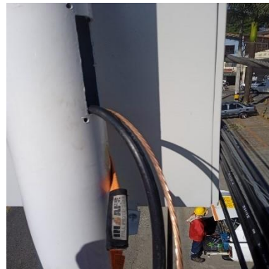
Ilustración 94 – LPR184, Instalación acometida
