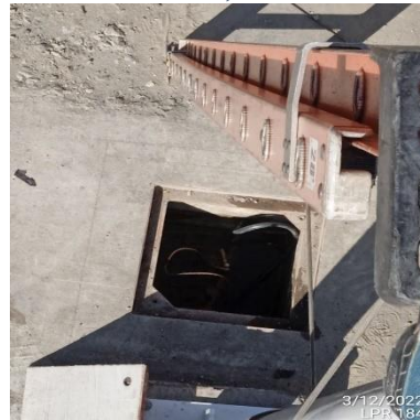
Ilustración 96 – LPR184, Instalación tierra
