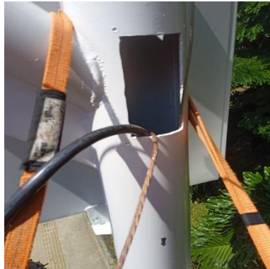
Ilustración 399 - P2167, Instalación de acometida
