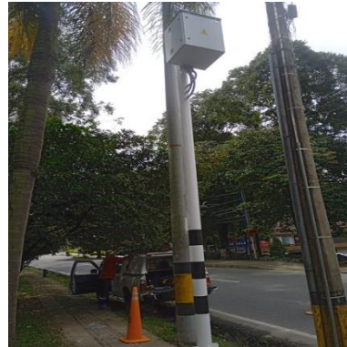
Ilustración 114 – LPR158, Instalación coraza
