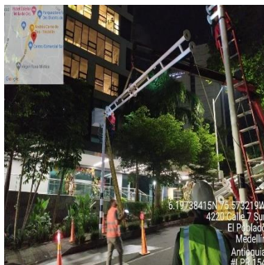
Ilustración 302 - LPR154, Instalación de cercha
