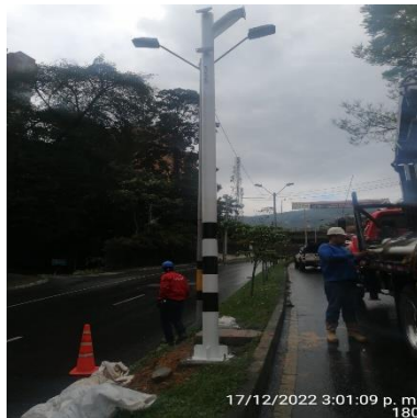
Ilustración 277 – LPR180, Hincado de verticales
