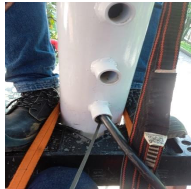
Ilustración 295 - LPR163, Instalación de acometida
