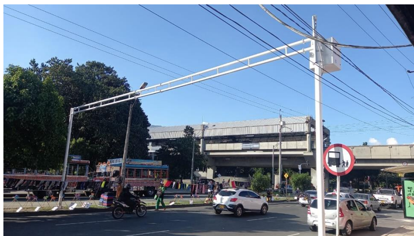
Ilustración 15 estructura punto LPR-139.
