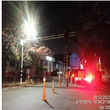
Ilustración 339 – LPR150, Instalación de cercha
