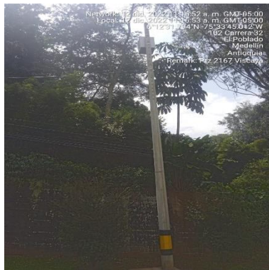
Ilustración 202 - P2167, Montaje de gabinete
