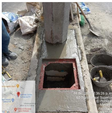
Ilustración 238 – P2166, Levantamiento de caja
