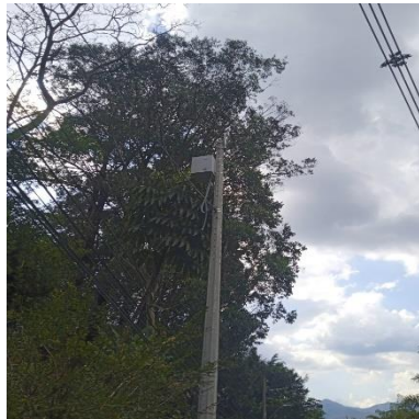
Ilustración 371 – P2167, Instalación de acometida
