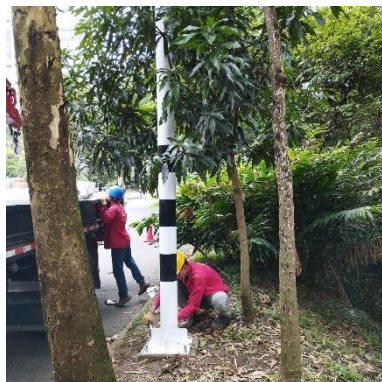
Ilustración 214 – LPR162, Hincado de verticales
