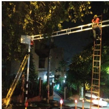
Ilustración 381 – LPR153, Cableado de cercha
