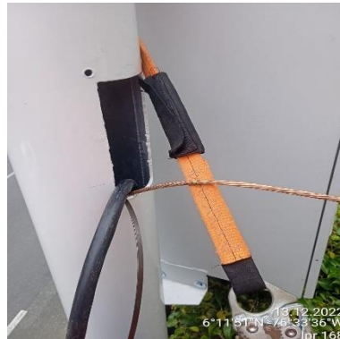
Ilustración 233 – LPR168, Instalación de acometida
