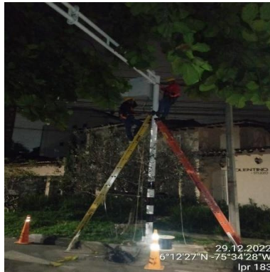
Ilustración 366 – LPR183, Cableado de cercha
