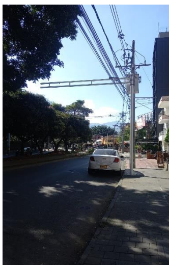
Ilustración 13 estructura punto LPR-137.
