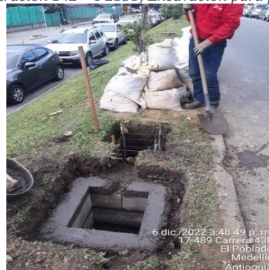
Ilustración 144 – LPR156, Excavación de caja
