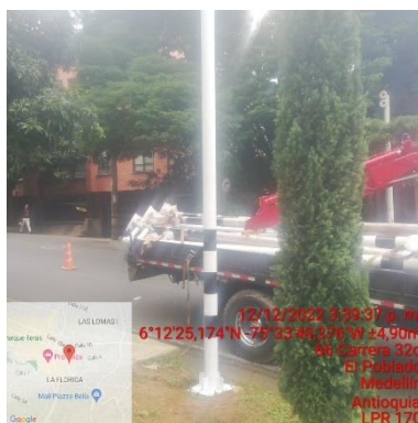
Ilustración 190 – LPR170, Hincado de verticales
