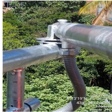
Ilustración 171 - P2151, Prueba de montaje de cámara en brazo
