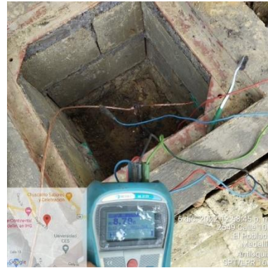
Ilustración 147 – LPR166, Instalación puesta tierra
