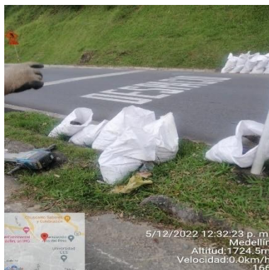
Ilustración 126 – Recolección de escombros
