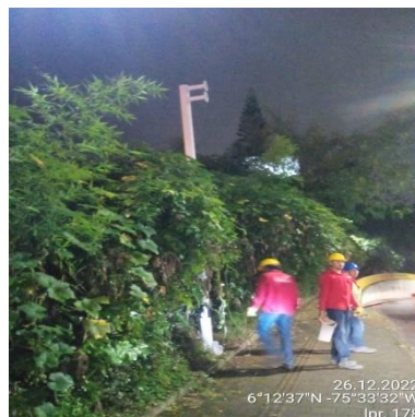
Ilustración 331 – LPR178, Hincado de verticales
