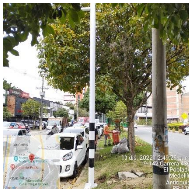
Ilustración 219 – LPR179, Hincado de verticales
