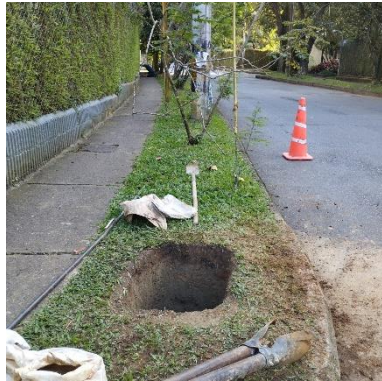
Ilustración 280 – P2155, Excavación para poste
