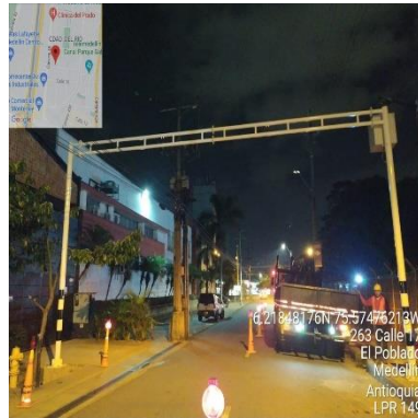
Ilustración 322 – LPR149, Instalación de cercha
