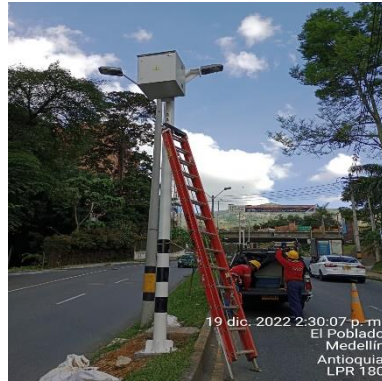
Ilustración 281 – LPR180, Instalación de gabinete
