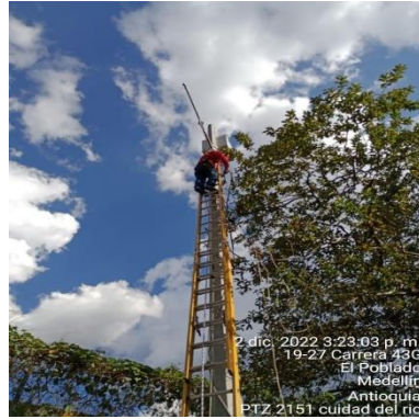
Ilustración 65 - P2151, Instalación de brazo
