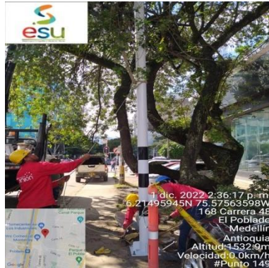
Ilustración 29 – LPR149, Instalación de vertical
