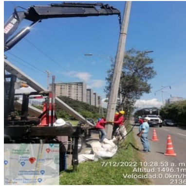
Ilustración 158 - P2136, Hincado de poste
