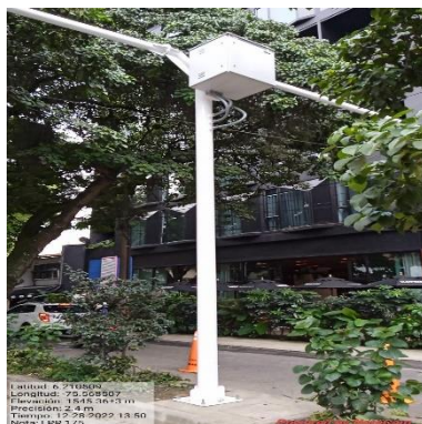
Ilustración 352 – LPR175, Instalación de gabinete
