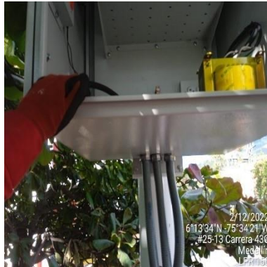
Ilustración 52 – LPR150, Instalación acometida
