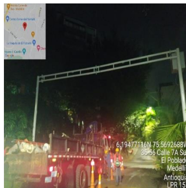
Ilustración 320 – LPR155, Instalación de cercha
