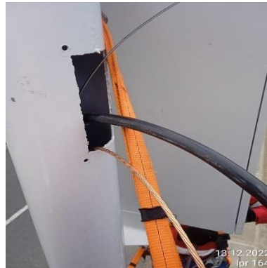
Ilustración 235 – LPR164, Instalación de acometida
