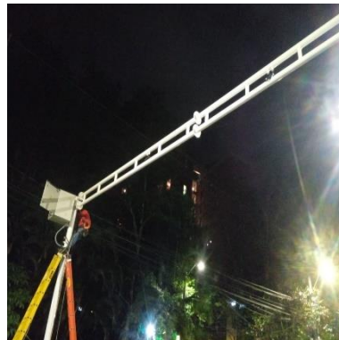
Ilustración 363 - LPR148, Cableado de cercha
