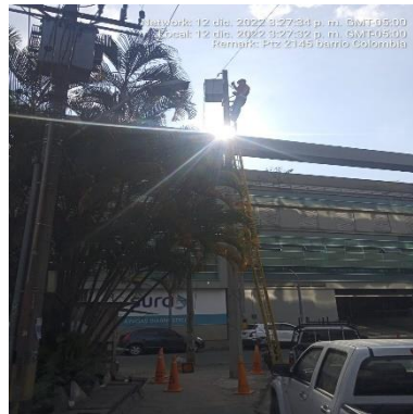
Ilustración 201 - P2145, Montaje de gabinete
