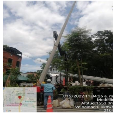
Ilustración 159 - P2164, Hincado de poste
