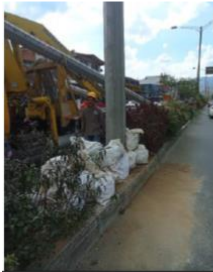
Ilustración 6 Obra civil punto 2126.
