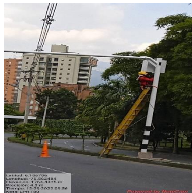
Ilustración 370 – LPR180, Instalación de acometida
