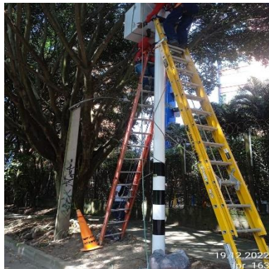
Ilustración 284 – LPR163, Instalación de gabinete
