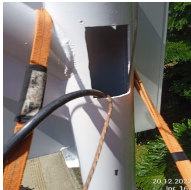
Ilustración 294 - LPR167, Instalación de acometida
