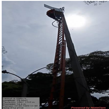
Ilustración 397 - P2158, Instalación de acometida
