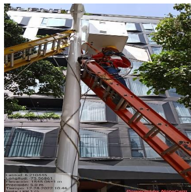
Ilustración 353 – LPR175, Instalación de acometida
