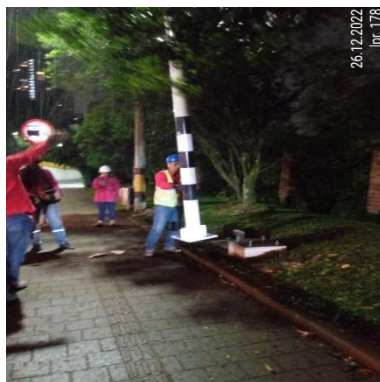
Ilustración 330 – LPR178, Hincado de verticales
