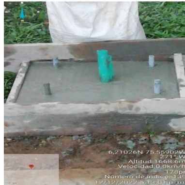
Ilustración 193 – LPR178, Levantamiento de pedestal
