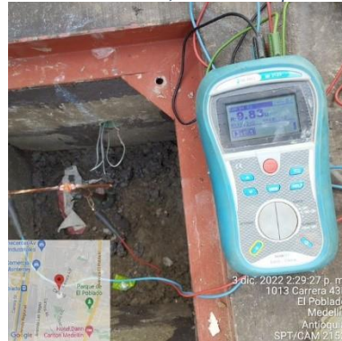
Ilustración 103 – P2152, Instalación puesta tierra
