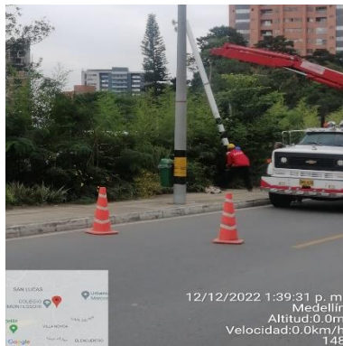
Ilustración 188 – LPR148, Hincado de verticales
