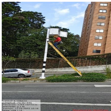
Ilustración 369 – LPR172, Instalación de acometida
