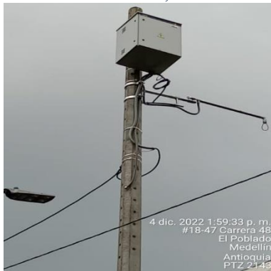
Ilustración 115 – P2143, Instalación brazo y coraza
