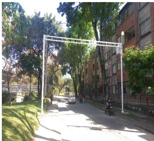
Ilustración 17 estructura punto LPR-143
