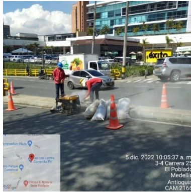
Ilustración 134 – P2166, Excavación para poste
