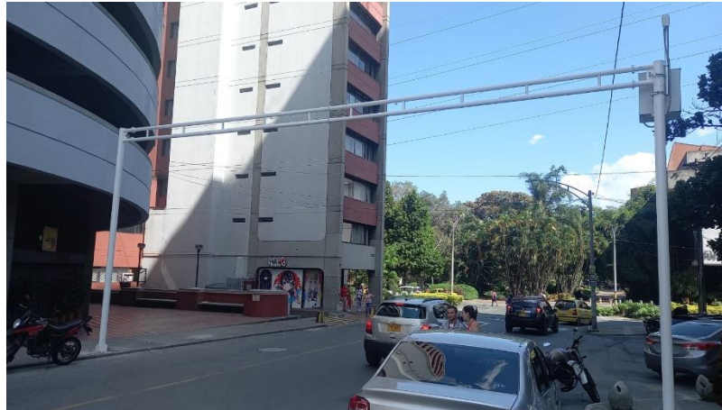
Ilustración 18 obra civil punto LPR-147.
