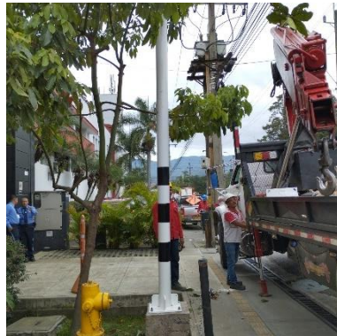
Ilustración 217 – LPR164, Hincado de verticales
