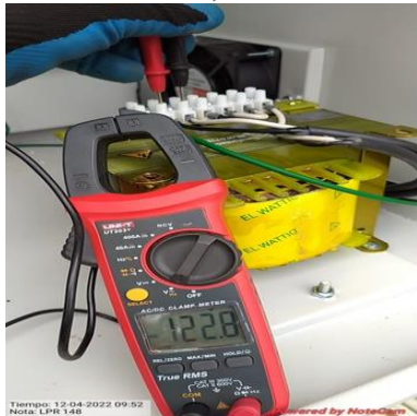
Ilustración 125 – LPR148, Instalación coraza
