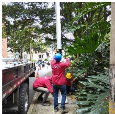
Ilustración 215 – LPR174, Hincado de verticales
