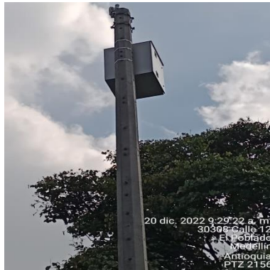
Ilustración 292 - P2156, Instalación de gabinete
