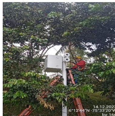
Ilustración 245 – LPR166, Instalación de gabinete
