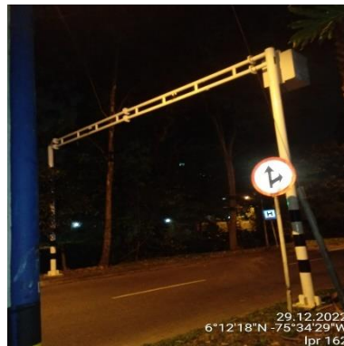
Ilustración 365 - LPR162, Cableado de cercha
