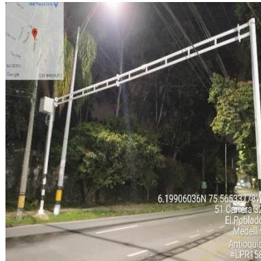
Ilustración 305 - LPR158, Instalación de cercha
