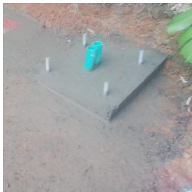
Ilustración 220 – LPR165, Levantamiento de pedestal
