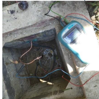
Ilustración 108 – LPR153, Instalación puesta tierra
