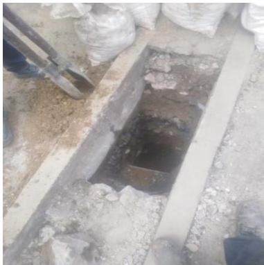
Ilustración 79 – P2142, Excavación de poste
