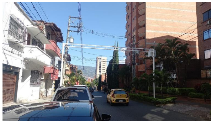
Ilustración 11 estructura punto LPR-135.
