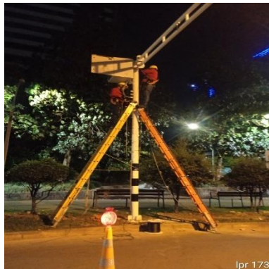
Ilustración 405 – LPR173, Cableado de cercha
