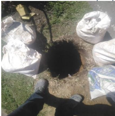
Ilustración 48 - P2136, Excavación para poste
