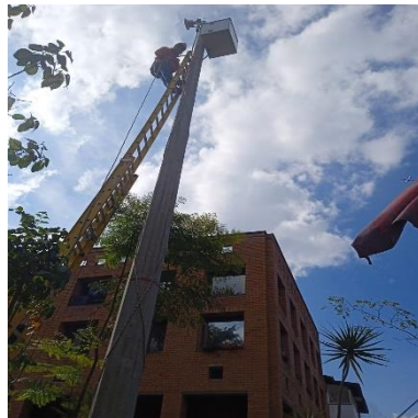
Ilustración 266 - P2164, Instalación de acometida
