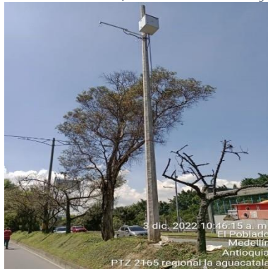
Ilustración 83 – P2165, Instalación coraza y brazo
