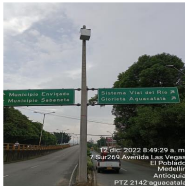
Ilustración 204 – P2142, Montaje de gabinete
