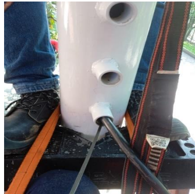
Ilustración 398 – LPR163, Instalación de acometida
