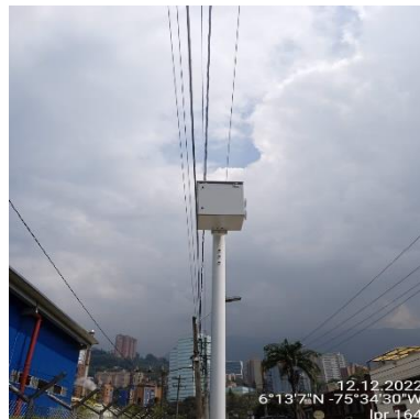
Ilustración 197 – LPR164, Montaje de gabinete
