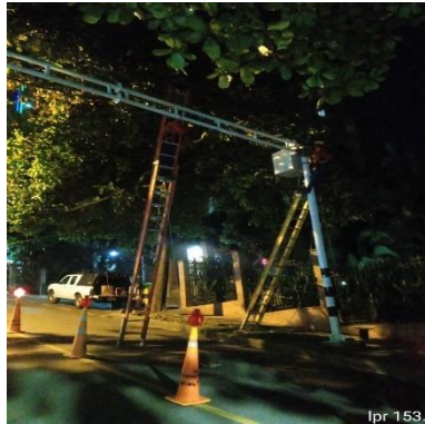
Ilustración 403 – LPR153, Cableado de cercha
