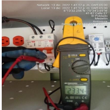
Ilustración 228 – LPR153, Energización de punto
