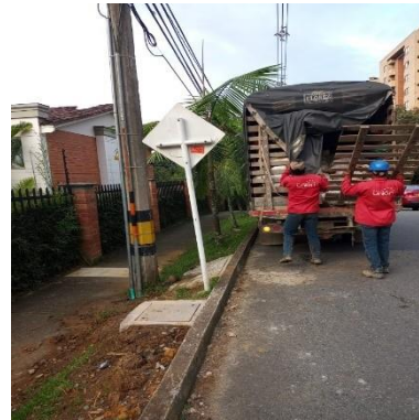
Ilustración 131 – Recolección de escombros
