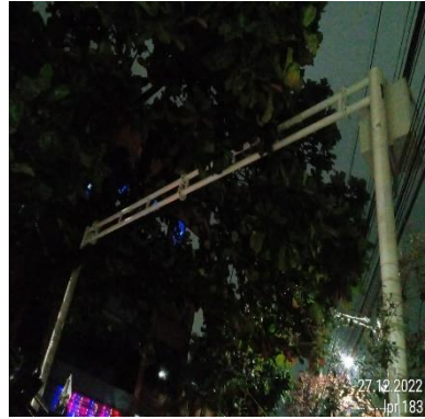
Ilustración 338 – LPR183, Instalación de cercha
