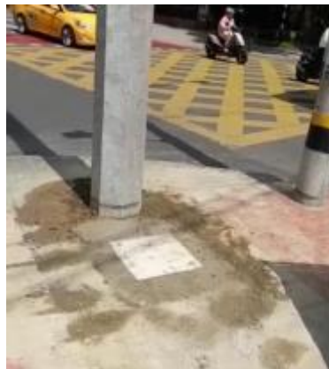
Ilustración 8 Obra civil punto 2103.
