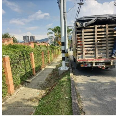
Ilustración 395 – LPR168, Recolección de escombros (Después)
