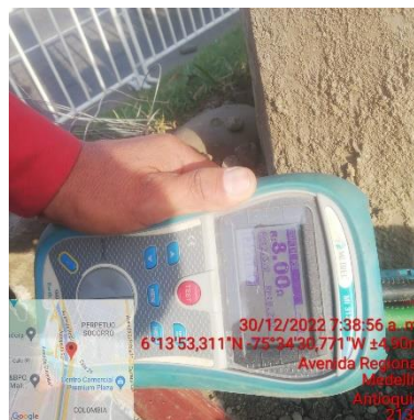
Ilustración 408 - P2138, Instalación puesta a tierra
