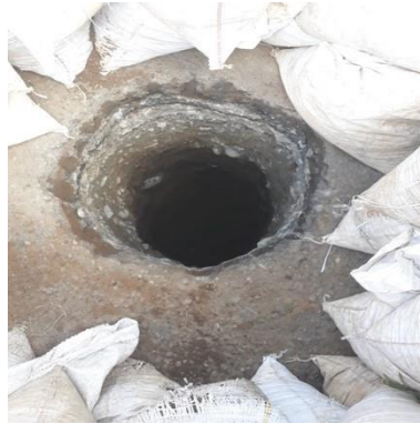
Ilustración 47 - P2164, Excavación para poste
