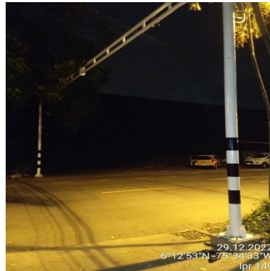
Ilustración 367 – LPR149, Cableado de cercha
