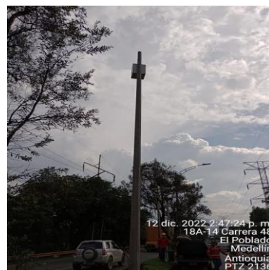
Ilustración 209 - P2136, Montaje de gabinete
