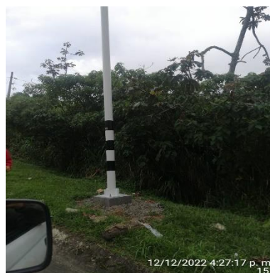
Ilustración 191 – LPR151, Hincado de verticales
