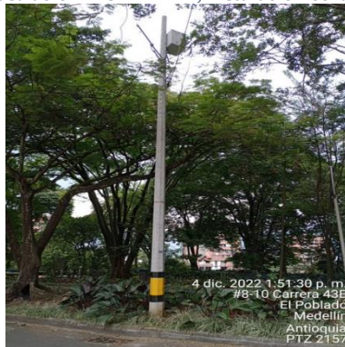
Ilustración 121 – P2157, Instalación coraza
