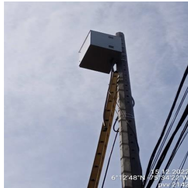
Ilustración 258 – P2148, Instalación de acometida
