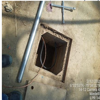
Ilustración 49 – LPR149, Instalación tierra
