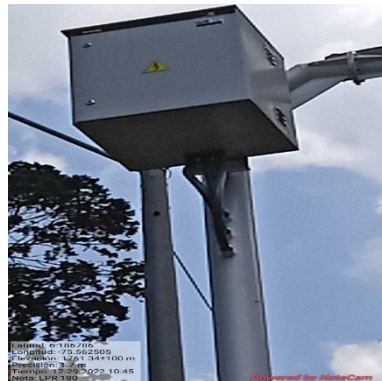
Ilustración 374 – LPR180, Instalación de coraza
