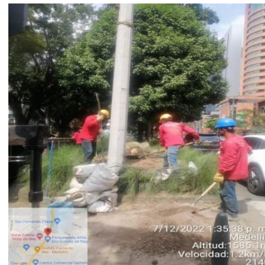
Ilustración 174 - P2140, Hincado de poste
