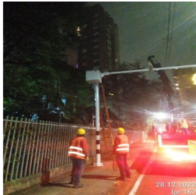
Ilustración 341 – LPR167, Instalación horizontal tipo L
