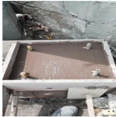
Ilustración 176 – LPR179, Levantamiento de 2 pedestales
