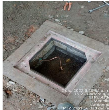
Ilustración 97 – P2151, conectorización tierra
