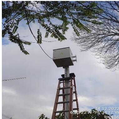
Ilustración 246 – LPR156, Instalación de gabinete
