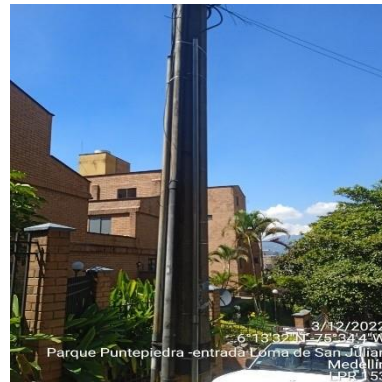
Ilustración 88 – LPR153, Instalación acometida
