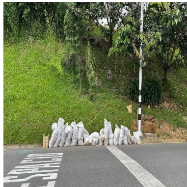
Ilustración 392 - LPR166, Recolección de escombros (Antes)
