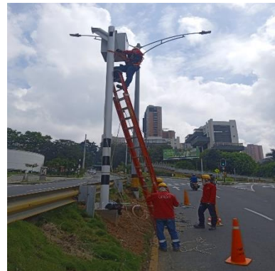
Ilustración 346 - LPR160, Instalación de acometida
