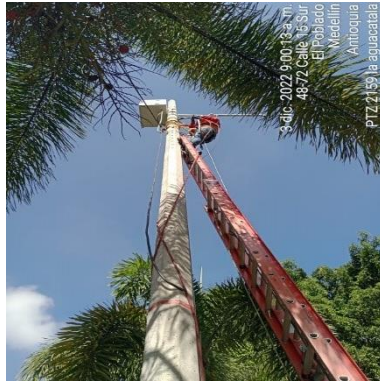
Ilustración 81 – P2159, Instalación coraza y brazo
