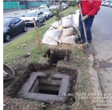
Ilustración 162 - LPR156, Levantamiento de cajas
