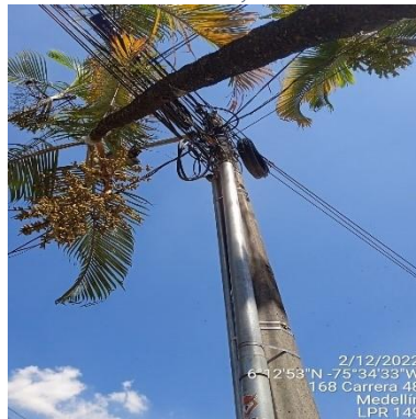
Ilustración 51 – LPR149, Instalación acometida
