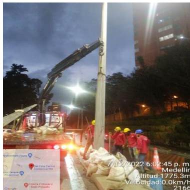
Ilustración 173 - P2166, Hincado de poste
