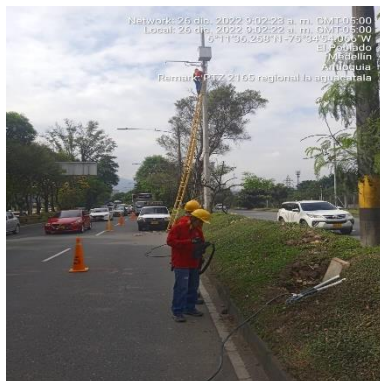
Ilustración 334 - P2165, Instalación de acometida
