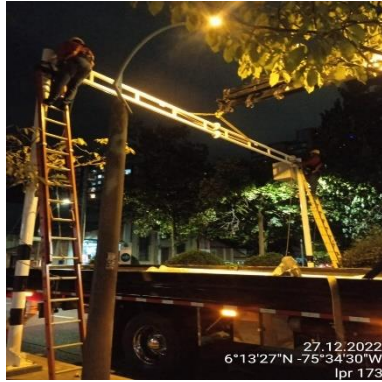
Ilustración 337 – LPR173 Instalación de cercha
