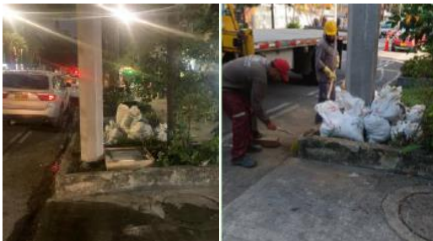
Ilustración 7 Obra civil punto 2128
