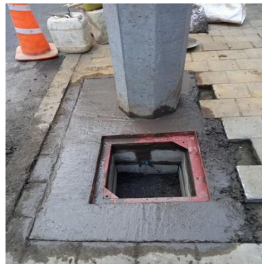
Ilustración 178 – P2158, Levantamiento de caja
