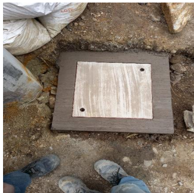
Ilustración 196 - P2140, Levantamiento de caja
