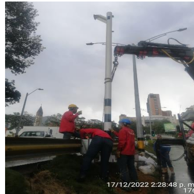
Ilustración 276 – LPR176, Hincado de verticales
