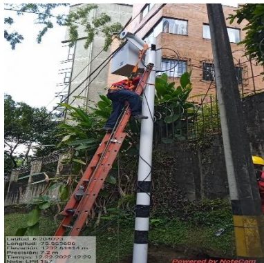
Ilustración 325 – LPR157, Instalación de acometida
