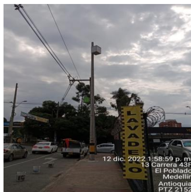
Ilustración 208 – P2152, Montaje de gabinete
