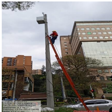
Ilustración 336 – P2140, Instalación de acometida
