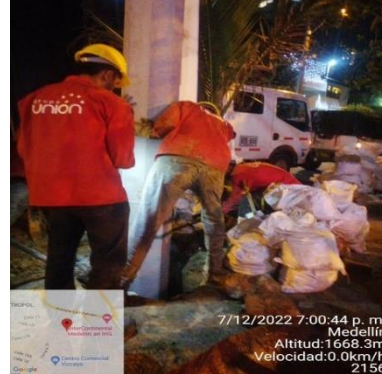
Ilustración 161 - P2156, Hincado de poste
