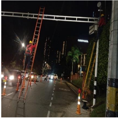
Ilustración 383 – LPR169, Cableado de cercha
