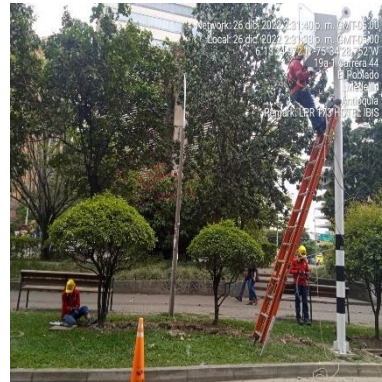
Ilustración 333 – LPR173, Instalación de acometida
