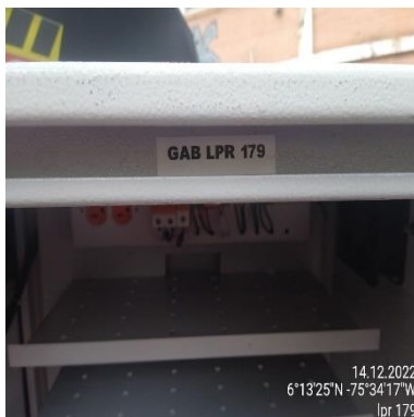
Ilustración 244 – LPR179, Instalación de gabinete
