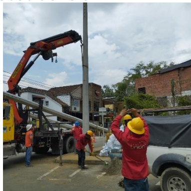
Ilustración 290 – P2155, Traslado de poste
