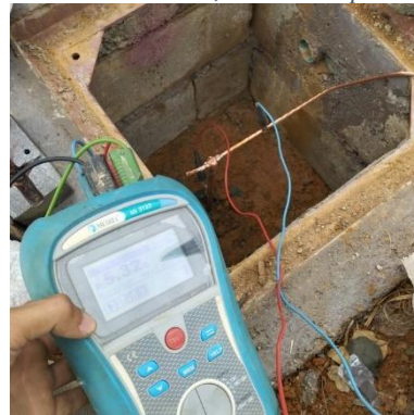
Ilustración 169 - LPR172, Instalación puesta tierra
