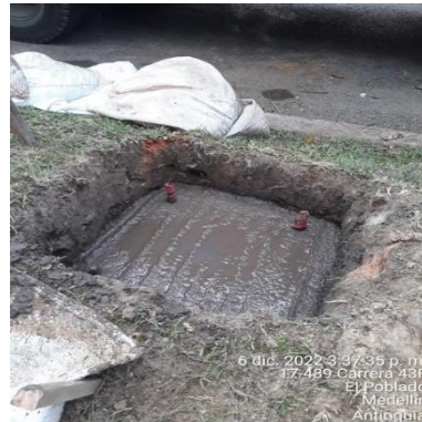
Ilustración 143 – LPR156, Levantamiento de pedestal
