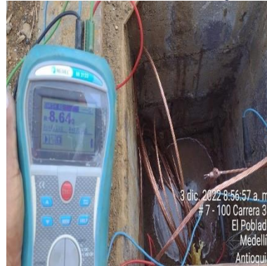
Ilustración 148 - P2155, Instalación puesta tierra
