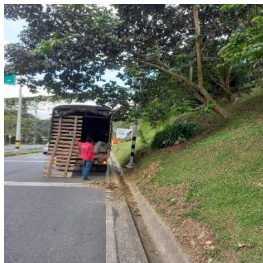
Ilustración 393 - LPR166, Recolección de escombros (Después)
