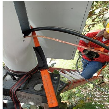
Ilustración 247 – LPR166, Instalación de acometida
