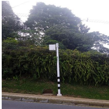
Ilustración 210 – LPR152, Montaje de gabinete
