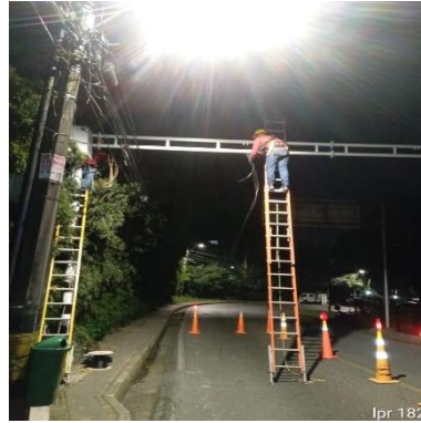
Ilustración 384 – LPR182, Cableado de cercha
