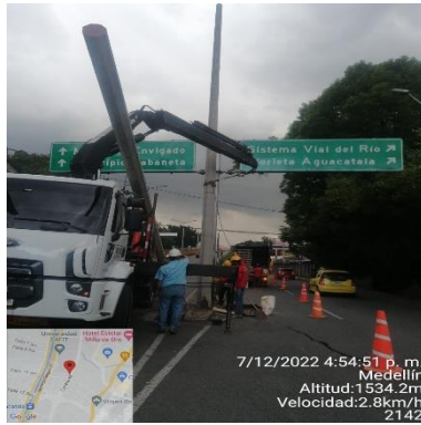
Ilustración 175 – P2142, Hincado de poste
