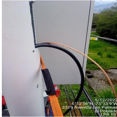
Ilustración 136 – LPR151, Instalación de acometida
