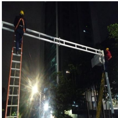
Ilustración 368 – LPR154, Cableado de cercha
