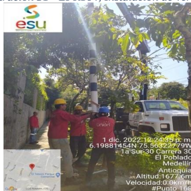
Ilustración 33 – LPR168, Instalación de vertical
