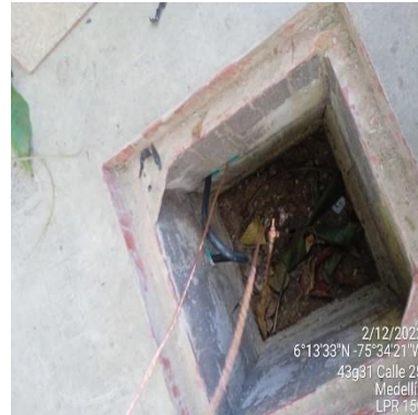
Ilustración 53 – LPR150, Instalación tierra
