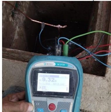
Ilustración 166 - LPR163, Instalación puesta tierra
