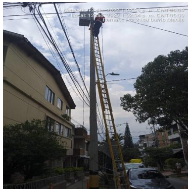
Ilustración 200 - P2148, Montaje de gabinete
