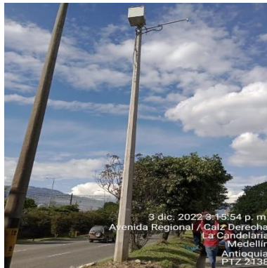
Ilustración 87 – P2138, Instalación coraza y brazo
