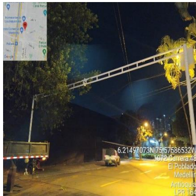
Ilustración 323 – LPR164, Instalación de cercha
