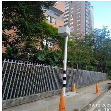
Ilustración 285 – LPR167, Instalación de gabinete
