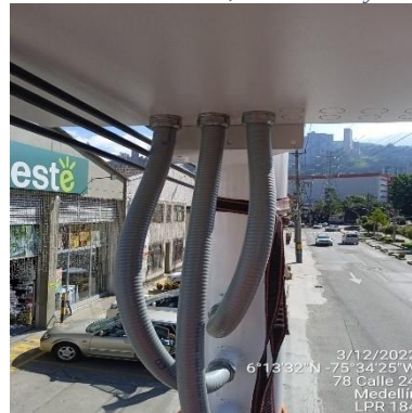
Ilustración 95 – LPR184, Instalación coraza
