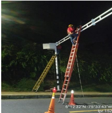
Ilustración 385 – LPR152, Cableado de cercha
