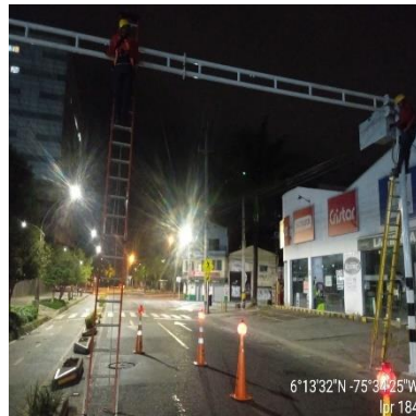
Ilustración 406 – LPR184, Cableado de cercha
