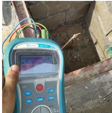
Ilustración 168 - LPR168, Instalación puesta tierra
