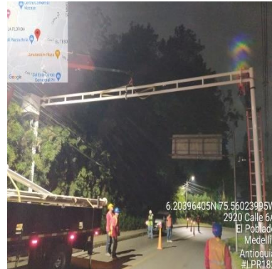
Ilustración 301 - LPR182, Instalación de cercha
