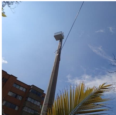
Ilustración 306 - P2156, Instalación de acometida
