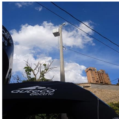
Ilustración 268 - P2153, Instalación de acometida
