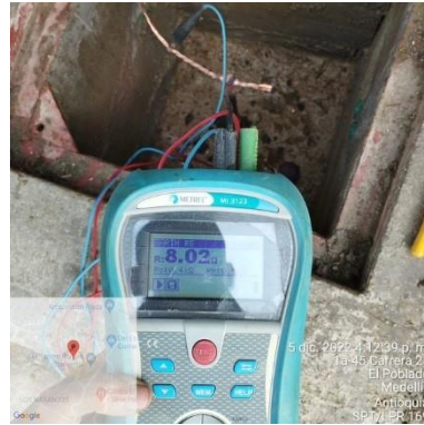
Ilustración 141 – LPR169, Instalación puesta tierra
