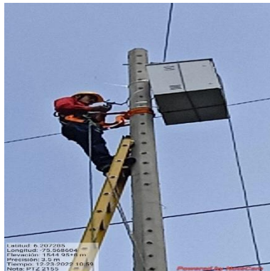
Ilustración 329 – P2155, Instalación de gabinete
