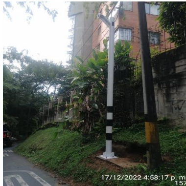
Ilustración 271 – LPR157, Hincado de verticales
