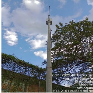
Ilustración 64 - P2151, Instalación coraza
