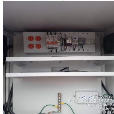
Ilustración 157 – LPR184, Instalación acometida
