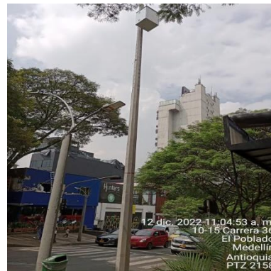
Ilustración 205 - P2158, Montaje de gabinete
