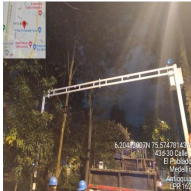
Ilustración 321 – LPR162, Instalación de cercha
