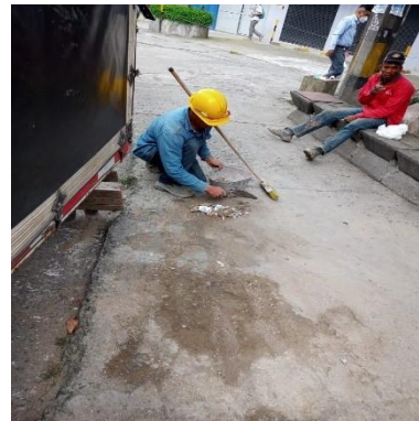
Ilustración 133 – Recolección de escombros
