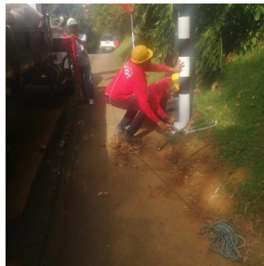
Ilustración 189 – LPR155, Hincado de verticales
