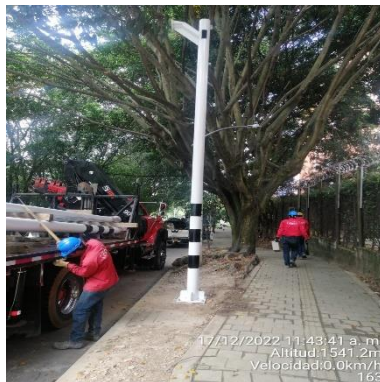
Ilustración 273 – LPR163, Hincado de verticales
