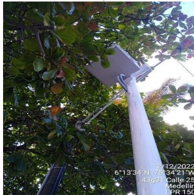
Ilustración 54 – LPR150, Instalación coraza
