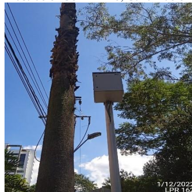
Ilustración 38 – LPR162, Instalación coraza, tierra y acometida
