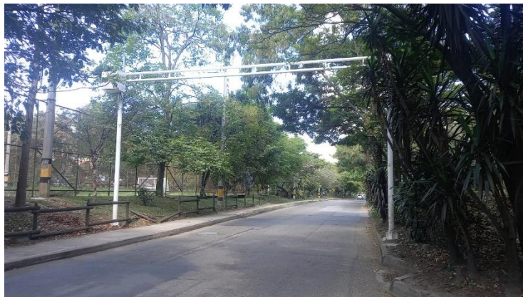
Ilustración 14 estructura punto LPR-138.
