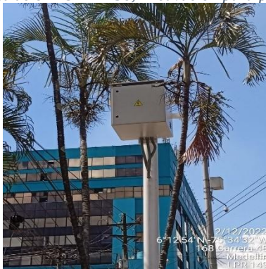
Ilustración 50 – LPR1149, Instalación coraza
