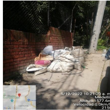
Ilustración 129 – Recolección de escombros
