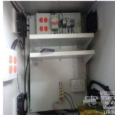
Ilustración 151 – LPR161, Instalación Acometida
