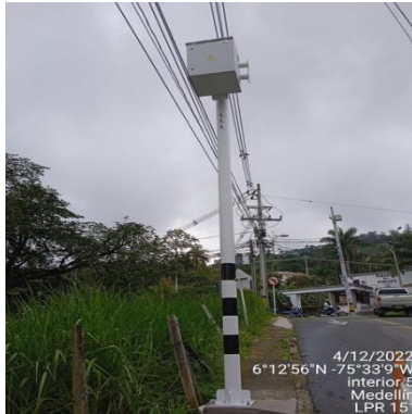
Ilustración 113 – LPR151, Instalación coraza
