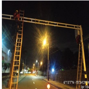
Ilustración 404 – LPR164, Cableado de cercha
