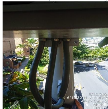
Ilustración 89 – LPR153, Instalación coraza
