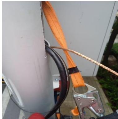
Ilustración 236 – LPR154, Instalación de acometida
