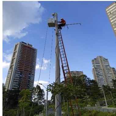
Ilustración 328 – P2161, Instalación de gabinete
