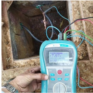
Ilustración 146 – LPR162, Instalación puesta tierra
