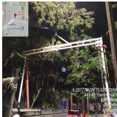
Ilustración 312 – LPR174, Instalación de cercha
