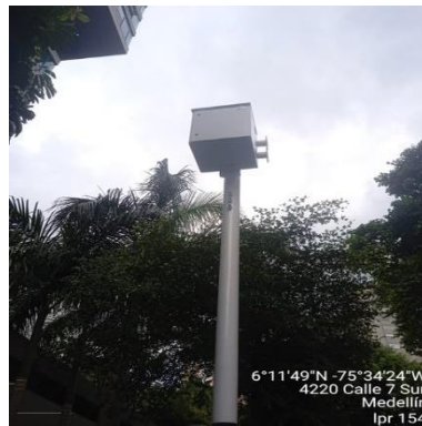
Ilustración 180 – LPR154, Instalación de gabinete
