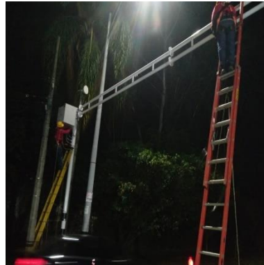
Ilustración 386 – LPR158, Cableado de cercha
