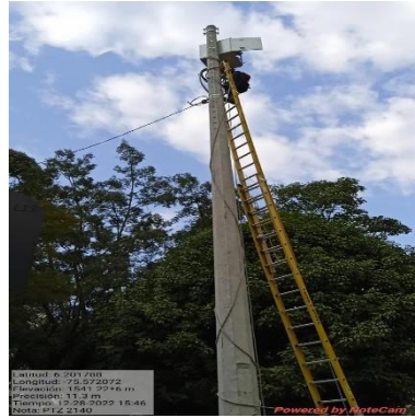
Ilustración 355 – P2140, Instalación de acometida
