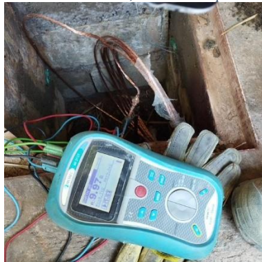
Ilustración 107 – LPR161, Instalación puesta tierra
