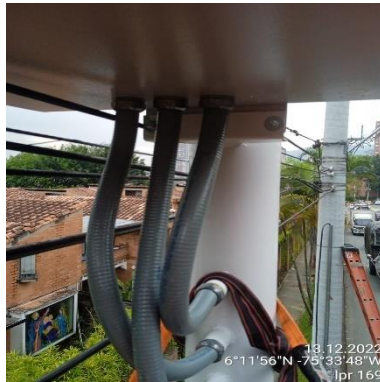
Ilustración 234 – LPR169, Instalación de acometida
