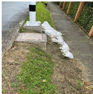
Ilustración 394 - LPR168, Recolección de escombros (Antes)
