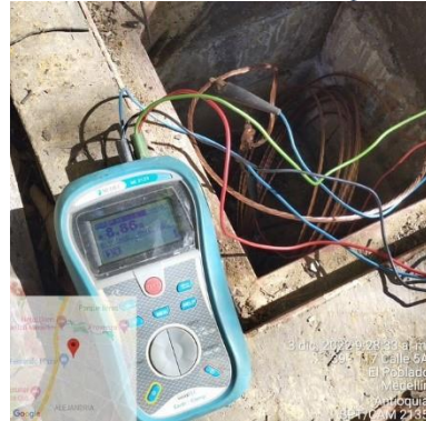
Ilustración 102 – P2135, Instalación puesta tierra
