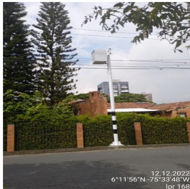
Ilustración 212 – LPR168, Montaje de gabinete
