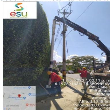
Ilustración 34 – LPR169, Instalación de vertical
