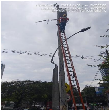
Ilustración 356 - P2139, Instalación de acometida
