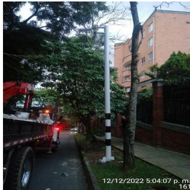
Ilustración 192 – LPR161, Hincado de verticales
