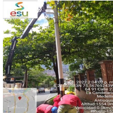
Ilustración 30 – LPR153, Instalación de vertical
