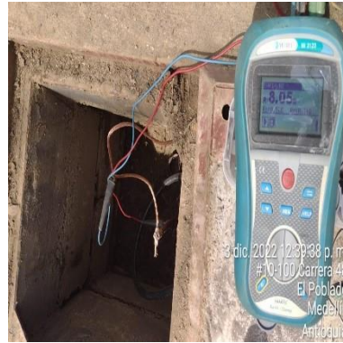
Ilustración 106 – LPR149, Instalación puesta tierra
