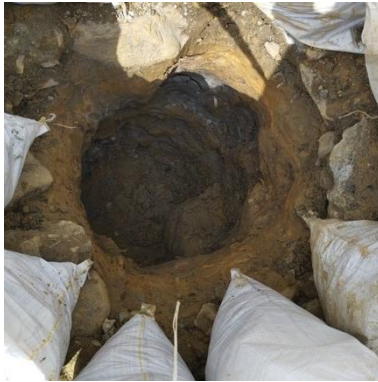
Ilustración 46 – P2156, Excavación para poste
