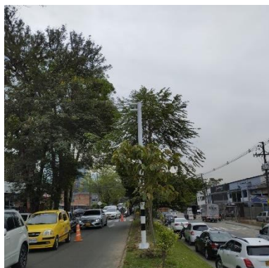
Ilustración 218 – LPR156, Hincado de verticales
