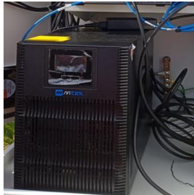
Ilustración 48 – P2150, Instalación de UPS
