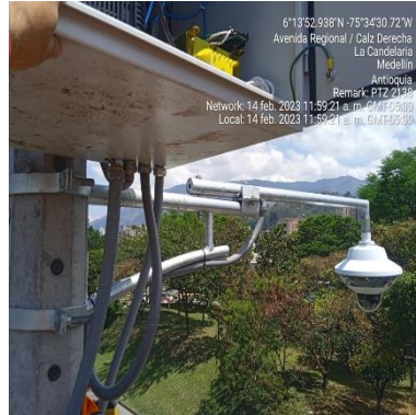
Ilustración 72 - P2138, Instalación de cámara Multisensor
