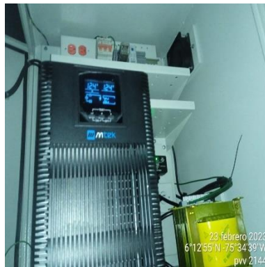
Ilustración 133 - P2144, Instalación de UPS
