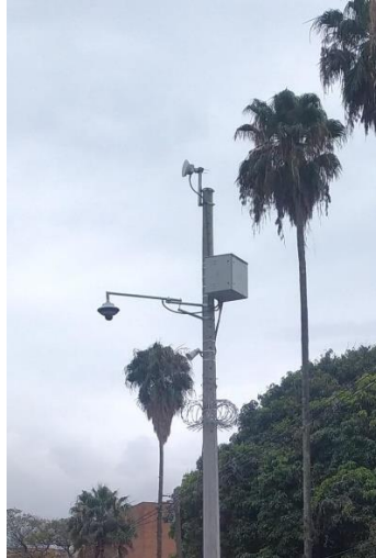
Ilustración 171 Instalación de equipos punto 2101.
