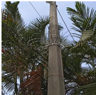
Ilustración 90 - P2150, Instalación de concertina y corona
