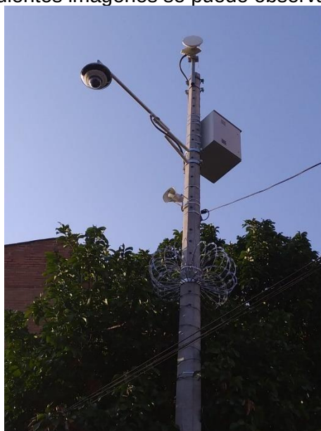
Ilustración 170 Instalación de equipos punto 2092.
