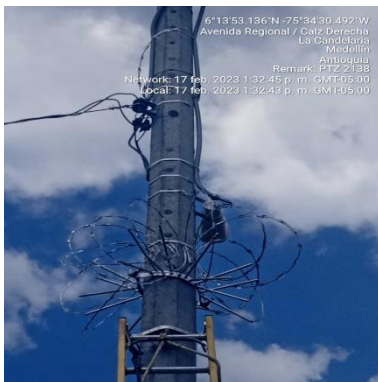
Ilustración 88 - P2138, Instalación de concertina y corona
