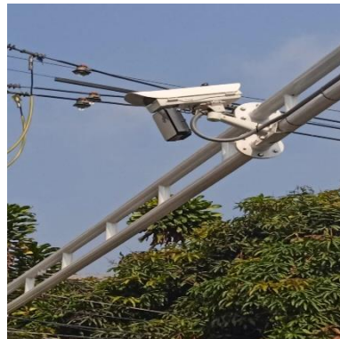
Ilustración 147 – LPR179-2, Instalación de cámara
