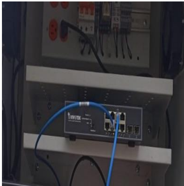
Ilustración 82 – LPR156, Instalación de Switch
