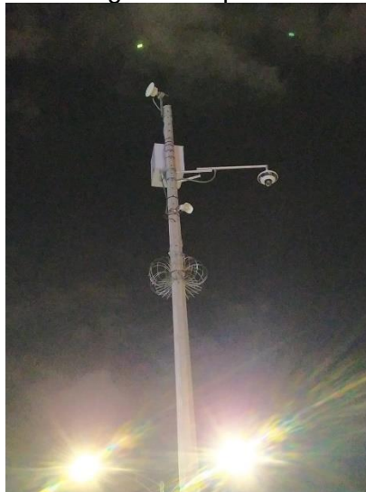
Ilustración 172 Instalación de equipos punto 2102.
