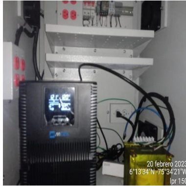
Ilustración 96 – LPR150, Instalación de UPS
