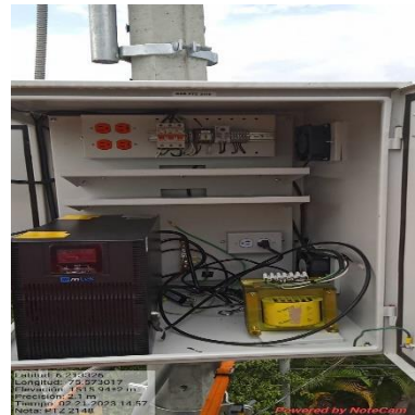
Ilustración 122 – P2148, Instalación de UPS
