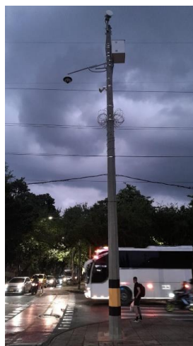
Ilustración 178 Instalación de equipos punto 2112.
