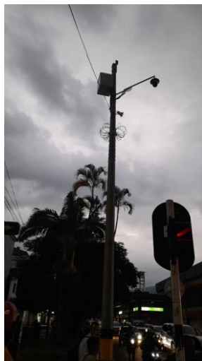
Ilustración 184 Instalación de equipos punto 2133.
