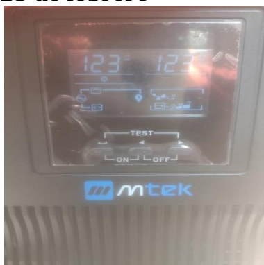
Ilustración 140 - P2141, Instalación de UPS
