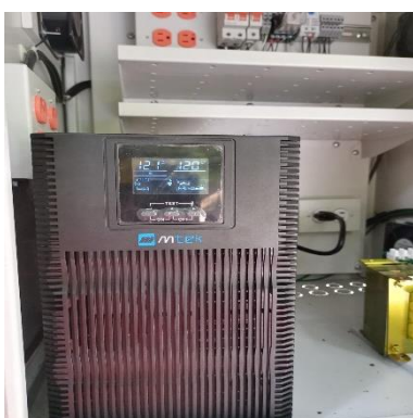
Ilustración 115 – LPR170, Instalación de UPS
