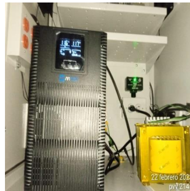
Ilustración 134 - P2145, Instalación de UPS
