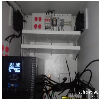
Ilustración 101 – LPR162, Instalación de UPS
