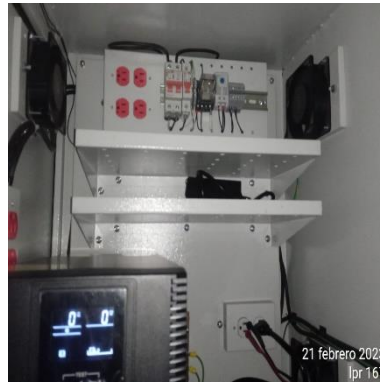
Ilustración 103 – LPR167, Instalación de UPS
