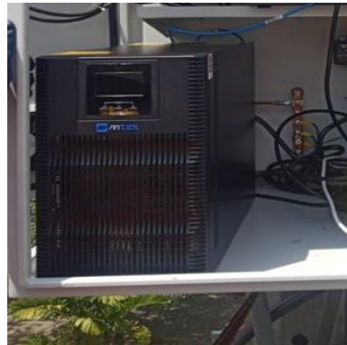
Ilustración 59 - P2151, Instalación de UPS
