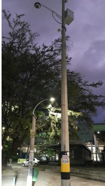
Ilustración 175 Instalación de equipos punto 2107.
