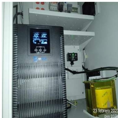
Ilustración 139 – P2136, Instalación de UPS
