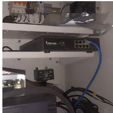
Ilustración 145 – LPR179, Instalación de Switch
