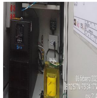
Ilustración 41 – P2147, Instalación de UPS
