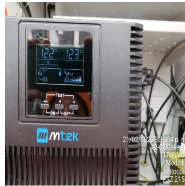
Ilustración 128 – P2164, Instalación de UPS
