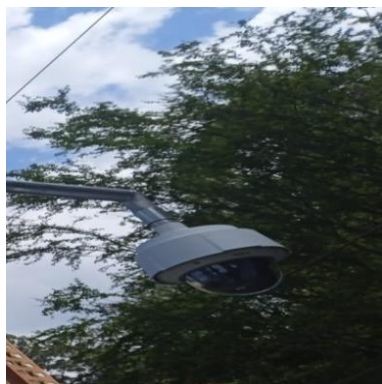
Ilustración 62 - P2163, Instalación de cámara PTZ
