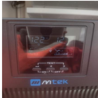
Ilustración 143 – P2158, Instalación de UPS
