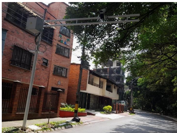
Ilustración 185 Instalación de equipos punto LPR-133.
