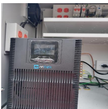
Ilustración 117 – LPR172, Instalación de UPS
