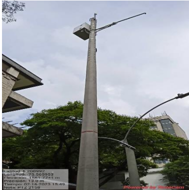
Ilustración 85 - P2158, Instalación de brazo soporte
