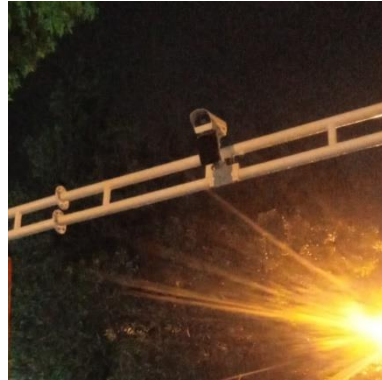
Ilustración 86 – LPR156, Instalación de cámara LPR-1
