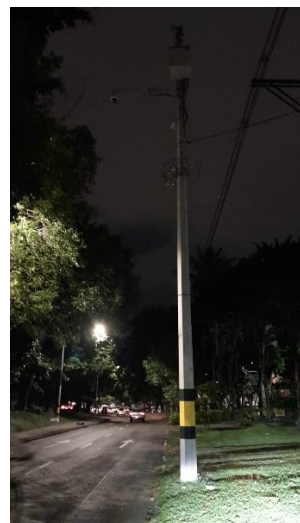
Ilustración 182 Instalación de equipos punto 2124.
