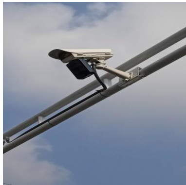
Ilustración 146 – LPR179-1, Instalación de cámara
