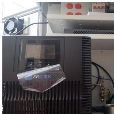
Ilustración 63 - P2163, Instalación de UPS
