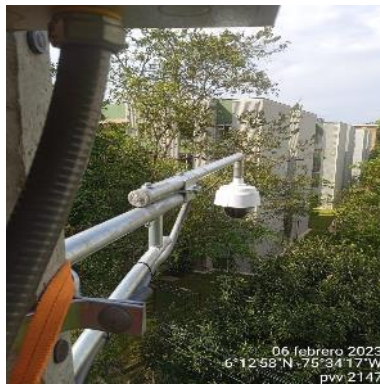
Ilustración 44 - P2147, Instalación de cámara PTZ
