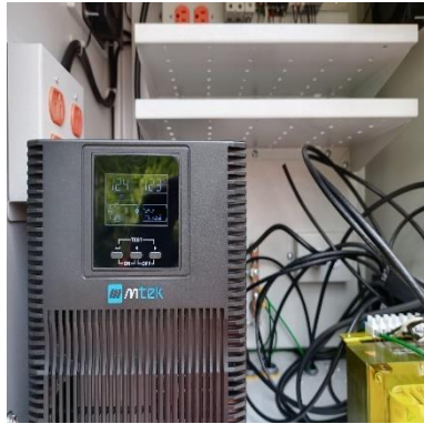
Ilustración 109 – LPR158, Instalación de UPS
