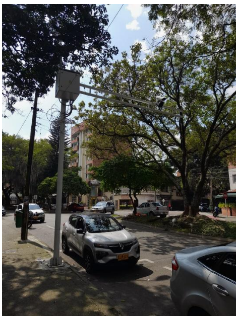
Ilustración 186 Instalación de equipos punto LPR-136.
