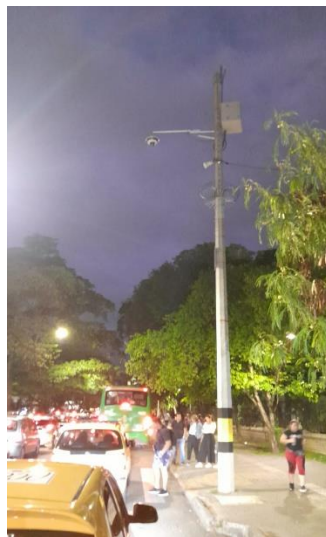
Ilustración 176 Instalación de equipos punto 2108.
