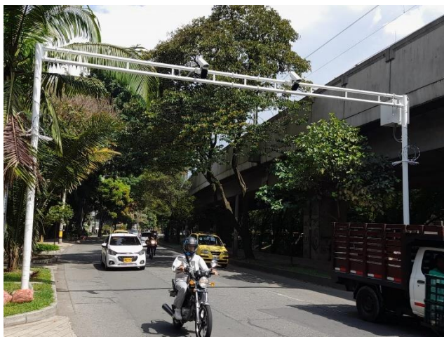
Ilustración 189. Instalación de equipos punto LPR-140.
