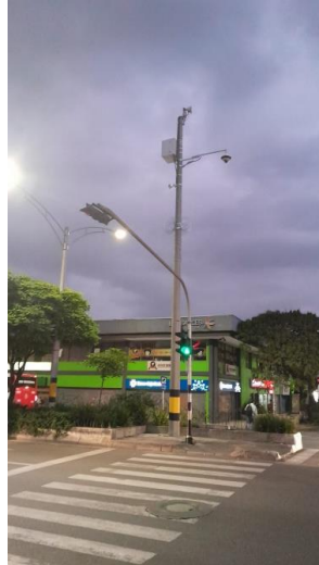
Ilustración 179 Instalación de equipos punto 2113.
