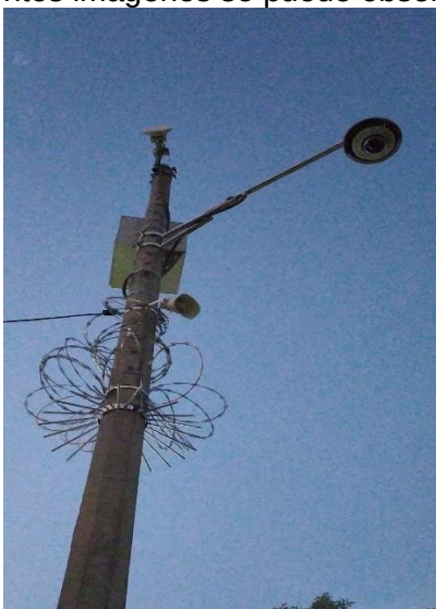
Ilustración 169 Instalación de equipos punto 2090.
