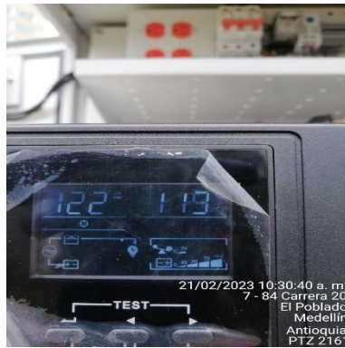
Ilustración 127 – P2161, Instalación de UPS
