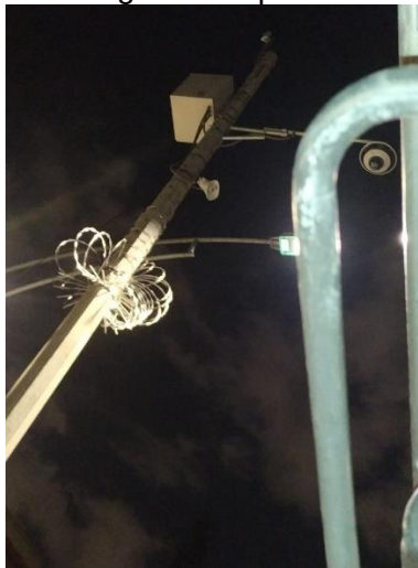
Ilustración 167 Instalación de equipos punto 2076.
