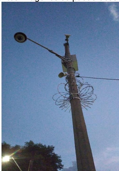
Ilustración 173 Instalación de equipos punto 2105.
