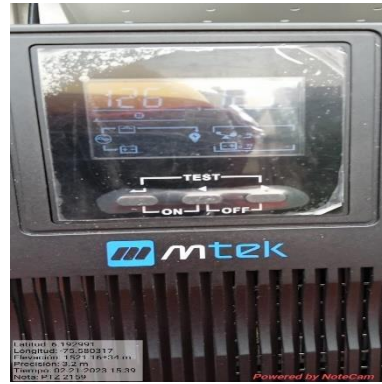
Ilustración 126 – P2159, Instalación de UPS
