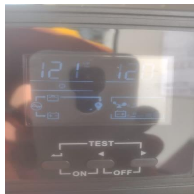
Ilustración 141 - P2149, Instalación de UPS
