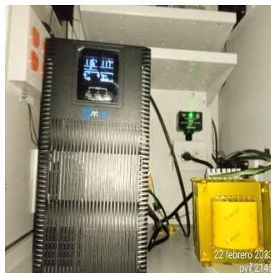
Ilustración 135 - P2146, Instalación de UPS
