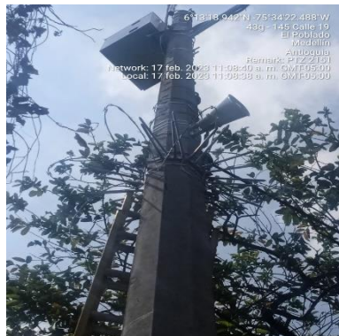
Ilustración 91 – P2151, Instalación de concertina y corona
