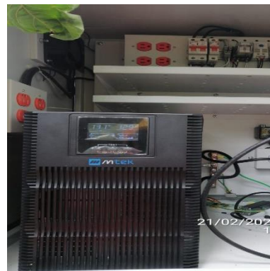
Ilustración 130 – P2167, Instalación de UPS
