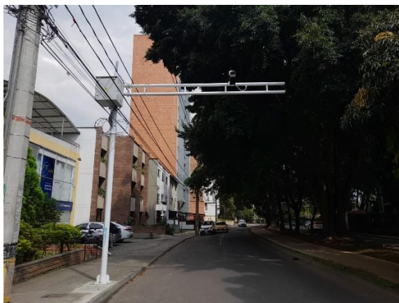
Ilustración 187 Instalación de equipos punto LPR-137
