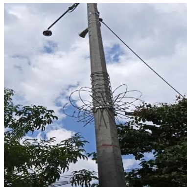
Ilustración 89 - P2147, Construcción de caja
