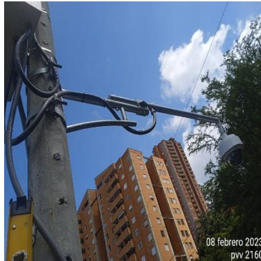
Ilustración 54 - P2160, Instalación de cámara PTZ
