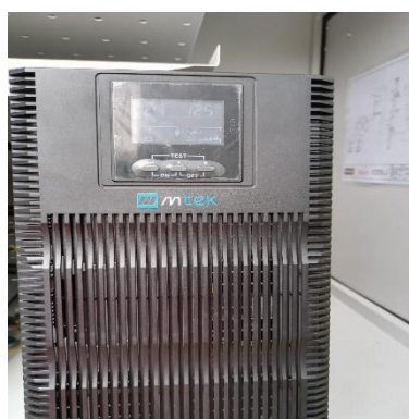
Ilustración 116 – LPR171, Instalación de UPS
