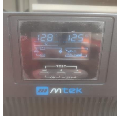
Ilustración 132 - P2143, Instalación de UPS
