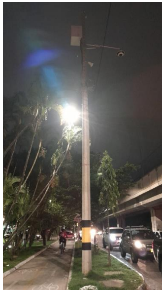
Ilustración 183 Instalación de equipos punto 2129.
