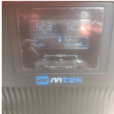
Ilustración 142 - P2153, Instalación de UPS
