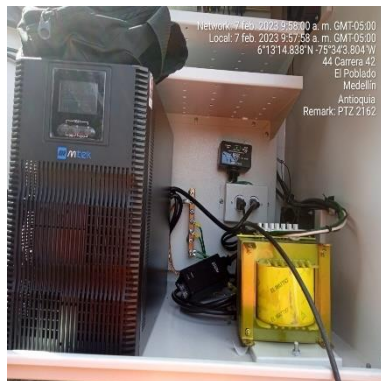
Ilustración 52 – P2162, Instalación de UPS
