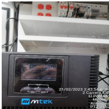
Ilustración 123 – P2152, Instalación de UPS
