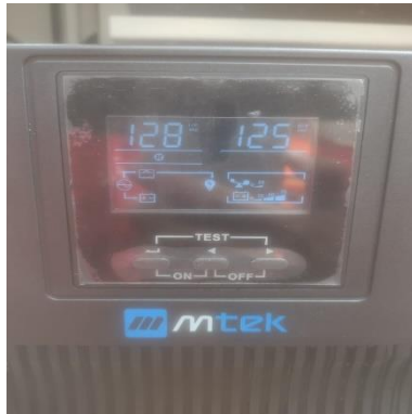
Ilustración 137 – P2157, Instalación de UPS
