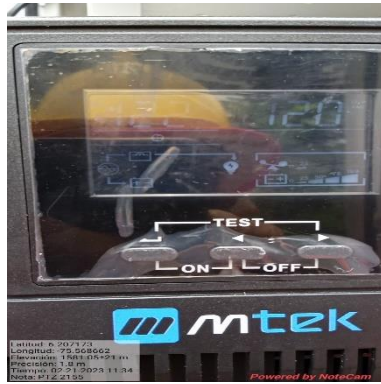
Ilustración 125 – P2155, Instalación de UPS
