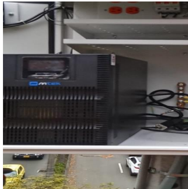
Ilustración 121 – P2140, Instalación de UPS
