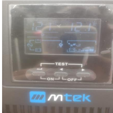
Ilustración 131 - P2142, Instalación de UPS
