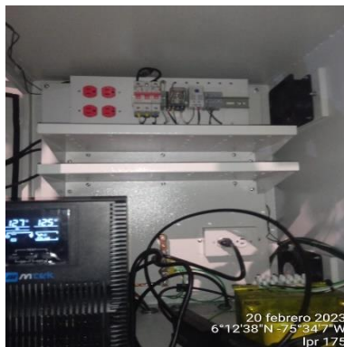
Ilustración 104 – LPR175, Instalación de UPS
