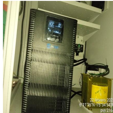
Ilustración 138 – P2165, Instalación de UPS
