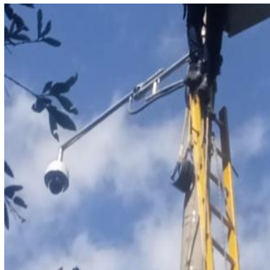
Ilustración 49 - P2162, Instalación de cámara PTZ
