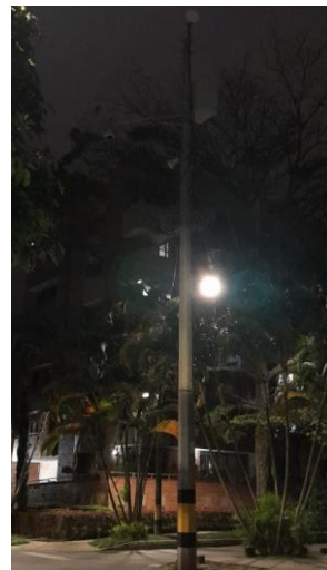
Ilustración 180 Instalación de equipos punto 2120.
