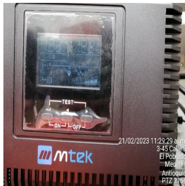
Ilustración 129 – P2166, Instalación de UPS
