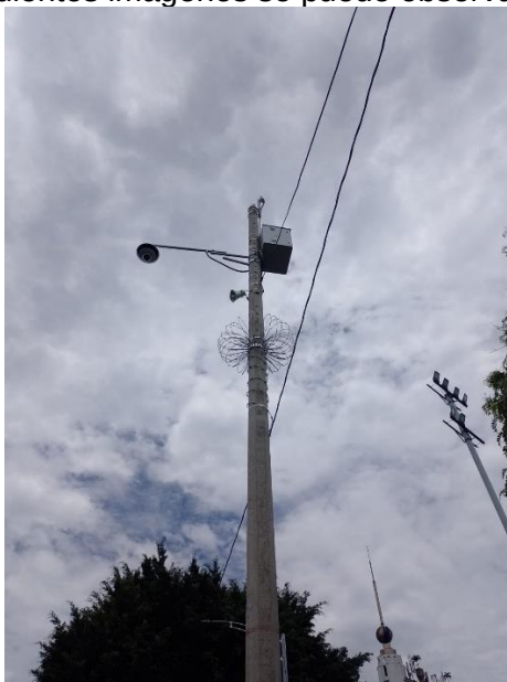
Ilustración 174 Instalación de equipos punto 2106.
