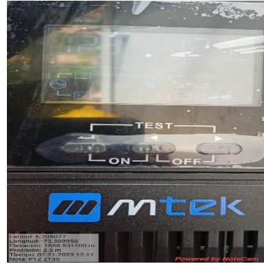
Ilustración 120 – P2135, Instalación de UPS
