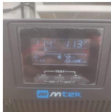
Ilustración 136 – P2156, Instalación de UPS
