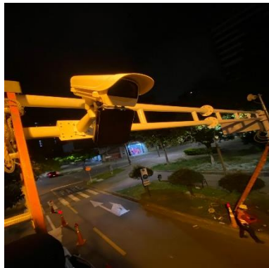
Ilustración 80 – LPR173, Instalación de cámara LPR-2
