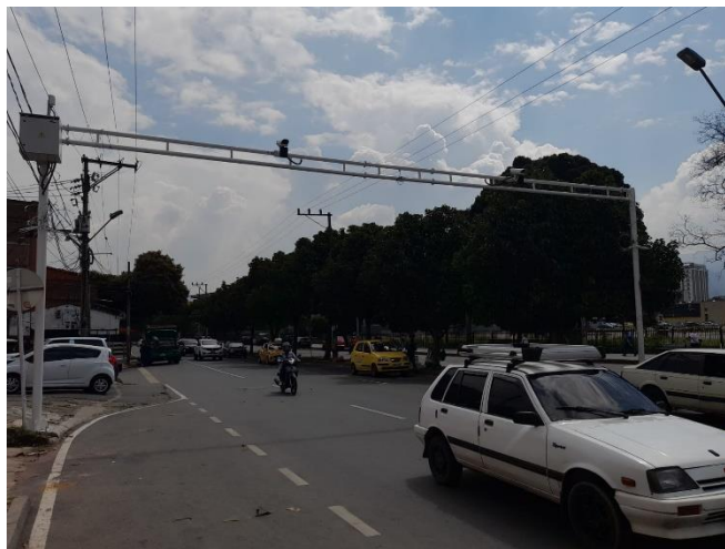
Ilustración 188. Instalación de equipos punto LPR-139.
