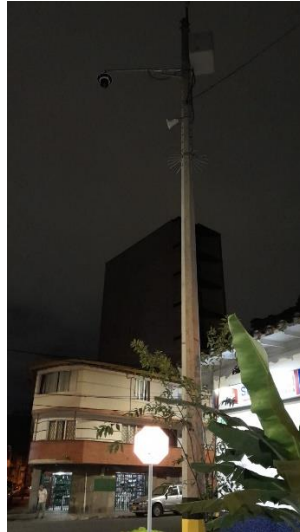
Ilustración 181 Instalación de equipos punto 2123.
