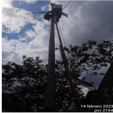
Ilustración 77 - P2154, Instalación de brazo soporte
