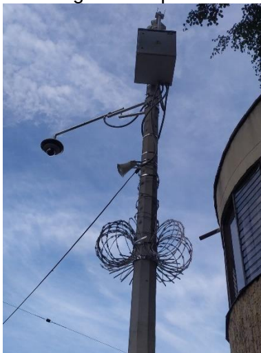
Ilustración 168 Instalación de equipos punto 2089.
