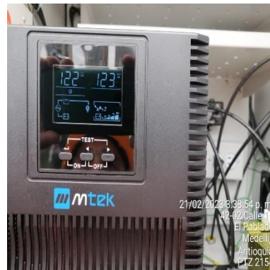
Ilustración 124 – P2154, Instalación de UPS
