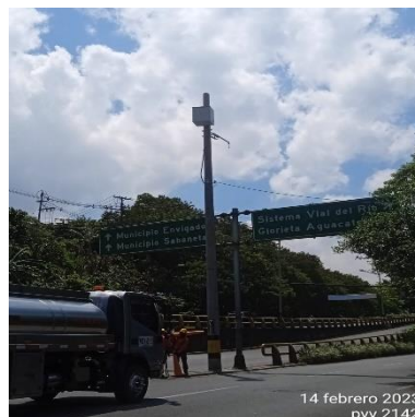
Ilustración 76 - P2142, Instalación de brazo soporte
