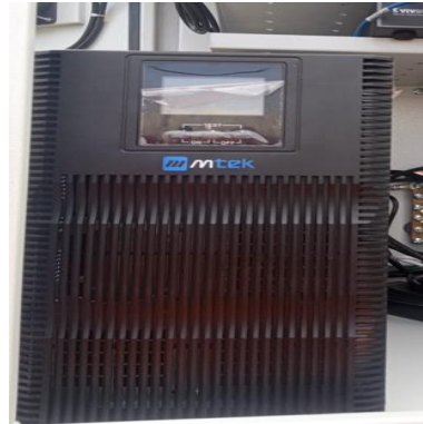
Ilustración 55 - P2160, Instalación de UPS
