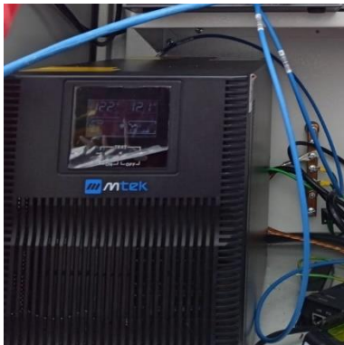
Ilustración 73 - P2138, Instalación de UPS
