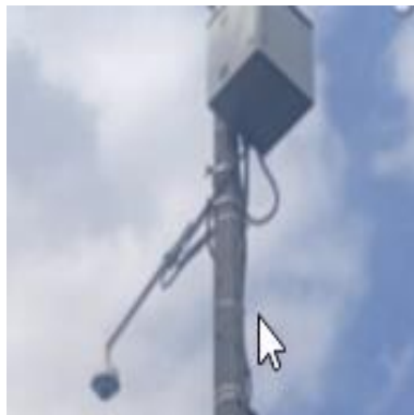
Ilustración 45 - P2150, Instalación de cámara PTZ
