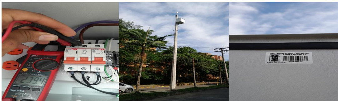
Ilustración 200 Instalacion de gabinete y energización de punto 2099.
