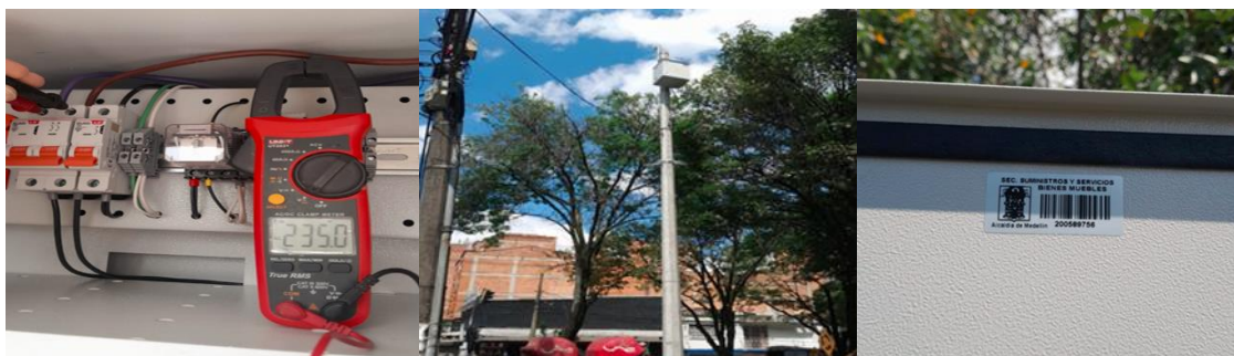
Ilustración 186 Instalación de gabinete y energización de punto 2081..
