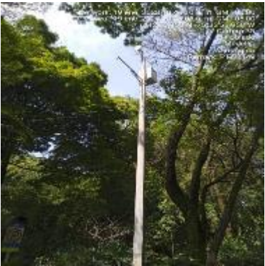
Ilustración 126 – P2149, Instalación de brazo
