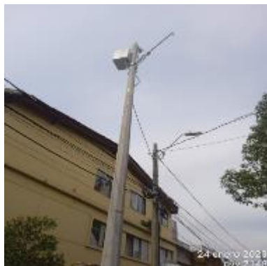
Ilustración 144 - P2148, Instalación de brazo
