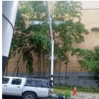
Ilustración 103 – LPR154, Instalación de concertina vertical lado opuesto
