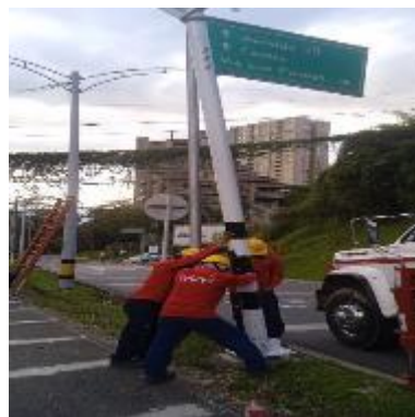
Ilustración 26 – LPR166, Instalación de vertical
