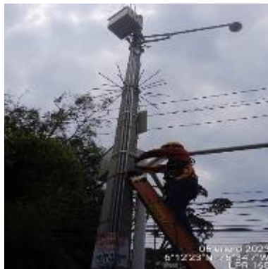
Ilustración 47 – LPR165, Instalación de cable trenza
