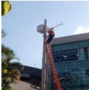
Ilustración 167 - P2145, Instalación de brazo
