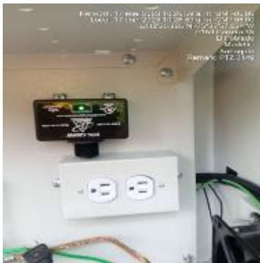
Ilustración 98 - P2149, Instalación de protector de voltaje
