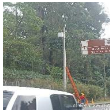
Ilustración 161 - P2167, Instalación de brazo
