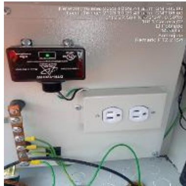
Ilustración 85 – P2154, Instalación de protector de sobrevoltaje
