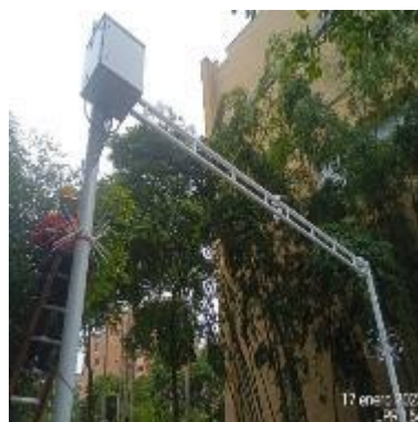
Ilustración 107 – LPR154, Instalación de coronas
