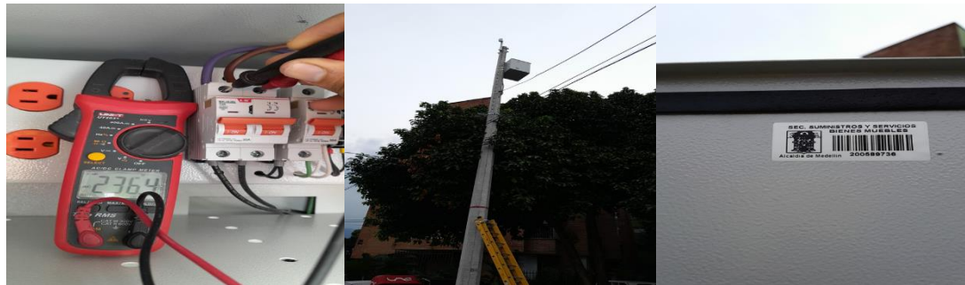
Ilustración 195 Instalación de gabinete y energización de punto 2092.
