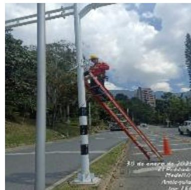
Ilustración 178 – LPR166, Instalación de coronas
