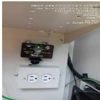
Ilustración 87 - P2167, Instalación de protector de sobrevoltaje
