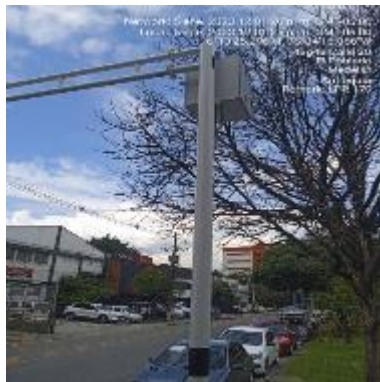
Ilustración 41 – LPR179, Instalación de gabinete
