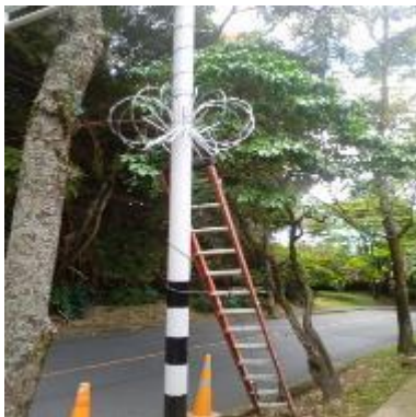
Ilustración 121 – LPR161, Instalación de concertina vertical lado opuesto
