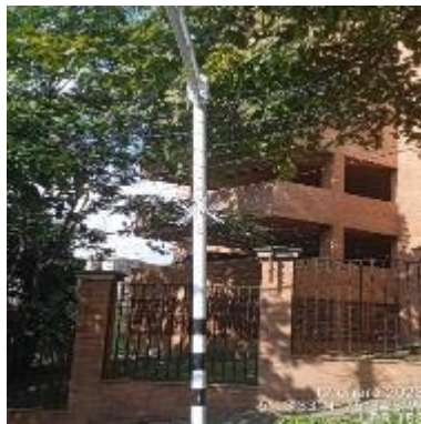
Ilustración 104 – LPR153, Instalación de concertina vertical lado opuesto
