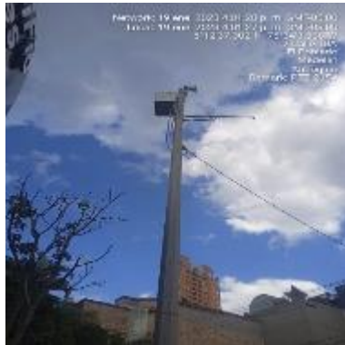
Ilustración 127 - P2154, Instalación de brazo
