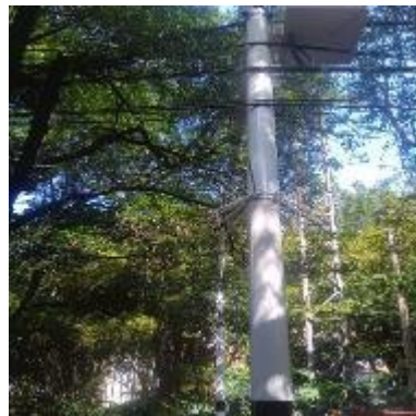
Ilustración 81 – LPR174, Instalación de coronas
