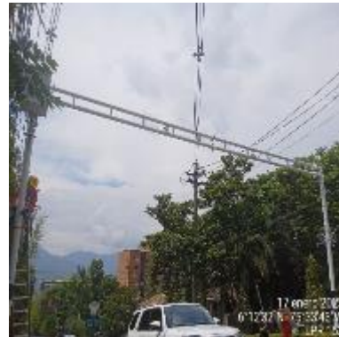
Ilustración 109 – LPR152, Instalación de coronas
