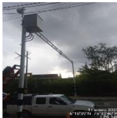
Ilustración 58 – LPR148, Instalación de coronas
