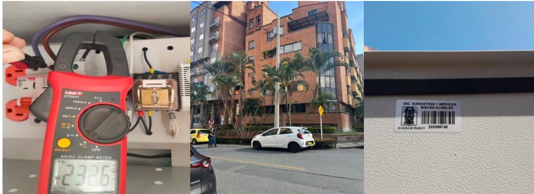
Ilustración 187 Instalación de gabinete y energización de punto 2082.
