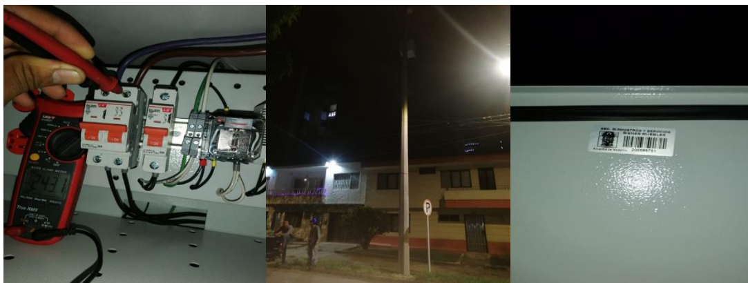
Ilustración 193 Instalación de gabinete y energización de punto 2090.
