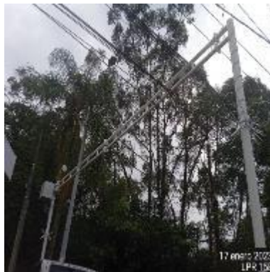
Ilustración 110 – LPR158, Instalación de coronas
