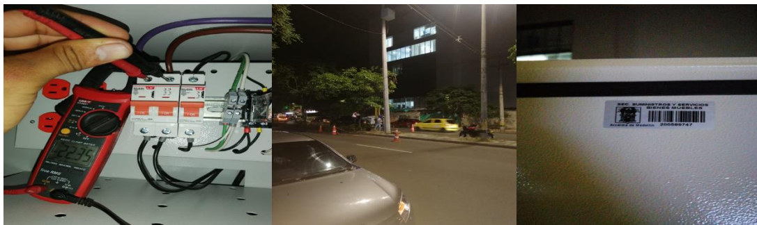
Ilustración 190 Instalación de gabinete y energización de punto 2086.
