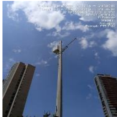
Ilustración 128 - P2161, Instalación de brazo
