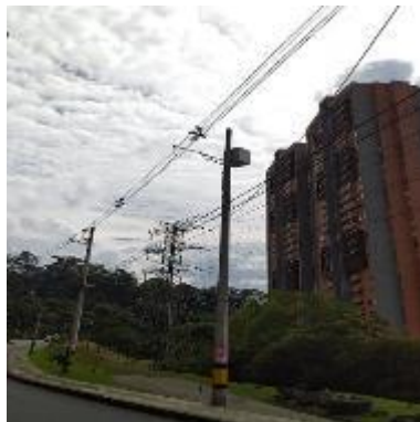
Ilustración 169 - P2160, Instalación de brazo
