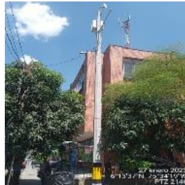
Ilustración 168 - P2146, Instalación de brazo
