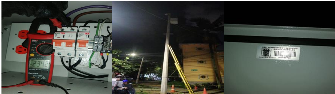
Ilustración 199 Instalacion de gabinete y energización de punto 2097.
