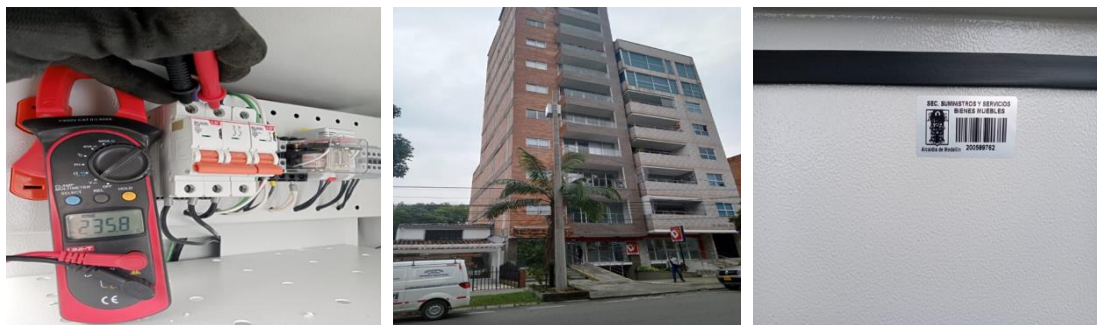
Ilustración 215 Instalación de gabinete y energización de punto 2128.
