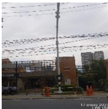
Ilustración 106 – LPR158, Instalación de concertina vertical lado opuesto
