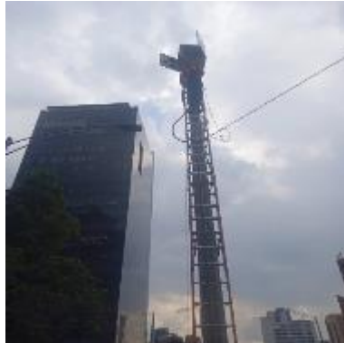
Ilustración 45 - P2166, Instalación de acometida
