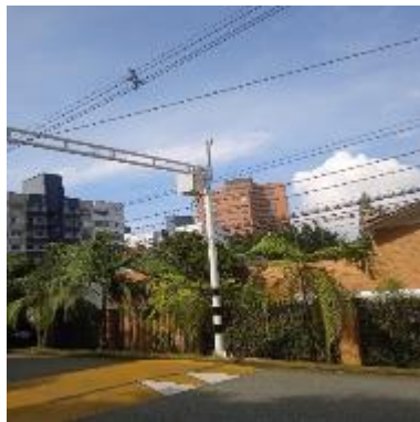
Ilustración 68 – LPR155, Instalación de coronas
