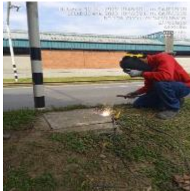
Ilustración 173 – P2165, Soldadura de caja
