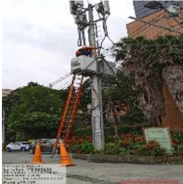
Ilustración 50 – LPR169, Instalación de cable trenza
