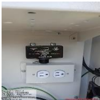
Ilustración 82 - P2150, Instalación de protector de sobrevoltaje
