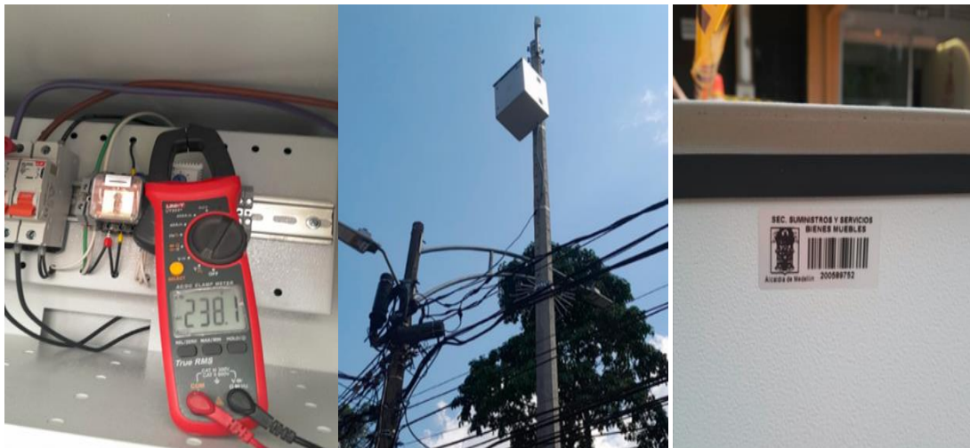
Ilustración 183 Instalación de gabinete y energización de punto 2076.
