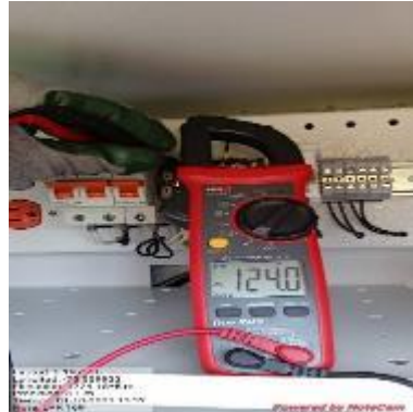
Ilustración 51 – LPR169, Energización de punto
