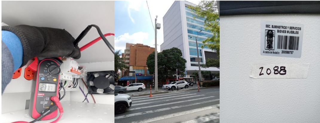
Ilustración 192 Instalación de gabinete y energización de punto 2088.
