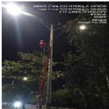
Ilustración 163 - P2136, Instalación de acometida
