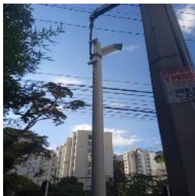
Ilustración 25 – LPR165, Instalación de vertical
