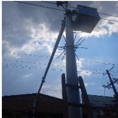
Ilustración 78 – LPR164, Instalación de coronas
