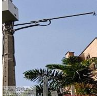
Ilustración 97 - P2150, Instalación de brazo
