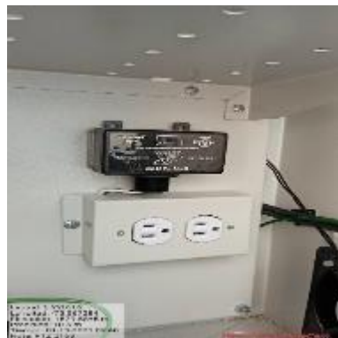
Ilustración 83 - P2163, Instalación de protector de sobrevoltaje
