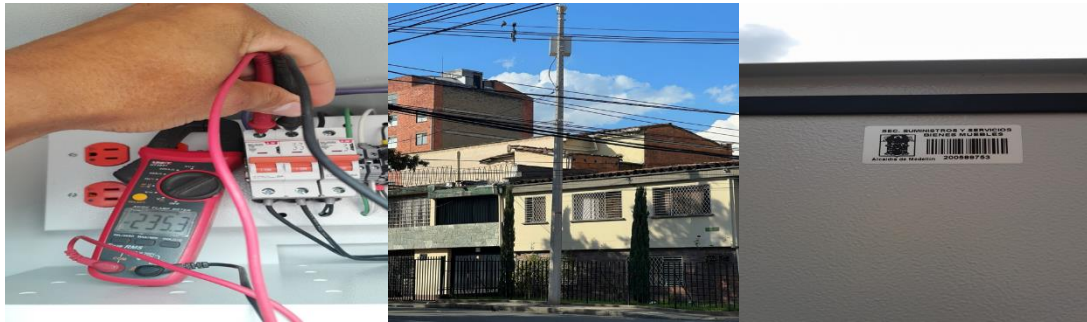
Ilustración 194 Instalación de gabinete y energización de punto 2091.
