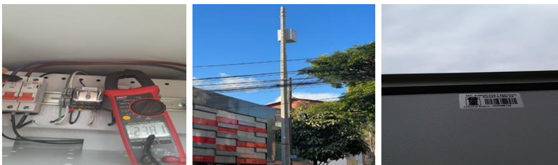
Ilustración 206. Instalación de gabinete y energización de punto 2114.
