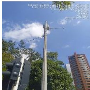
Ilustración 131 - P2140, Instalación de brazo
