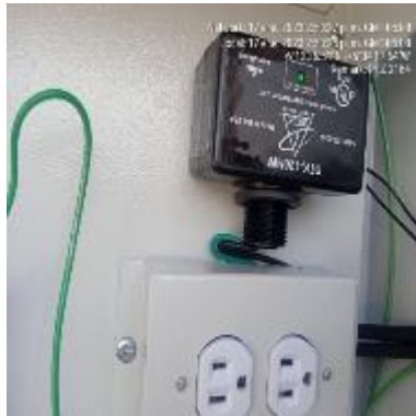
Ilustración 102 - P2164, Instalación de protector de voltaje
