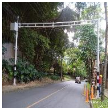
Ilustración 124 – LPR161, Instalación de coronas
