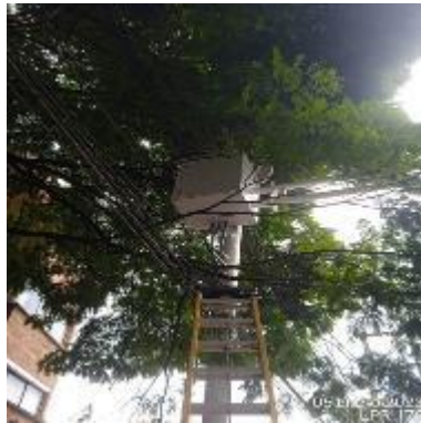
Ilustración 39 – LPR170, Instalación de gabinete
