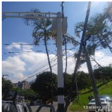
Ilustración 80 – LPR149, Instalación de coronas
