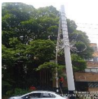
Ilustración 117 - LPR170, Instalación de coronas
