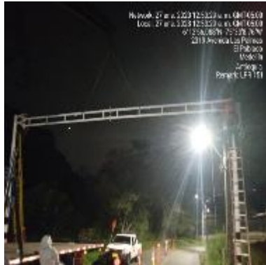
Ilustración 156 – LPR151, Instalación de cercha
