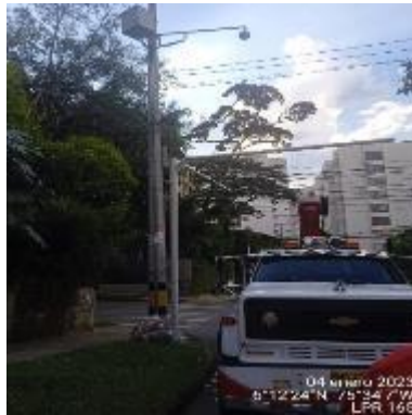
Ilustración 27 – LPR165, Instalación de horizontal
