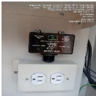
Ilustración 111 - P2145, Instalación de protector de voltaje
