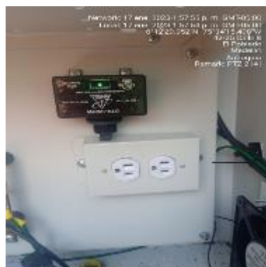
Ilustración 101 - P2141, Instalación de protector de voltaje
