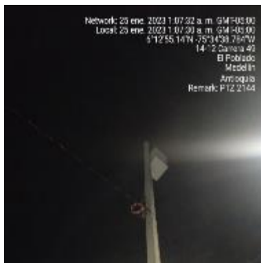
Ilustración 150 - P2144, Instalación de acometida
