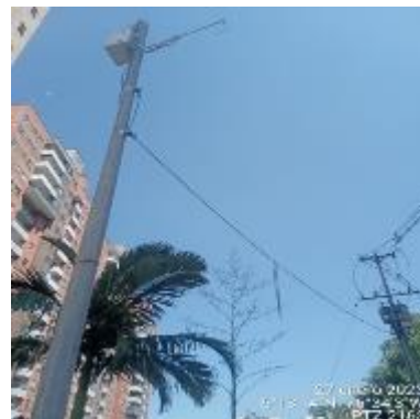
Ilustración 166 - P2163, Instalación de brazo
