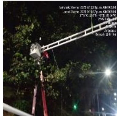
Ilustración 157 – LPR166, Instalación de cercha
