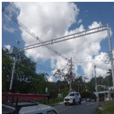
Ilustración 177 – LPR151, Instalación de coronas
