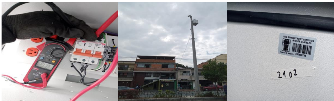
Ilustración 201 Instalación de gabinete y energización de punto 2102.
