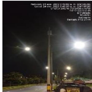
Ilustración 147 – P2144, Instalación de brazo
