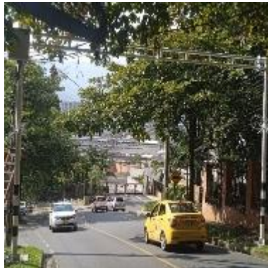
Ilustración 108 – LPR153, Instalación de coronas
