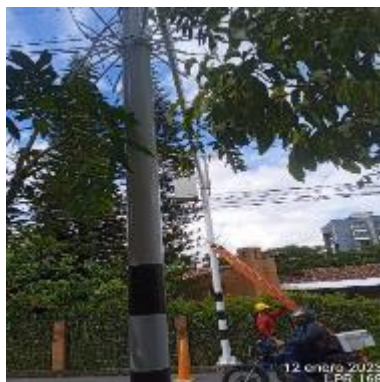
Ilustración 70 – LPR168, Instalación de coronas
