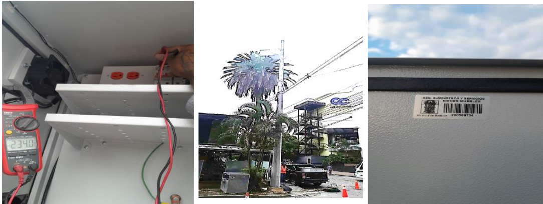
Ilustración 197 Instalacion de gabinete y energización de punto 2094.
