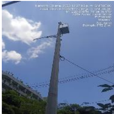
Ilustración 132 - P2141, Instalación de brazo
