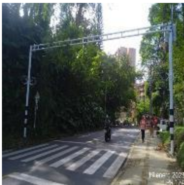
Ilustración 123 – LPR174, Instalación de coronas
