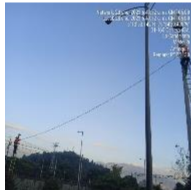
Ilustración 164 - P2138, Instalación de acometida
