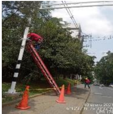
Ilustración 179 – LPR178, Instalación de coronas
