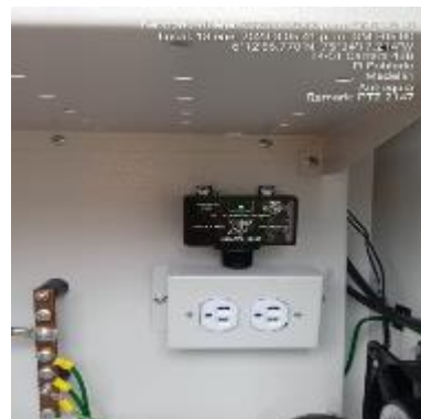
Ilustración 112 - P2147, Instalación de protector de voltaje
