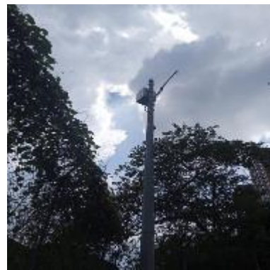
Ilustración 159 – P2151, Instalación de brazo
