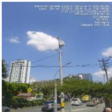
Ilustración 130 - P2139, Instalación de brazo
