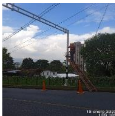
Ilustración 118 - LPR182, Instalación de coronas
