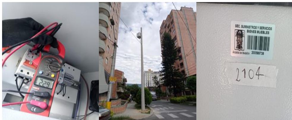
Ilustración 203 Instalación de gabinete y energización de punto 2104.
