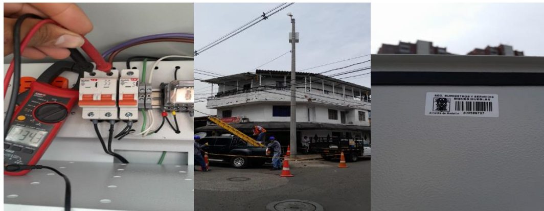
Ilustración 188 Instalación de gabinete y energización de punto 2083.
