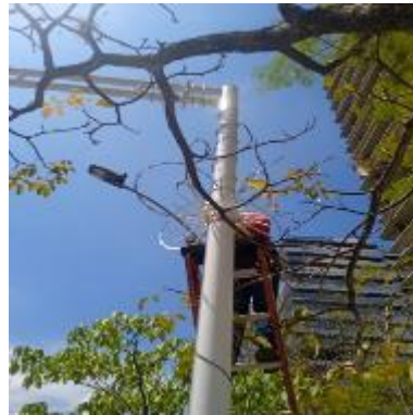
Ilustración 75 – LPR173, Instalación de concertina en vertical lado opuesto
