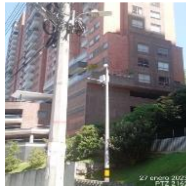
Ilustración 170 - P2162, Instalación de brazo
