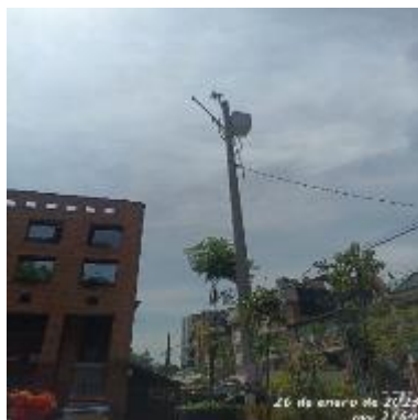
Ilustración 160 - P2164, Instalación de brazo
