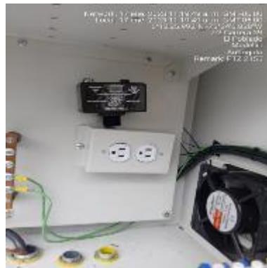
Ilustración 99 - P2155, Instalación de protector de voltaje
