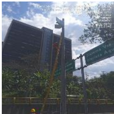
Ilustración 11 - P2142, Instalación de acometida
