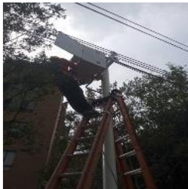
Ilustración 35 – LPR178, Instalación de acometida
