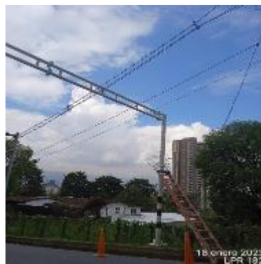
Ilustración 116 - LPR182, Instalación de concertina vertical lado opuesto
