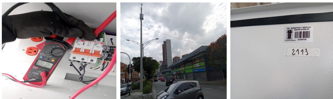
Ilustración 205. Instalación de gabinete y energización de punto 2113.
