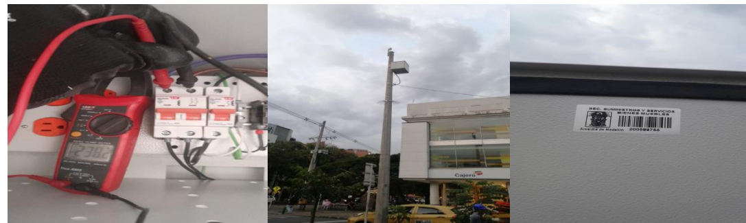
Ilustración 196 Instalación de gabinete y energización de punto 2093.
