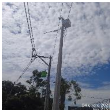
Ilustración 145 - P2152, Instalación de brazo
