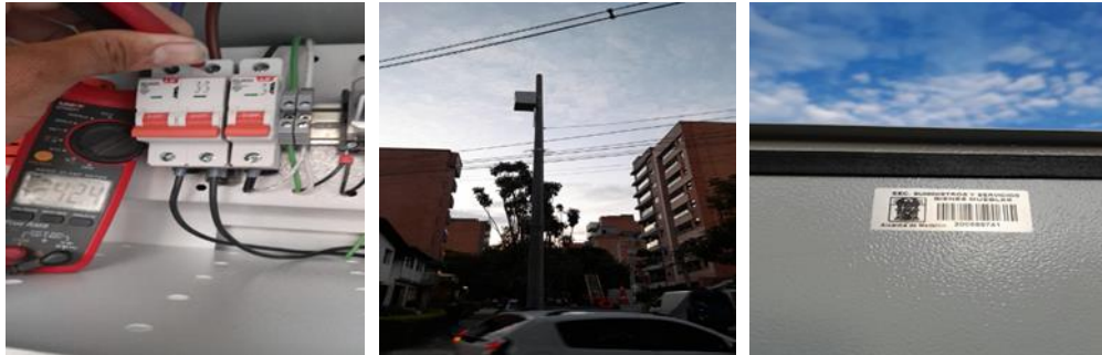
Ilustración 207 Instalación de gabinete y energización de punto 2115
