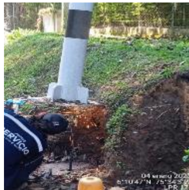
Ilustración 24 – LPR171, Perforación en base del vertical
