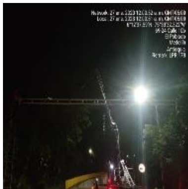
Ilustración 158 – LPR178, Instalación de cercha
