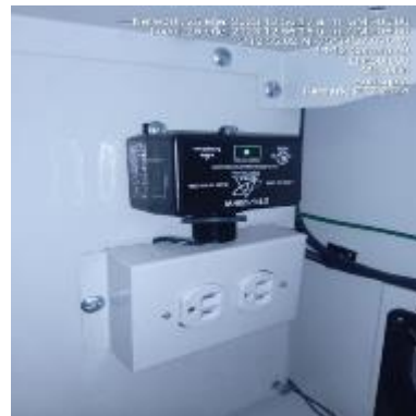
Ilustración 149 - P2144, Instalación de protector de voltaje
