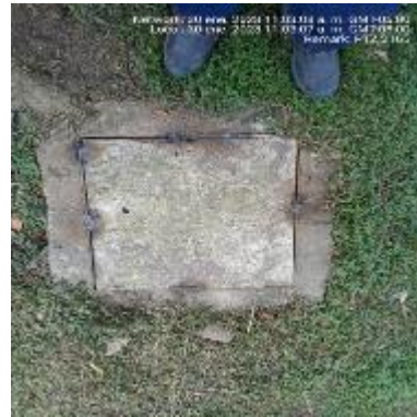
Ilustración 174 - P2165, Soldadura de caja
