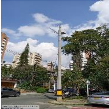
Ilustración 96 - P2156, Instalación de brazo
