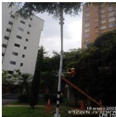
Ilustración 115 - LPR170, Instalación de concertina vertical lado opuesto
