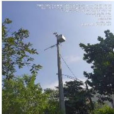
Ilustración 125 - P2147, Instalación de brazo
