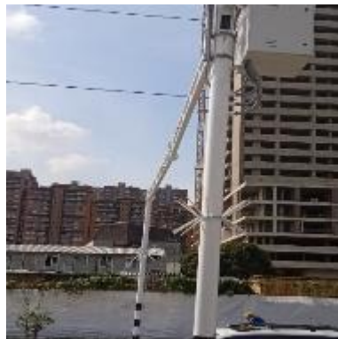
Ilustración 95 – LPR184, Instalación de coronas
