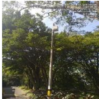
Ilustración 133 - P2157, Instalación de brazo
