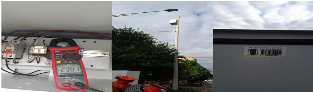
Ilustración 189 Instalación de gabinete y energización de punto 2085
