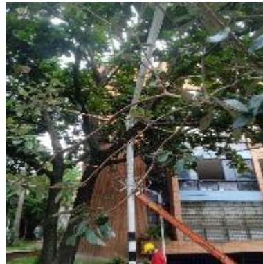
Ilustración 67 – LPR183, Instalación de coronas
