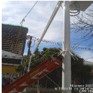
Ilustración 93 – LPR156, Instalación de coronas
