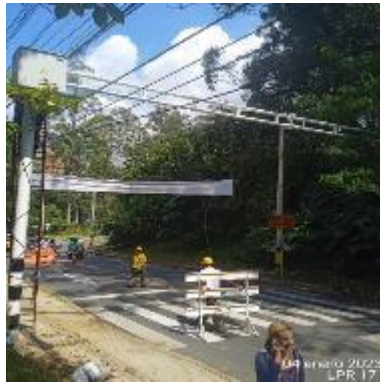
Ilustración 33 – LPR171, Instalación de cercha
