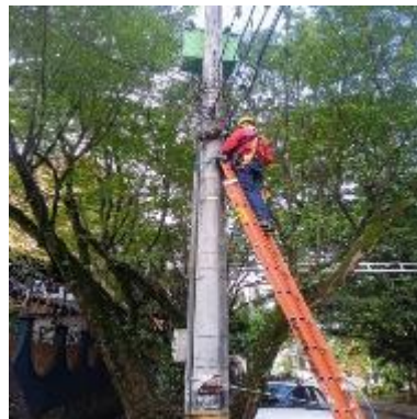
Ilustración 48 – LPR174, Instalación de cable trenza
