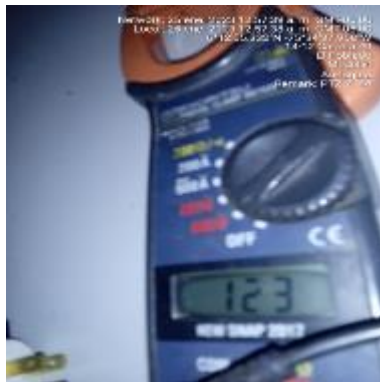
Ilustración 148 - P2144, Energización de punto
