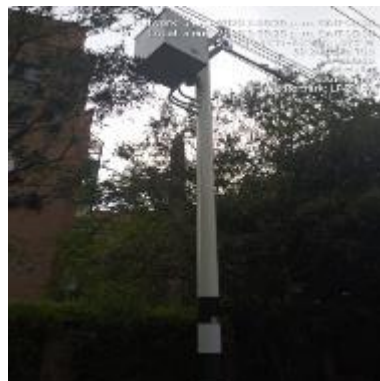
Ilustración 38 – LPR178, Instalación de gabinete
