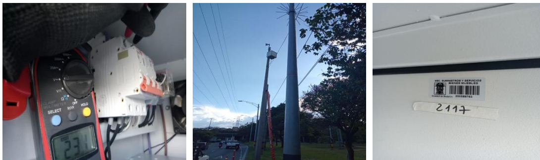
Ilustración 208 Instalación de gabinete y energización de punto 2117.
