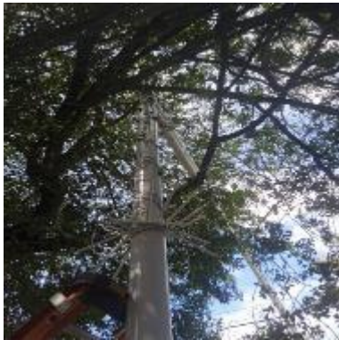
Ilustración 92 – LPR150, Instalación de coronas
