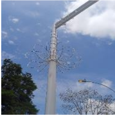
Ilustración 119 – LPR169, Instalación de concertina vertical lado opuesto
