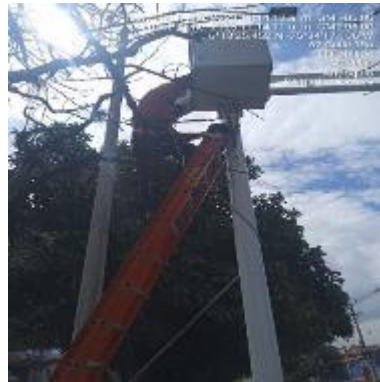
Ilustración 34 – LPR179, Instalación de acometida
