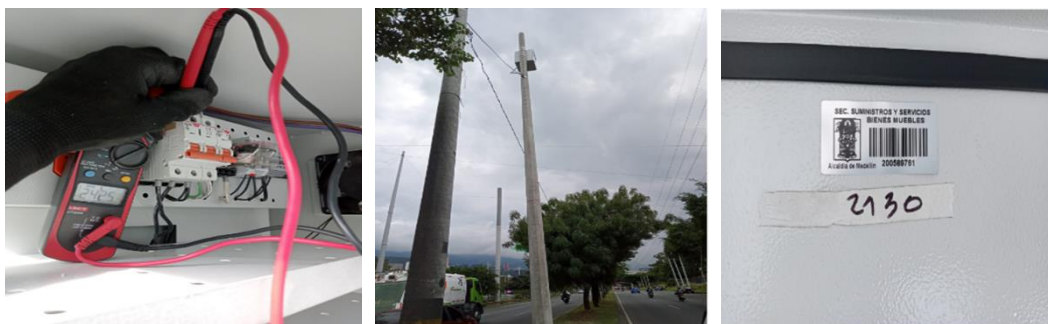
Ilustración 216 Instalación de gabinete y energización de punto 2130.
