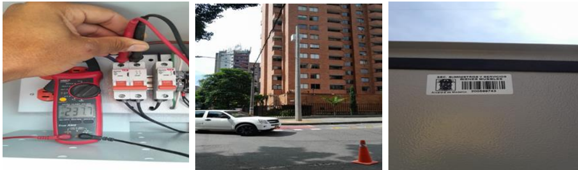
Ilustración 204. Instalación de gabinete y energización de punto 2112.
