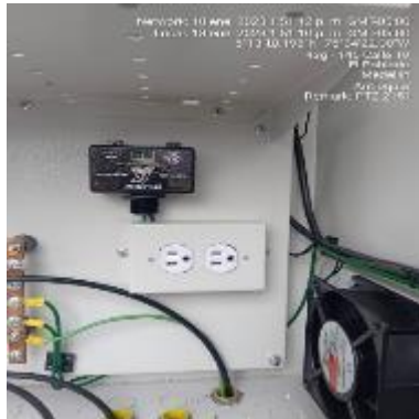
Ilustración 113 - P2151, Instalación de protector de voltaje
