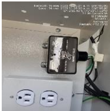
Ilustración 86 - P2158, Instalación de protector de sobrevoltaje
