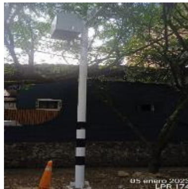
Ilustración 42 – LPR174, Instalación de gabinete
