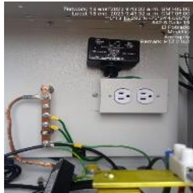
Ilustración 114 - P2162, Instalación de protector de voltaje
