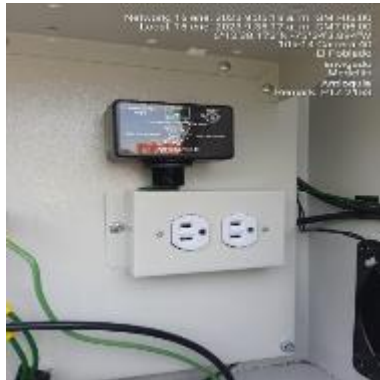
Ilustración 84 - P2153, Instalación de protector de sobrevoltaje
