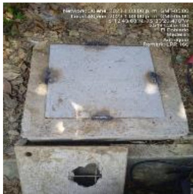
Ilustración 175 – LPR166, Soldadura de caja
