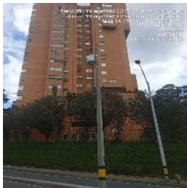
Ilustración 129 - P2166, Instalación de brazo
