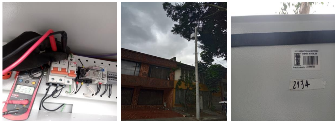
Ilustración 218 Instalación de gabinete y energización de punto 2134.
