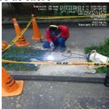
Ilustración 171 - P2165, Soldadura de caja
