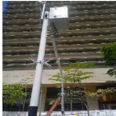
Ilustración 79 – LPR173, Instalación de coronas
