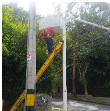
Ilustración 37 – LPR165, Instalación de acometida
