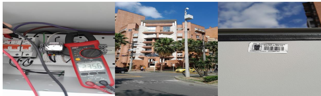
Ilustración 191 Instalación de gabinete y energización de punto 2087.
