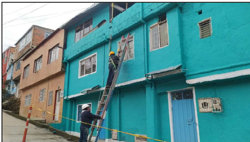
Ilustración 23 Trabajo en alturas pintura de fachada
