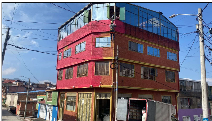
Ilustración 24 trabajo en alturas pintura de fachada
