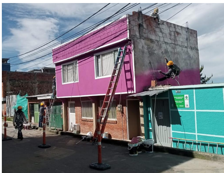
Ilustración 16 Trabajo en alturas en lateral
