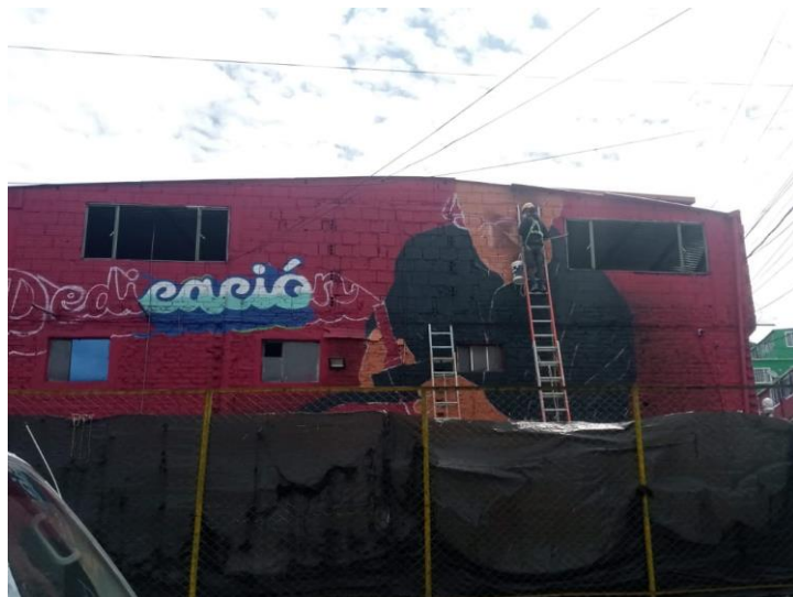
Ilustración 22 Ejecución de mural
