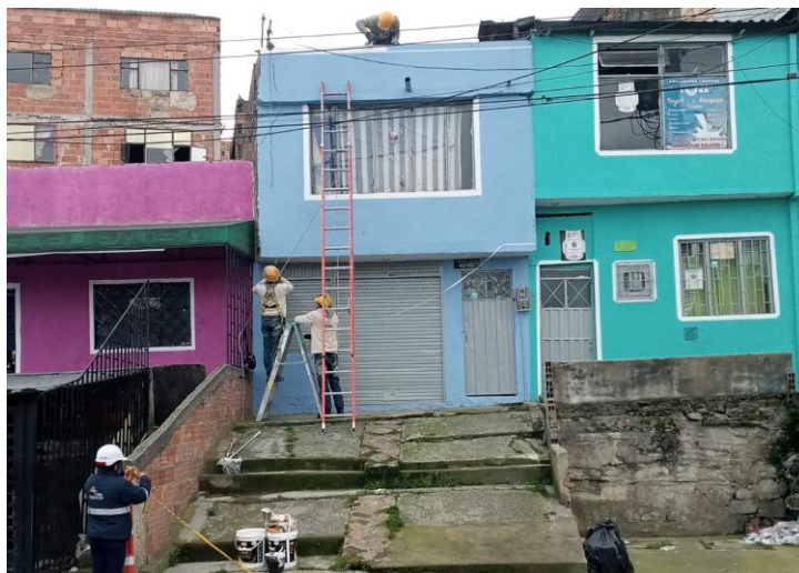
Ilustración 15 Trabajo en alturas pintura de fachada
