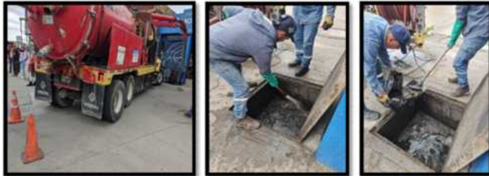
Ilustración 5. Mantenimiento cajas de inspección. Tomado en el mes de enero del 2023.
