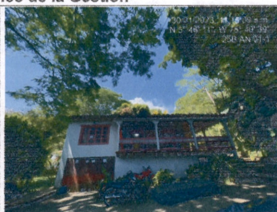
Ilustración 12. Oficina contratista km 7
