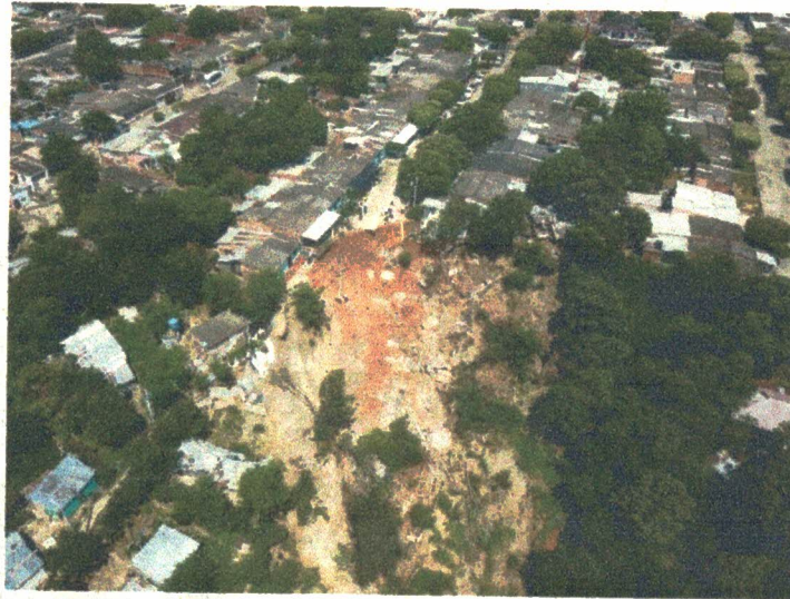
Figura 2. Estado Actual punto crítico No1 , (Vista Superior).
