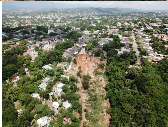
Figura 1. Estado Actual punto critico No1 , (Vista Superior).
