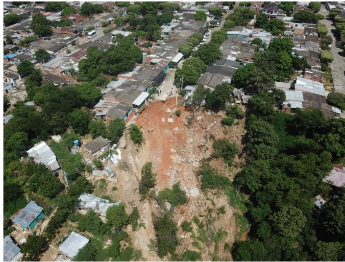
Figura 2. Estado Actual punto crítico No1 , (Vista Superior).
