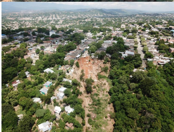
Figura 1. Estado Actual punto critico No1 , (Vista Superior).
