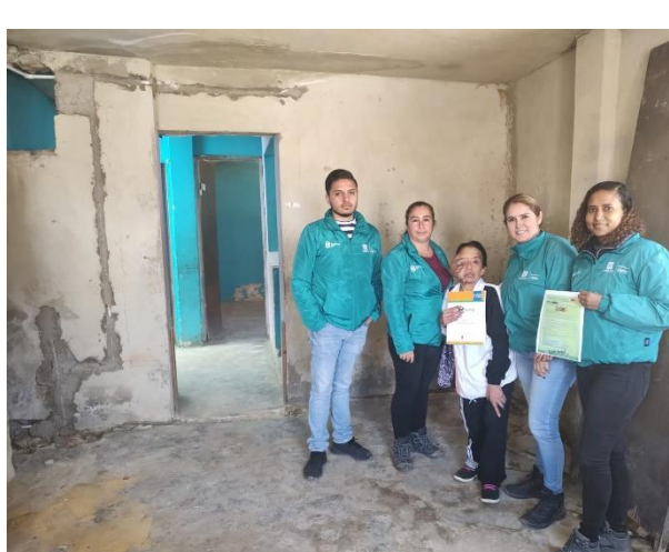
Actividad: Apertura de obra MVBF_0938
