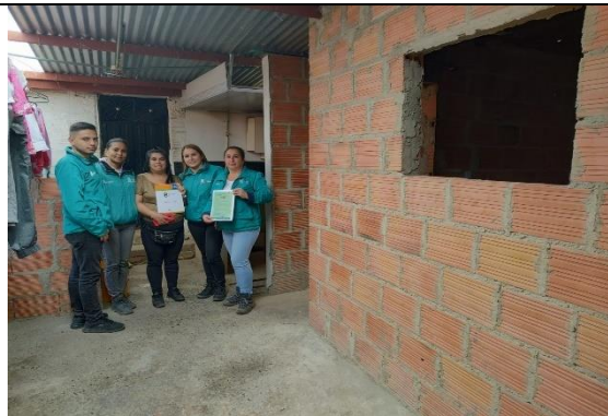
Actividad: Apertura de obra MVBF_0837 Fecha: 13/02/2023
