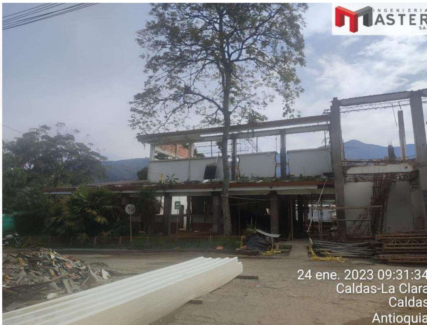
VISTA GENERAL INTERVENCIÓN DE REFORZAMIENTO ESTRUCTURAL EDIFICIO 16.
