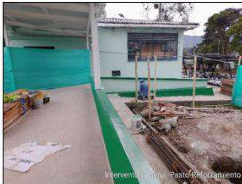
Aplicación de pintura acrílica (Tipo Koraza para fachada)
