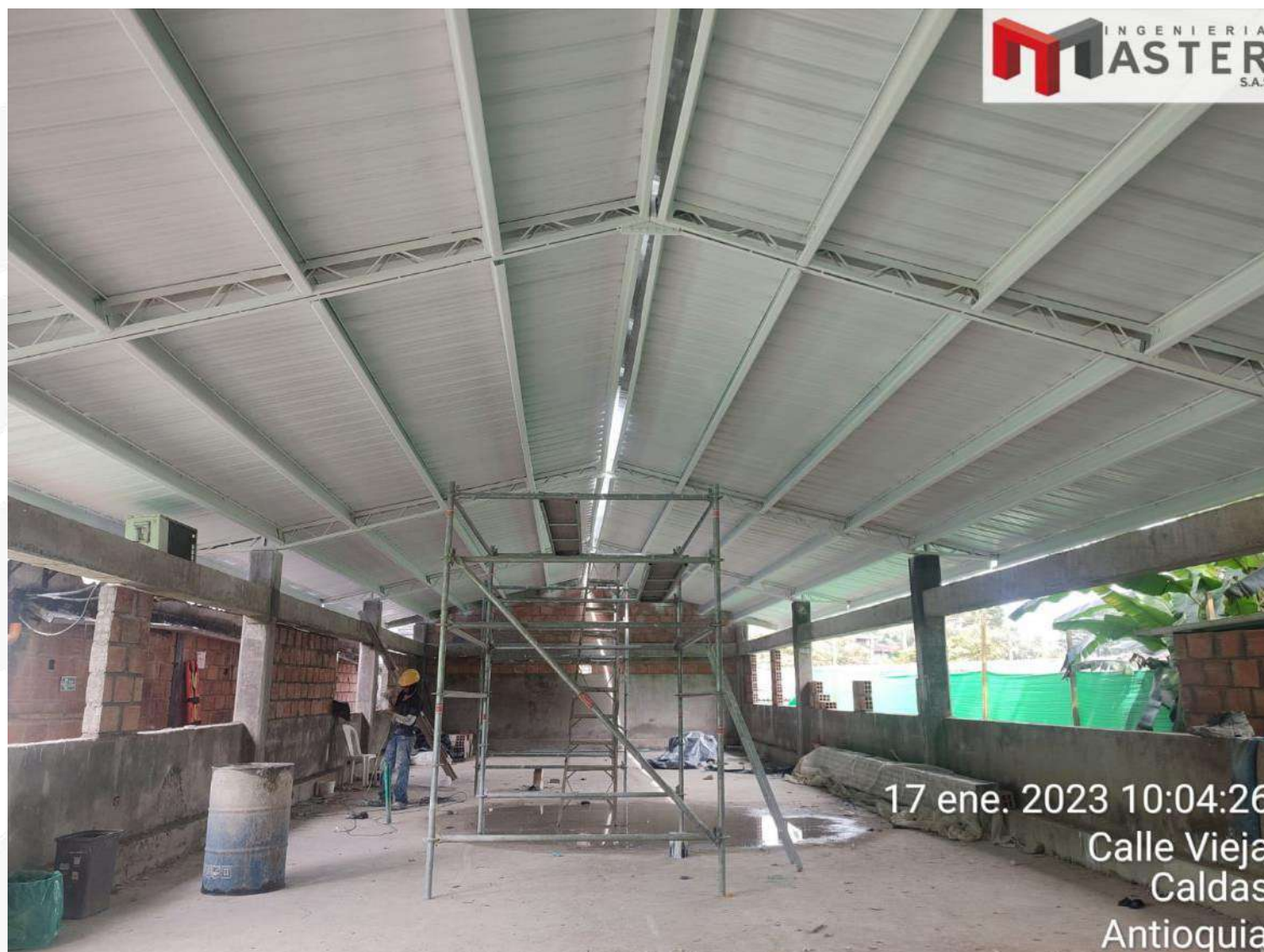
VISTA GENERAL INTERVENCIÓN DE REFORZAMIENTO ESTRUCTURAL EDIFICIO 42.
