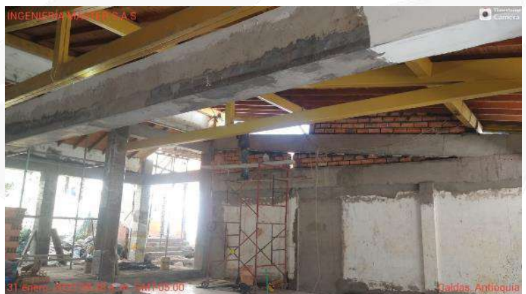
VISTA GENERAL INTERVENCIÓN DE REFORZAMIENTO ESTRUCTURAL EDIFICIO 16.
