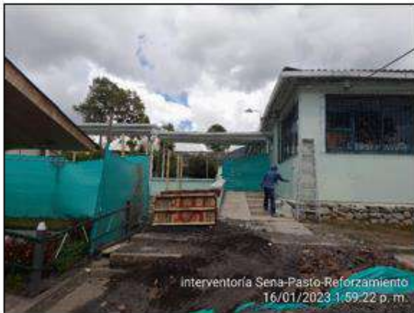
Aplicación de pintura acrílica (Tipo Koraza para fachada)
