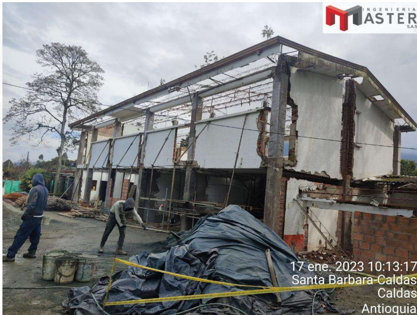
VISTA GENERAL INTERVENCIÓN DE REFORZAMIENTO ESTRUCTURAL EDIFICIO 16.
