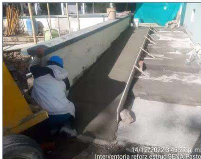
Concreto 3000 psi para rampa acceso
