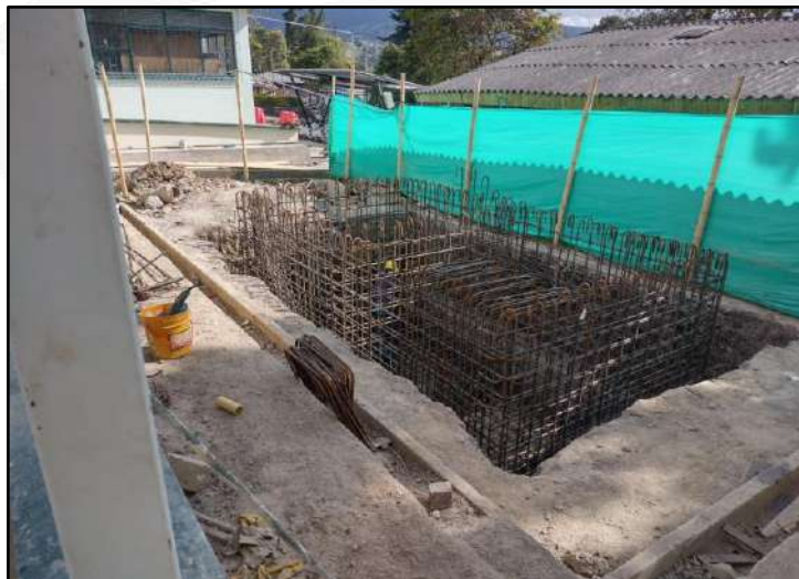
Armado de refuerzo para tanque de almacenamiento para el sistema RCI.
