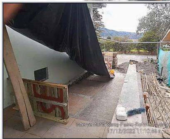
Instalación de Tablón de gres
