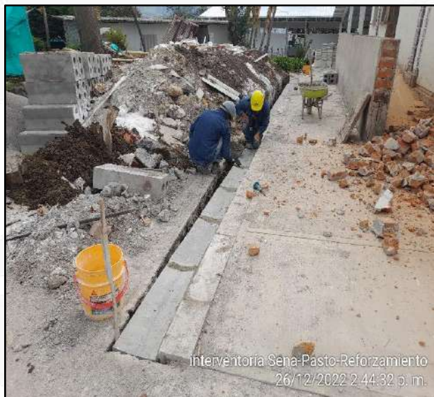
Instalación de Cañuela prefabricada en concreto tipo IDU A120,
