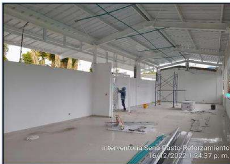
Aplicación de estuco acrílico en muros internos
