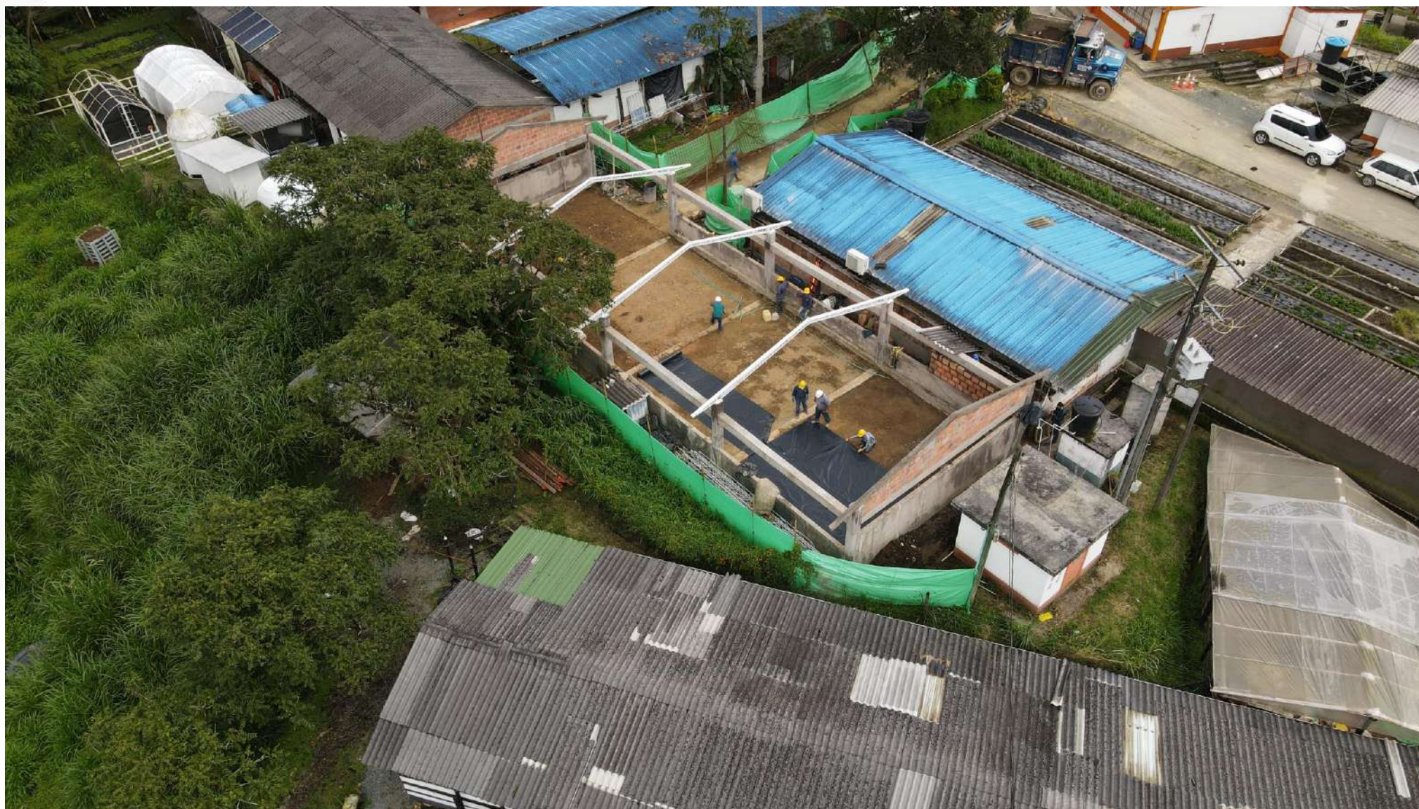
VISTA GENERAL INTERVENCIÓN DE REFORZAMIENTO ESTRUCTURAL EDIFICIO 42.
