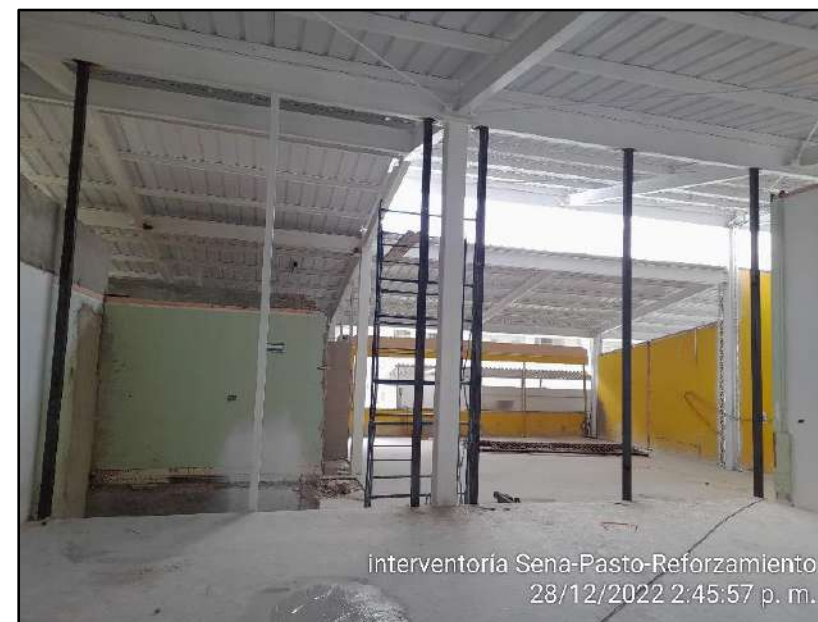
Instalación de perfiles estructurales cuadrados 90 x 90 mm, para muros livianos
