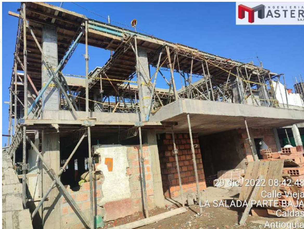
VISTA GENERAL INTERVENCIÓN DE REFORZAMIENTO ESTRUCTURAL EDIFICIO 66.1. Y 66.2.
