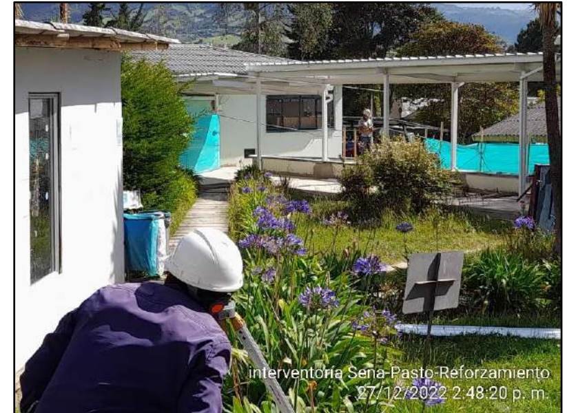
Control de asentamiento con equipo de topografía.
