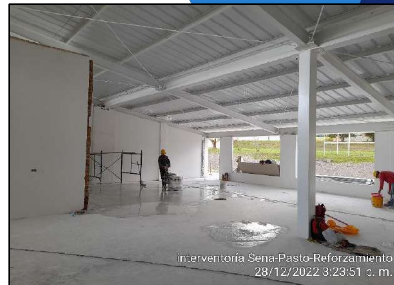
Acabado de piso Baldosa en grano de mármol vibroprensado 33x33 cm. (emboquillado, destronque y pulido)
