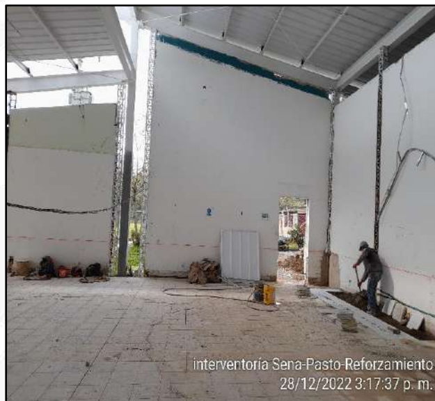
Instalación piso con Baldosa en grano de mármol vibroprensado 33x33 cm
