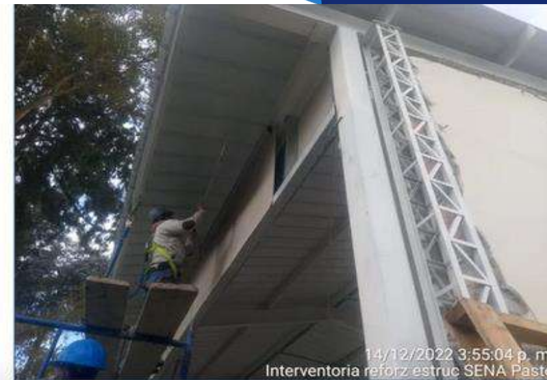
Construcción de muros fibrocemento
