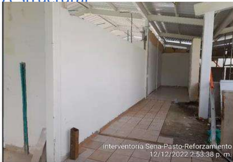
Instalación de Tablón de gres
