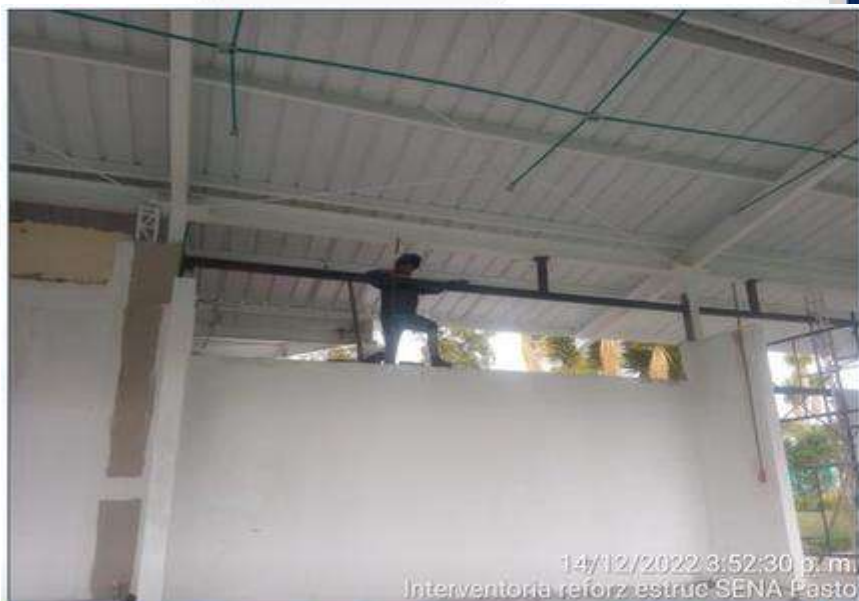
Montaje de estructura para dintel
