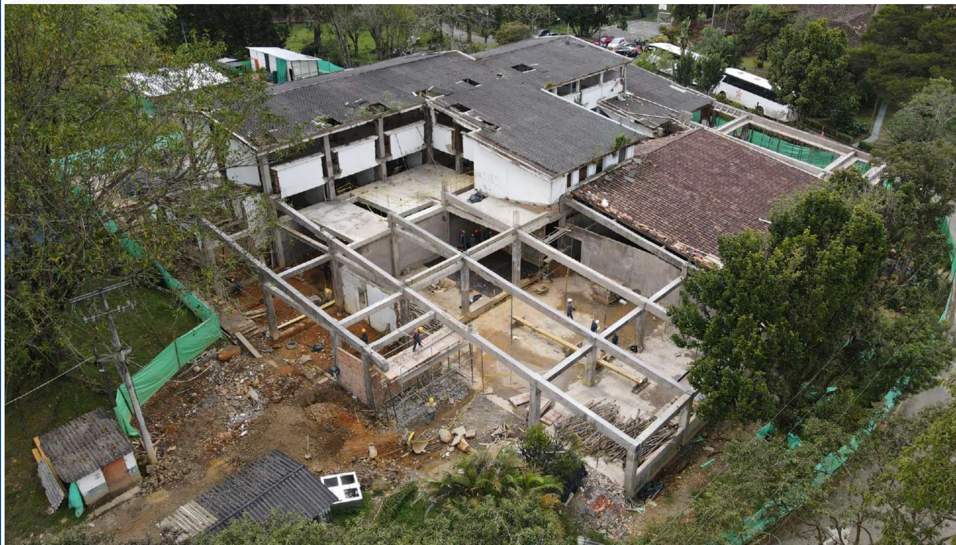
VISTA GENERAL INTERVENCIÓN DE REFORZAMIENTO ESTRUCTURAL EDIFICIO 16.
