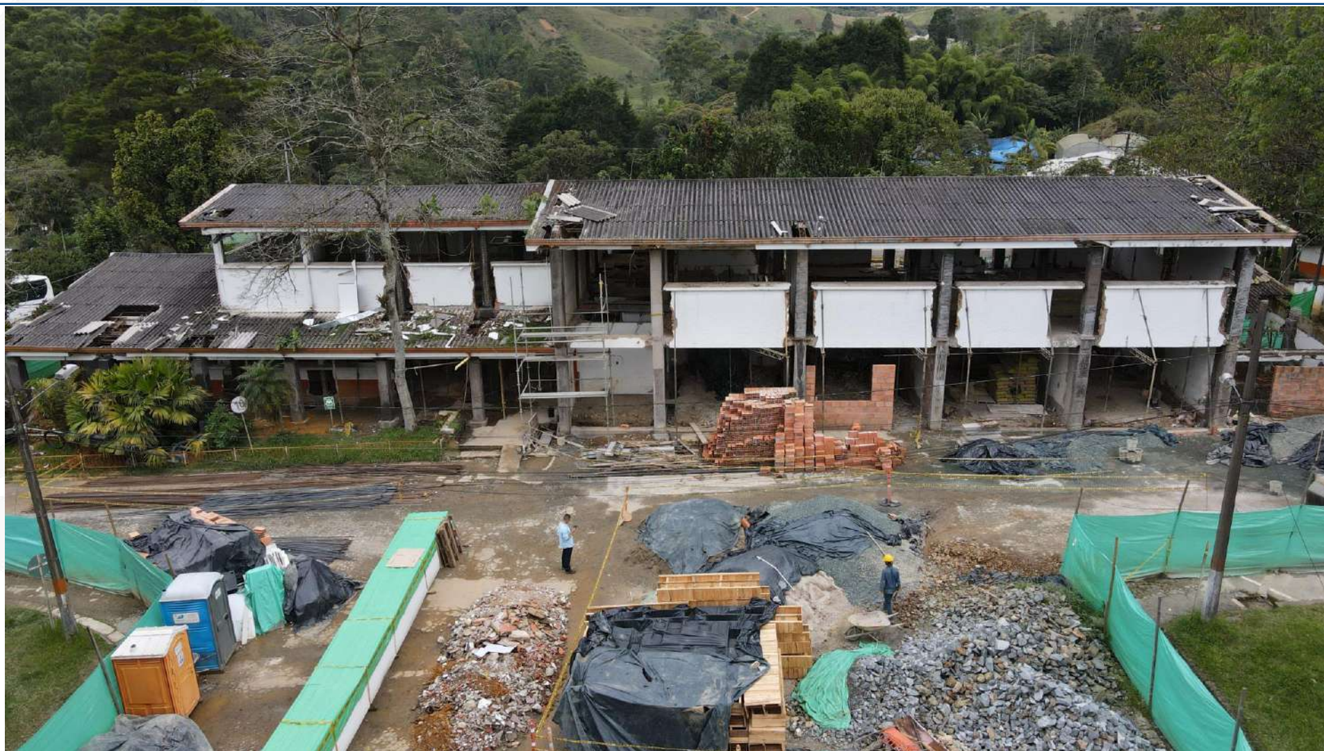
VISTA GENERAL INTERVENCIÓN DE REFORZAMIENTO ESTRUCTURAL EDIFICIO 16.
