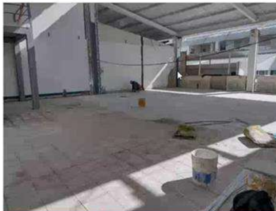
Instalación de acabado de piso Baldosa en grano de mármol -Multimedia
