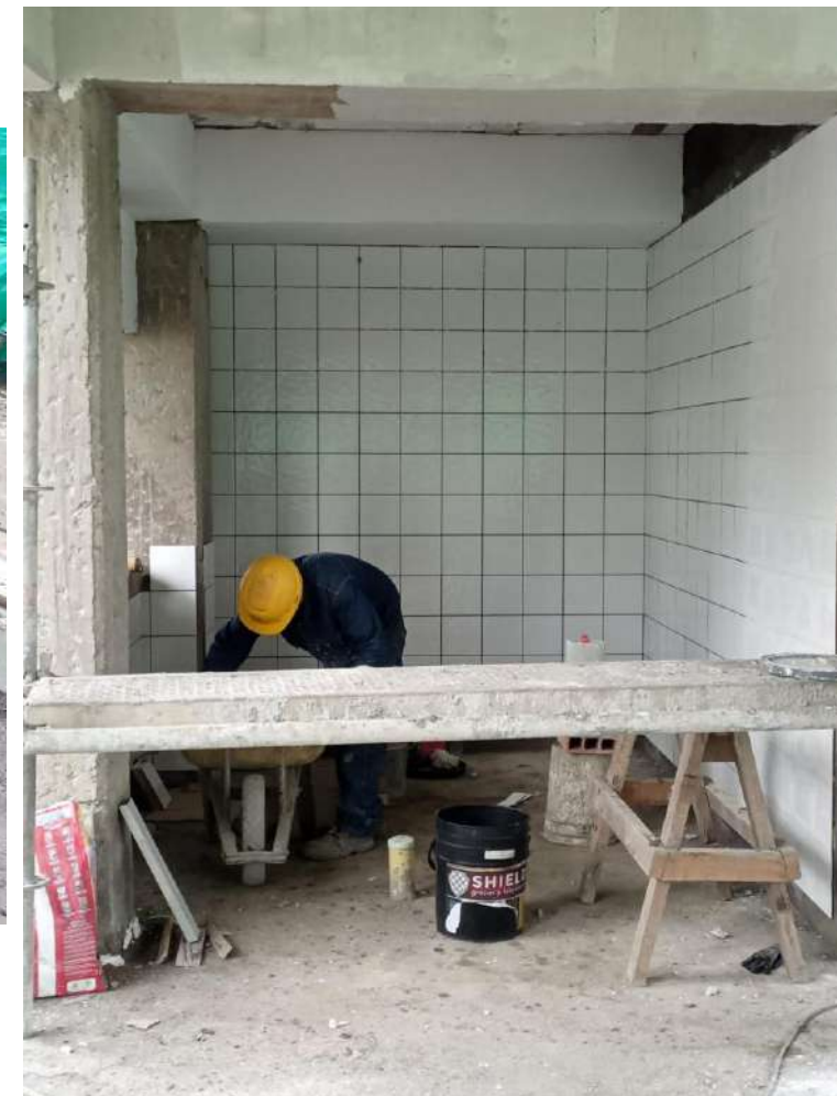
VISTA GENERAL INTERVENCIÓN DE REFORZAMIENTO ESTRUCTURAL EDIFICIO 66.1. Y 66.2.
