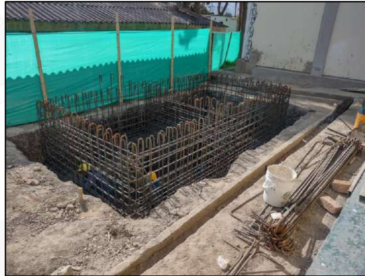
Armado de refuerzo para tanque de almacenamiento para el sistema RCI.
