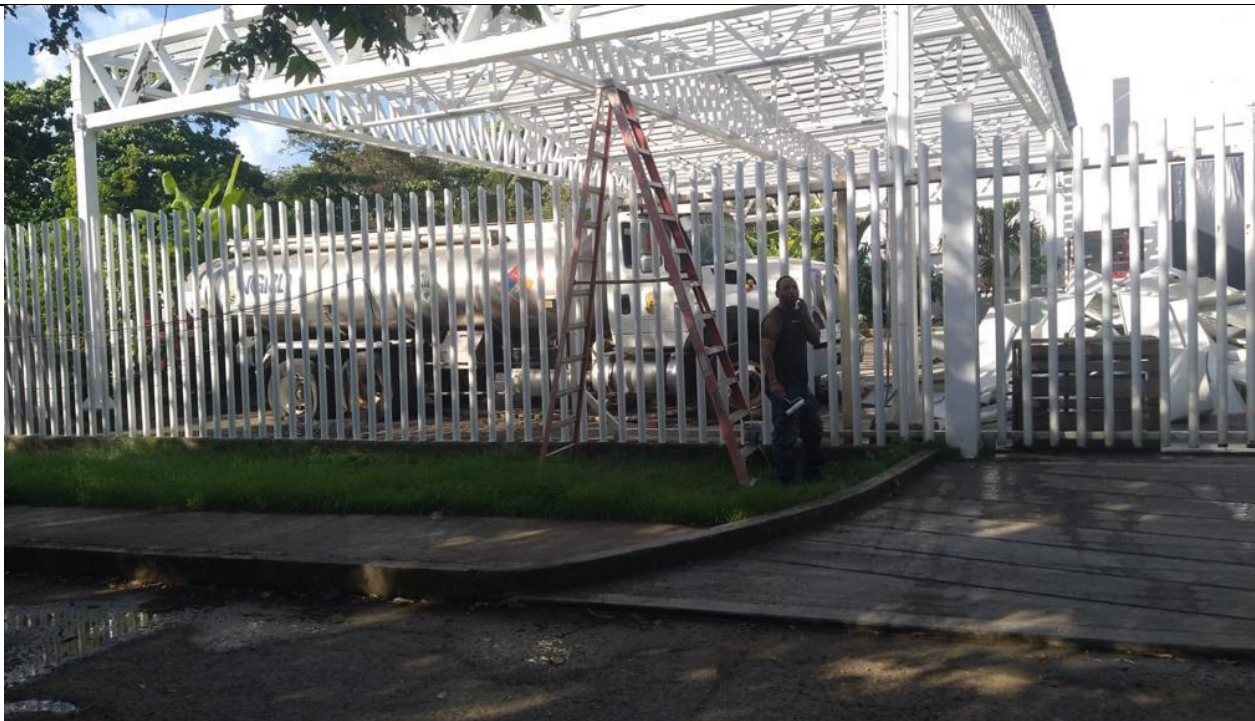
Img. 6 Limpieza y pintura de estructura metálica
