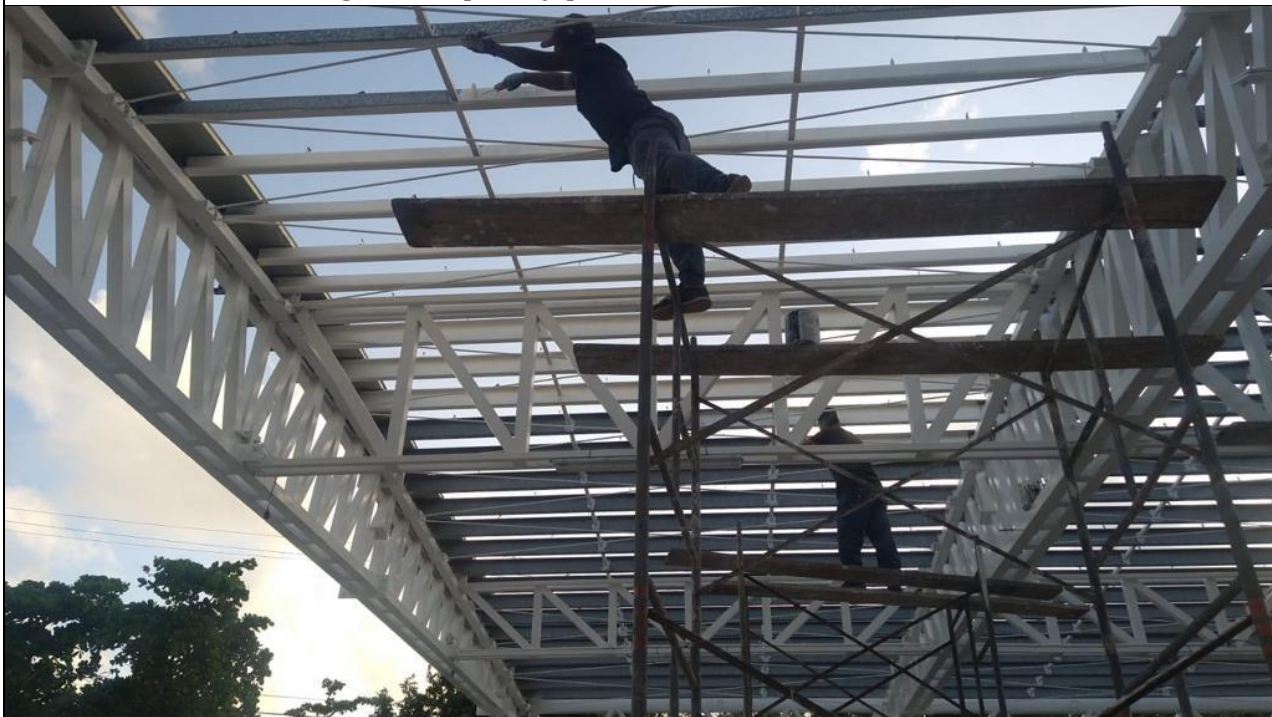
Img. 10 Limpieza y pintura de estructura metálica
