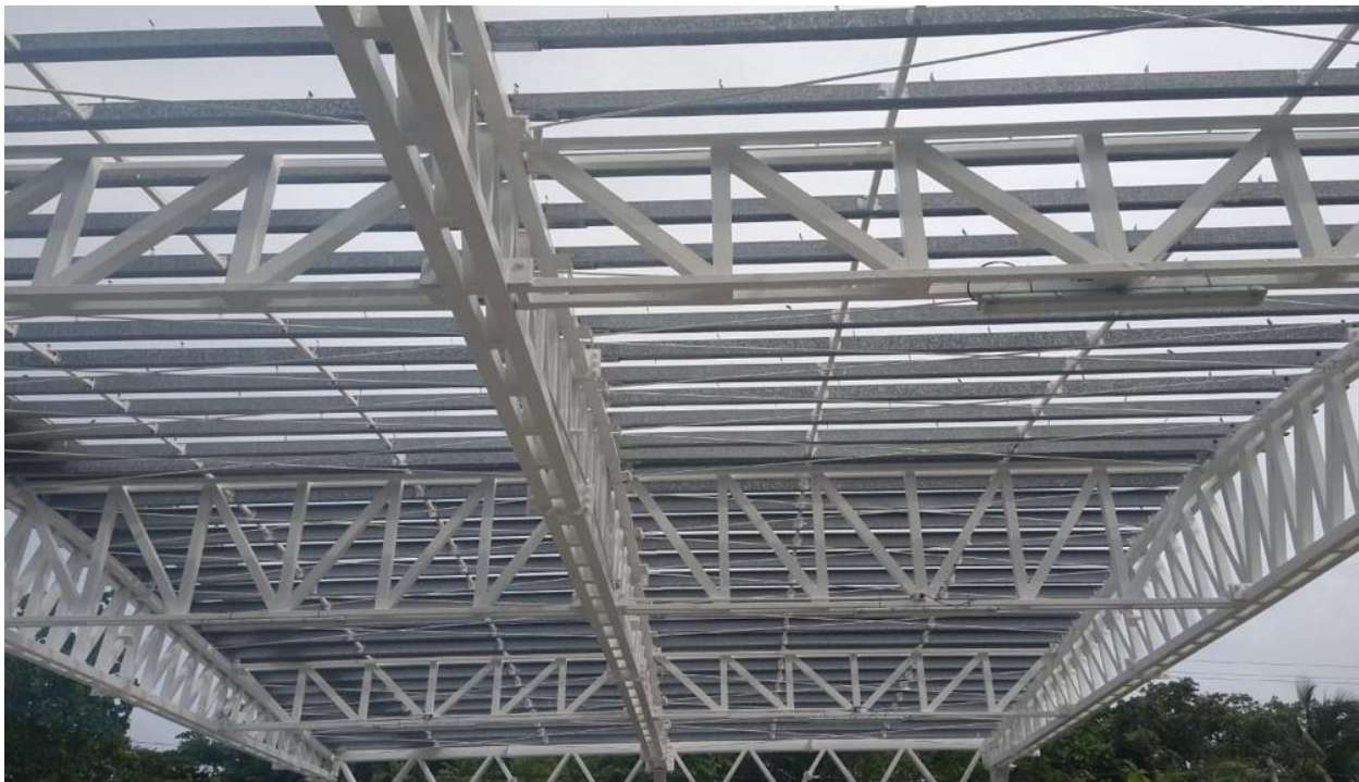
Img. 4 Limpieza y pintura de estructura metálica
