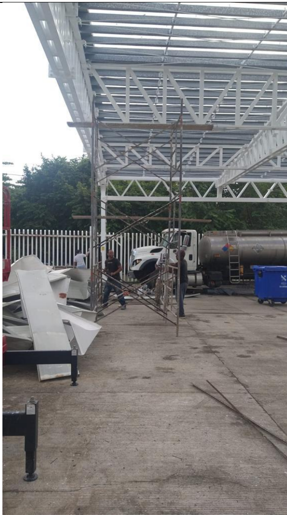
Img. 8 Limpieza y pintura de estructura metálica
