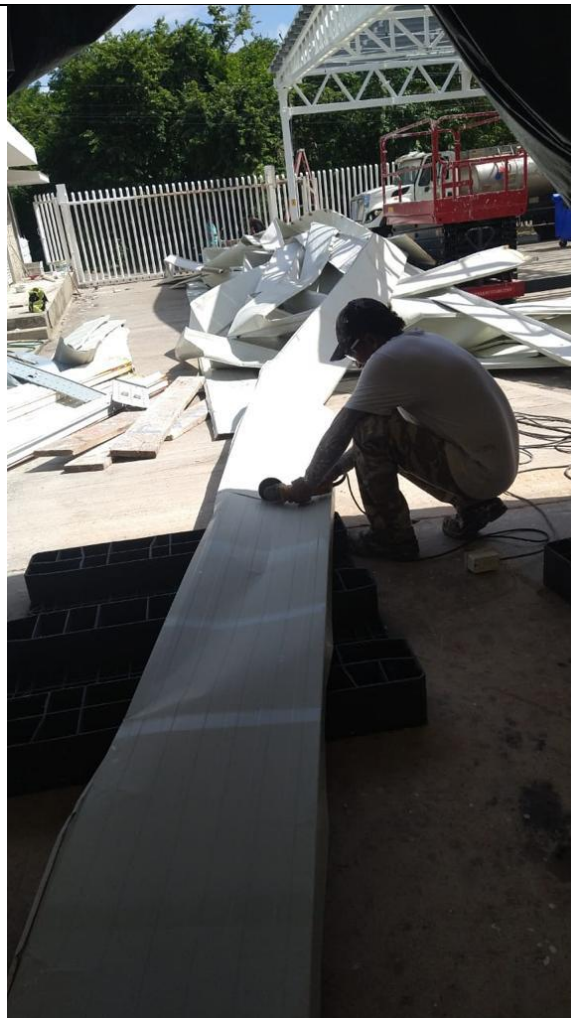
Img. 7 Corte e instalación de laminas
