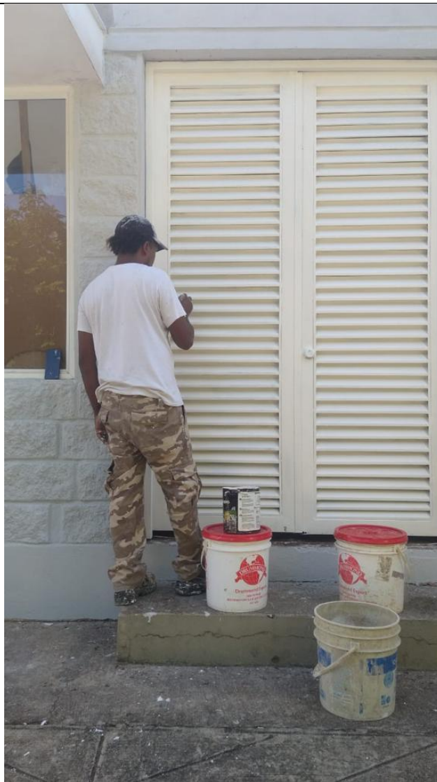
Img. 9 Pintura exterior de puertas metálicas
