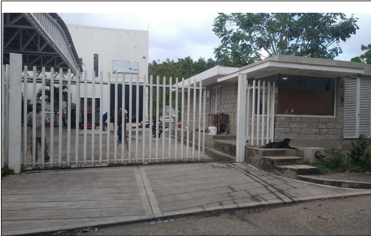
Img. 3 Limpieza y pintura de estructura metálica
