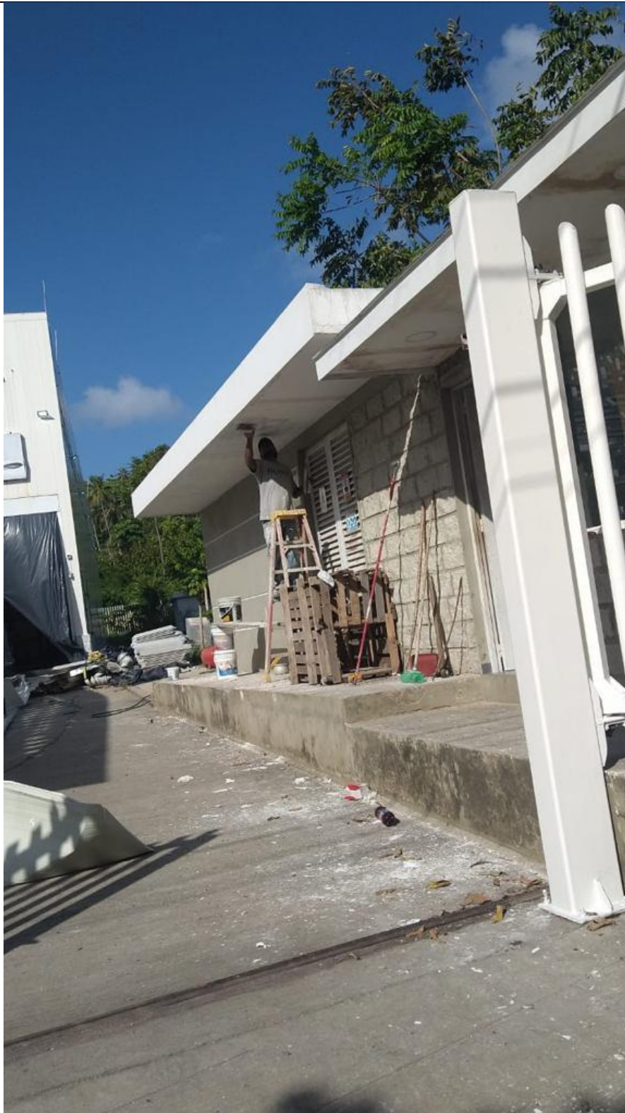
Img. 5 Pintura de muro exterior
