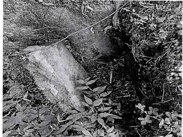
FOTOGRAFÍA No. 5, DEMOLICIÓN ESTRUCTURA EXIST.
