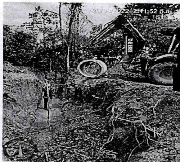
FOTOGRAFÍA No. 10 COLOCACIÓN TUBERÍA DE 36"
