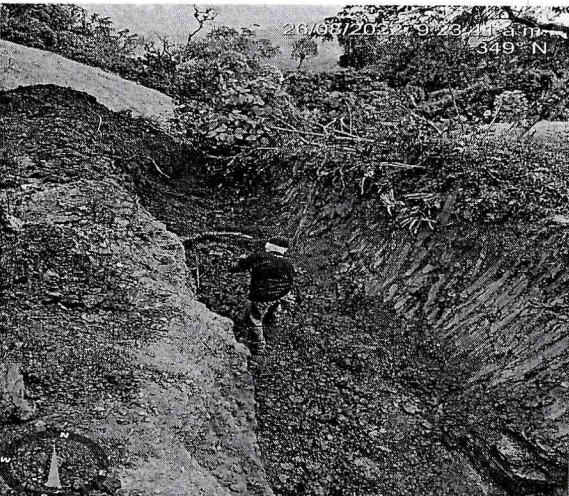
FOTOGRAFÍA No. 6, EXCAVACIÓN PARA TUBERÍA 36".
