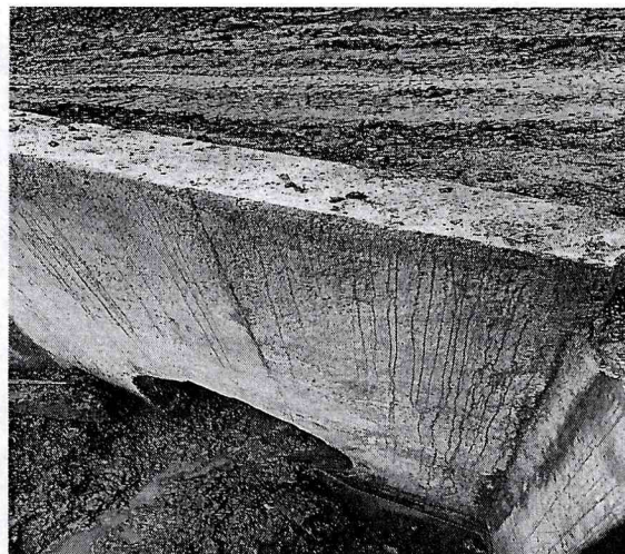
FOTOGRAFIA No. 18, MURO CABEZAL Y ALETAS ALCANTARILLA No. 3
