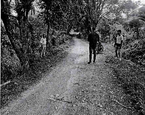
FOTOGRAFÍA No. 4, UBICACIÓN REPOSICIÓN ALCANT.
