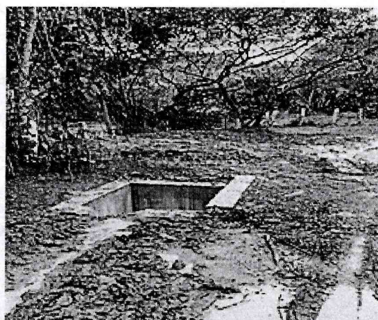
FOTOGRAFIA No. 20, POCETA ALCANTARILLA No. 4 TERMINADA
