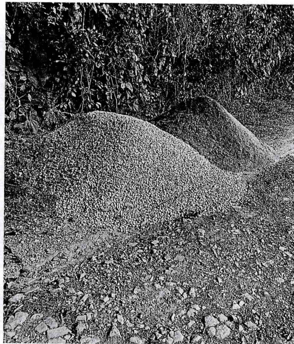
FOTOGRAFIA No. 2, MATERIAL UBICADO EN EL SITIO DONDE INICIALMENTE SE CONSTRUIRÍA LA ALCANTARILLA DE 36"
