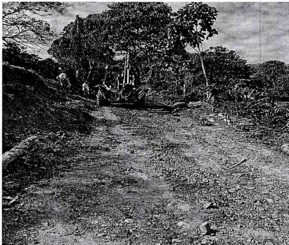
FOTOGRAFIA No. 17, ALCANTARILLA No. 3 TERMINADA SENTIDO NATAGA - EL MORAL
