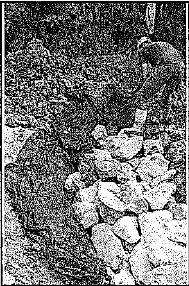
Imagen 5. Construcción de filtro la Párroquia
