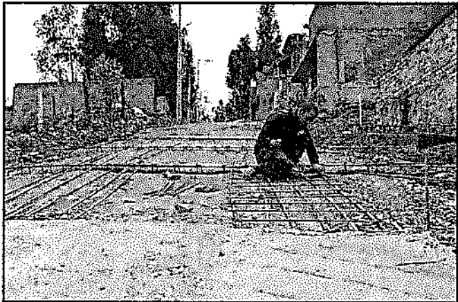
Imagen 3. Construcción Placa Huella San Antonio Norte
