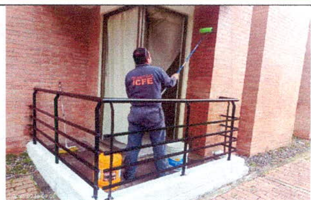
Aplicación impermeabilizante
