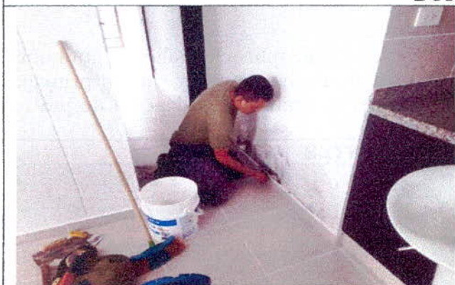
Resane y pintura pasillo
