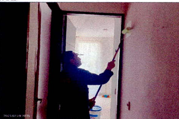
Resane y pintura pared habitación
