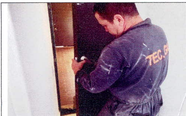
Instalación cerradura puerta principal
