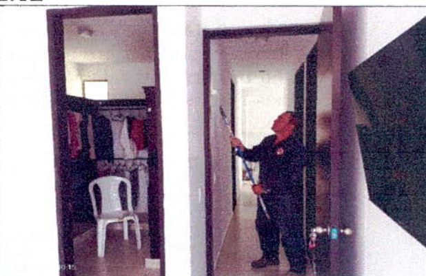
Resane y pintura pared habitación
