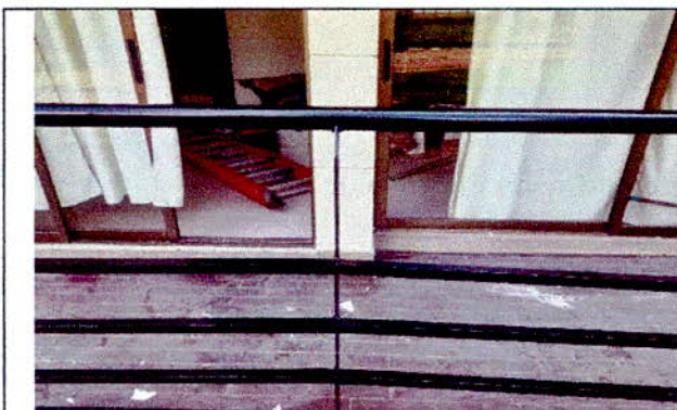
Estado barandas pasillo
