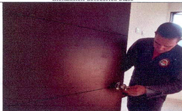
Instalación cerradura puerta
