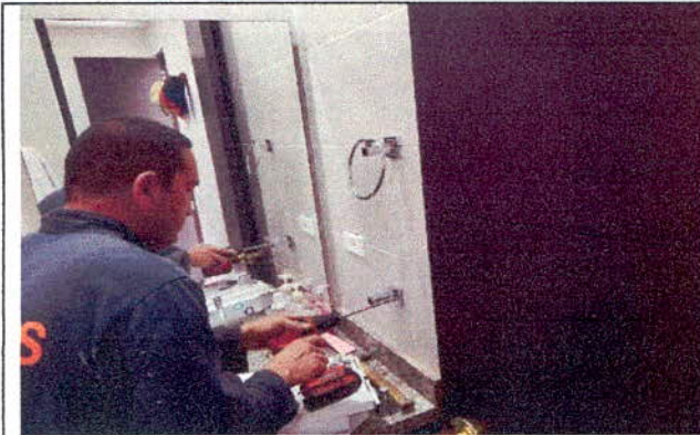
Instalación accesorios baño
