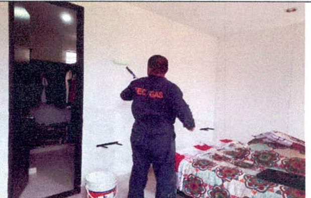
Resane y pintura inmueble
