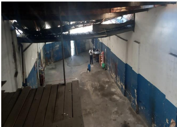
bodega primer piso
