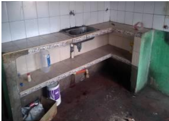
cocina tercer piso
