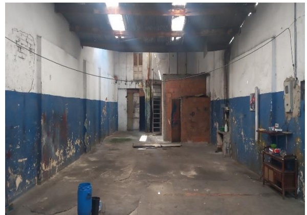
bodega primer piso
