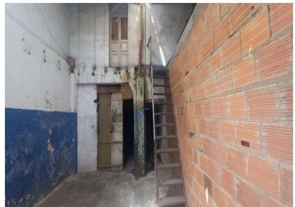
escalera 2º piso
