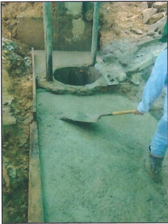
SUMINISTRO E INSTALACION DE CONCRETO CLASE F 14 MPA PARA EL SOLADO DE LIMPIEZA ESTRUCTURAS HIDRAULICAS
