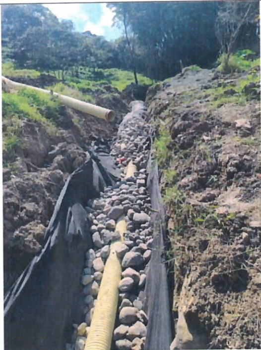
FOTO 7. FILTRO FRANCES CON BOLO DE RIO MAYOR A 1" DE DIAMETRO
