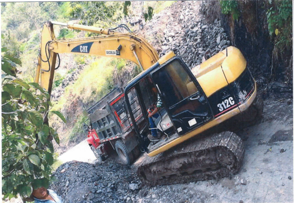
FOTO 5. RETIRO DE MATERIAL SOBRANTE PRODUCTO DE LAS EXCAVACIONES
