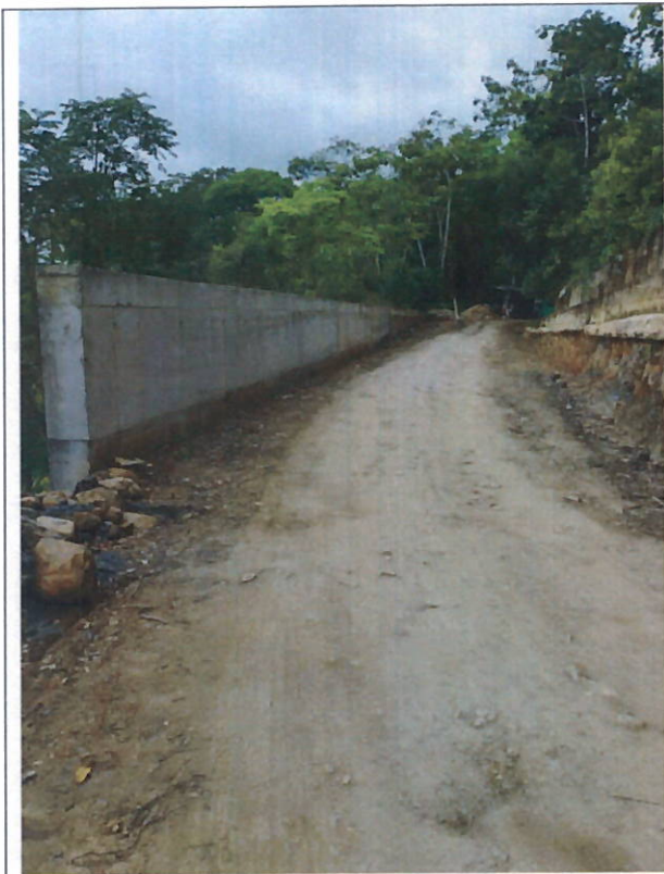
AVANCE DE OBRA
