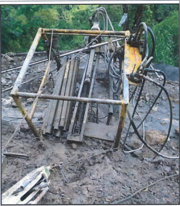
SUMINISTRO E INSTALACION DE ANCLAJES ACTIVOS D=4" 3 TORONES DE ½" 30 TON (INCLUYE EXCAVACION, ENCAMISADO, INSTALACION, INYECCION DE LECHADA Y TENSIONAMIENTO)
