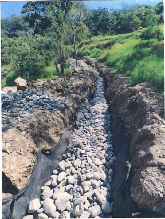
FOTO 8. FILTRO FRANCES CON BOLO DE RIO MAYOR A 1" DE DIAMETRO
