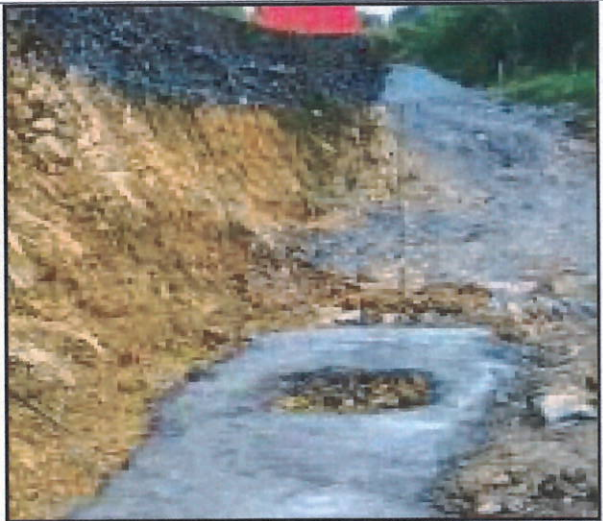
FOTO 6. CONCRETO DE 2.000 PSI - FC 150 KG/CM2 SOLADO DE LIMPIEZA
