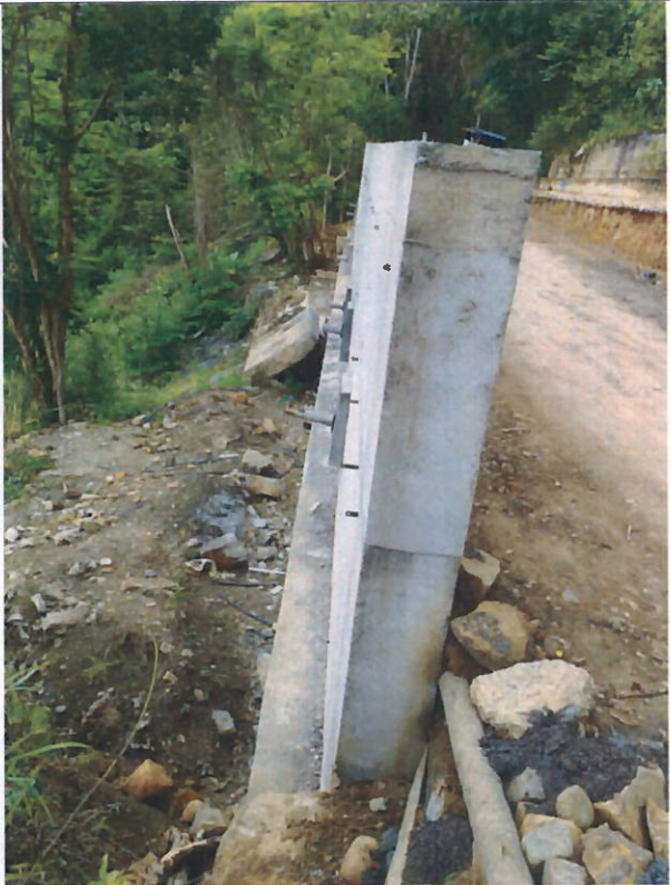
AVANCE DE OBRA
