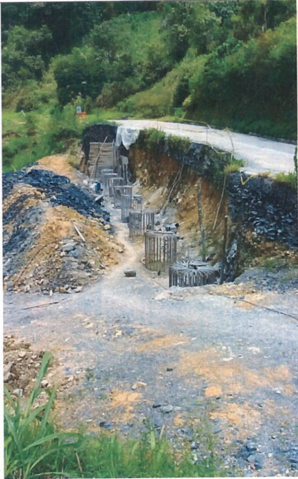
AVANCE DE OBRA
