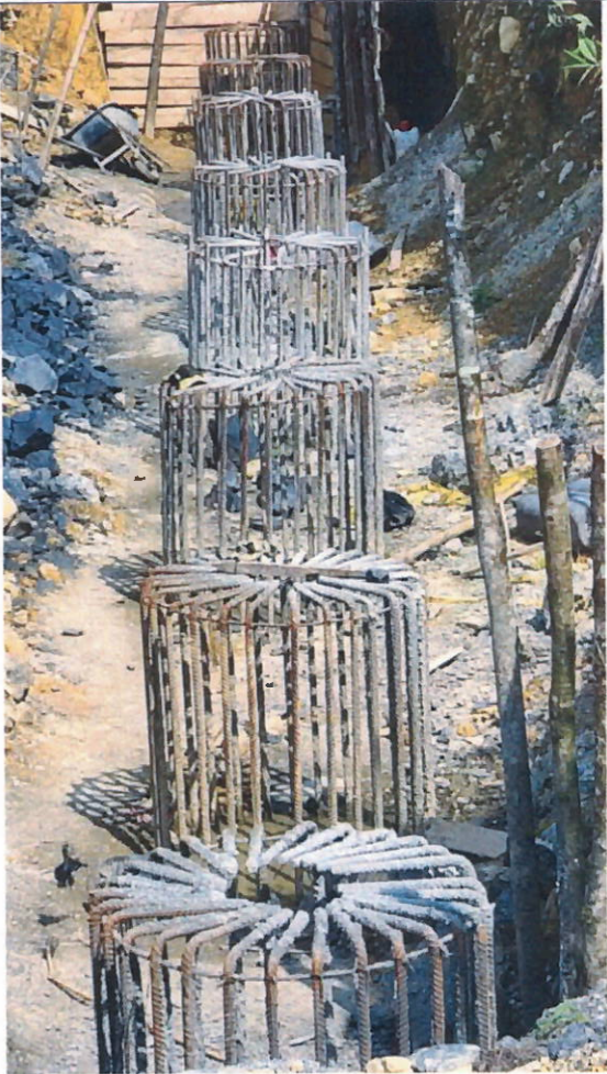
AVANCE DE OBRA
