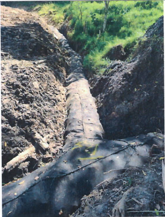
AVANCE DE OBRA
