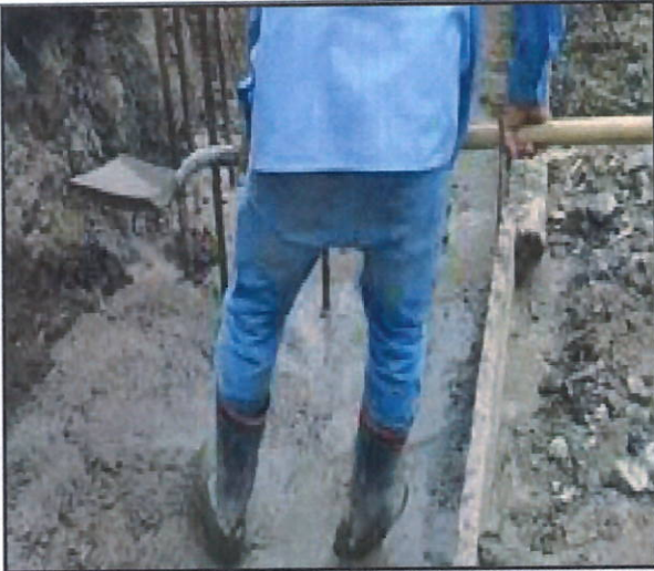
FOTO 5. CONCRETO DE 2.000 PSI - FC 150 KG/CM2 SOLADO DE LIMPIEZA
