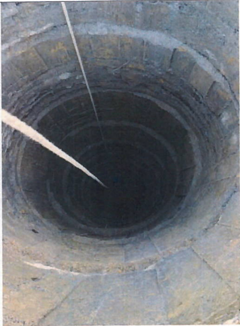
FOTO 1. CONCRETO DE 3.000 PSI - FC 210 KG/CM2 PARA CAISSON
