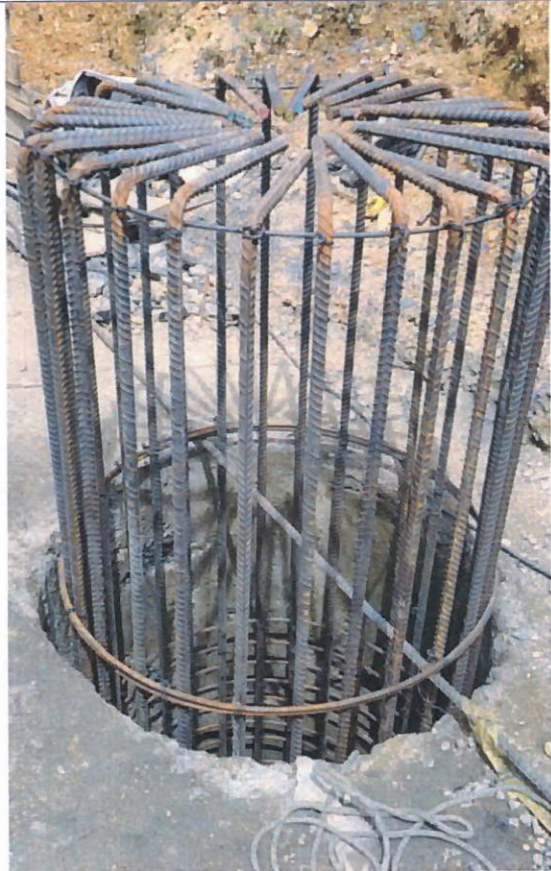
FOTO 6. ACERO DE REFUERZO.
