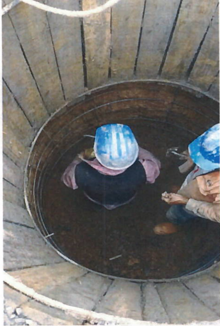
FOTO 2. CONCRETO DE 3.000 PSI - FC 210 KG/CM2 PARA CAISSON
