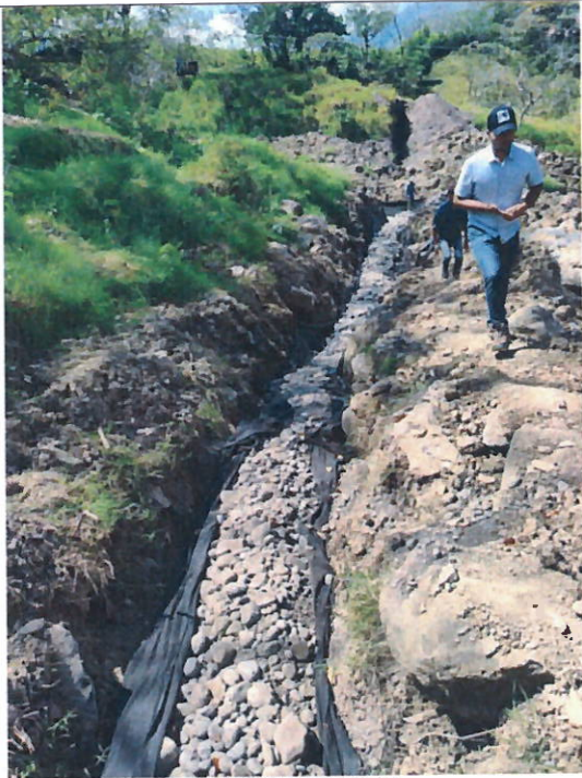
AVANCE DE OBRA
