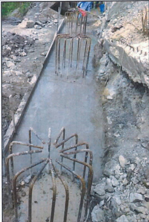
SUMINISTRO E INSTALACION DE CONCRETO CLASE F 14 MPA PARA EL SOLADO DE LIMPIEZA ESTRUCTURAS HIDRAULICAS
