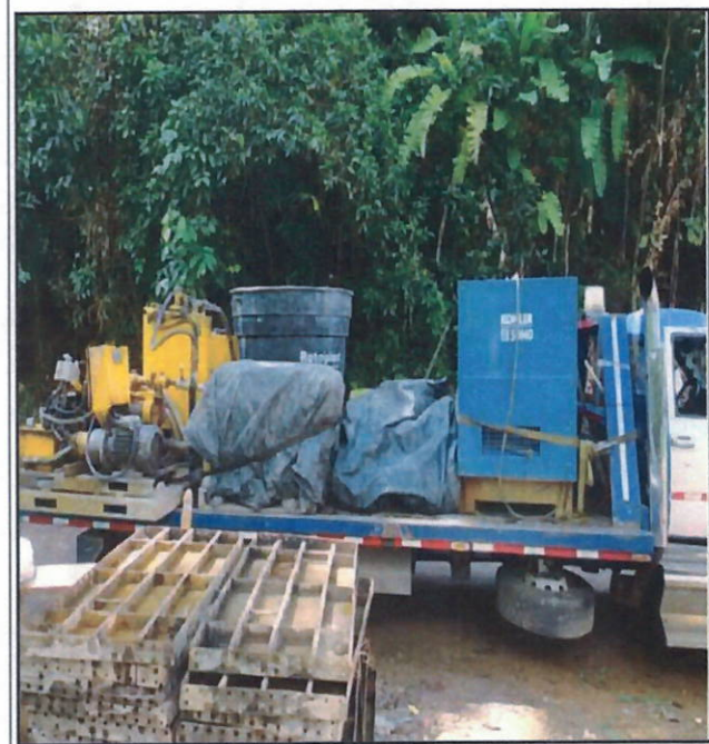
SUMINISTRO E INSTALACION DE ANCLAJES ACTIVOS D=4" 3 TORONES DE ½" 30 TON (INCLUYE EXCAVACION, ENCAMISADO, INSTALACION, INYECCION DE LECHADA Y TENSIONAMIENTO)
