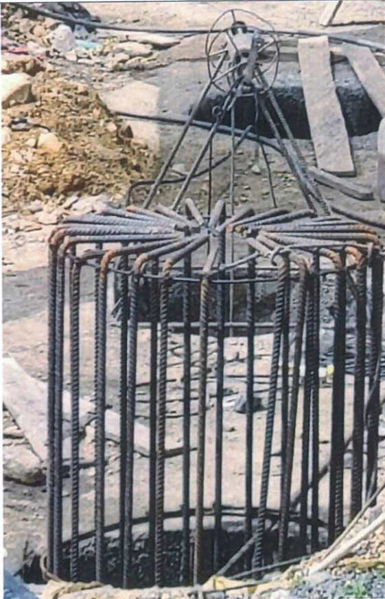
FOTO 5. ACERO DE REFUERZO.
