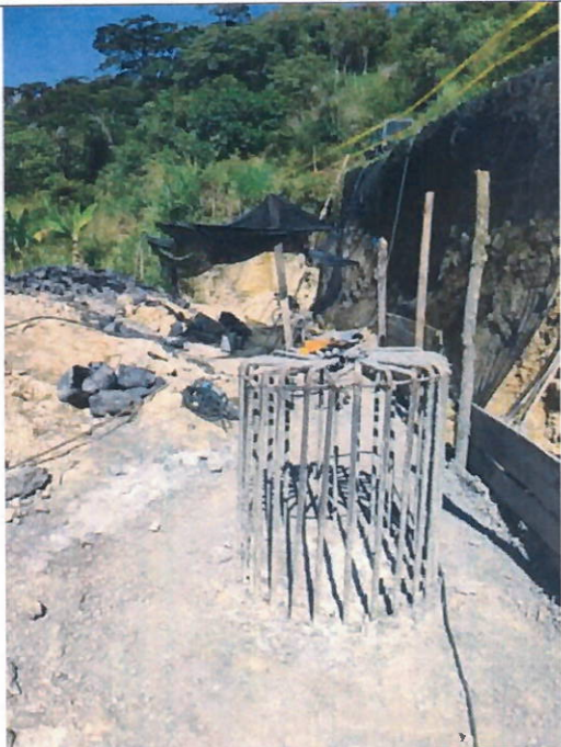
FOTO 3. CONCRETO DE 3.000 PSI - FC 210 KG/CM2 PARA CAISSON
