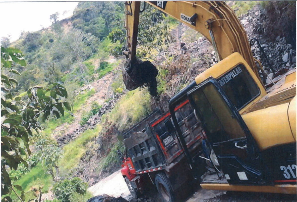
FOTO 6. RETIRO DE MATERIAL SOBRANTE PRODUCTO DE LAS EXCAVACIONES
