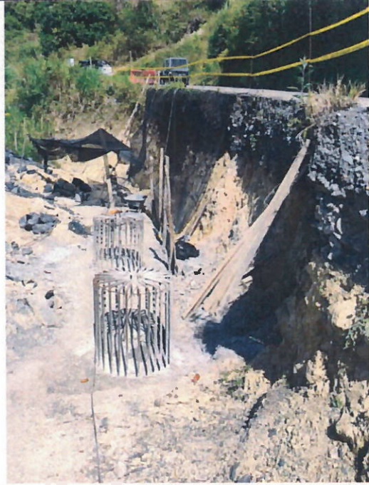
FOTO 4. CONCRETO DE 3.000 PSI - FC 210 KG/CM2 PARA CAISSON
