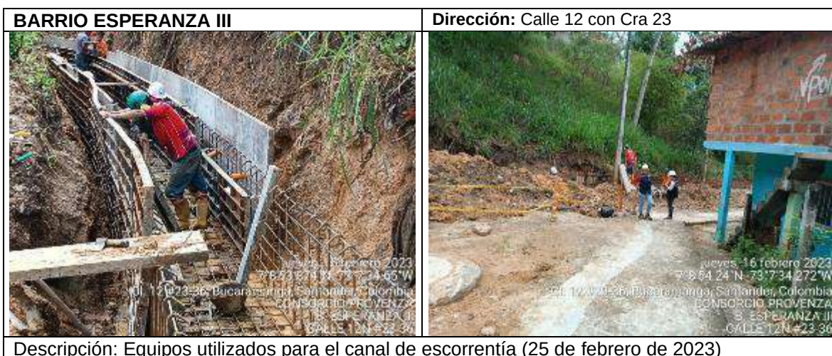
Descripción: Inspección del canal de escorrentía (25 de febrero de 2023)
