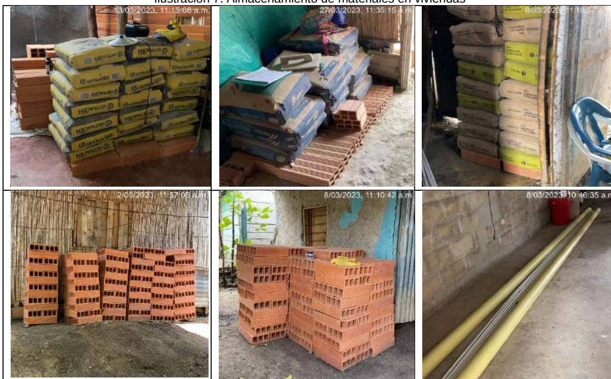
Ilustración 7. Almacenamiento de materiales en viviendas
