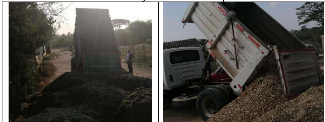
Ilustración 13. Ingreso a obra de material pétreo
