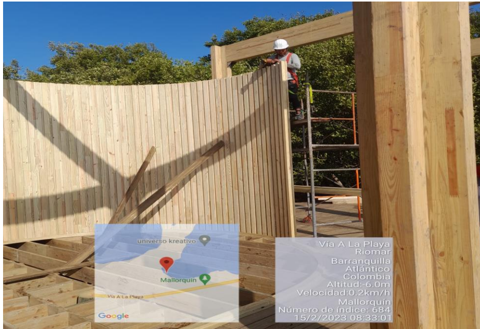
Imagen 3: Instalación de muros exteriores.
