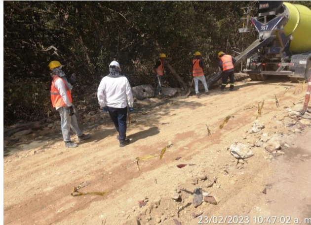
Imagen 26: vaciado concreto de solado
