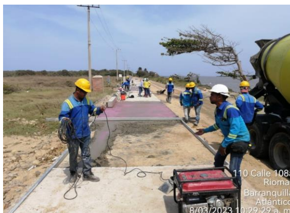
Imagen 33: vaciado concreto de solado.
