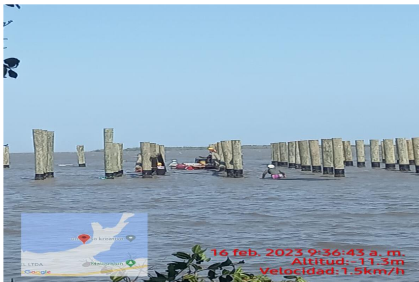
Imagen 5: Instalación de riostras
