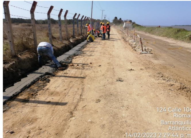
Imagen 24: vaciado de concreto de solado
