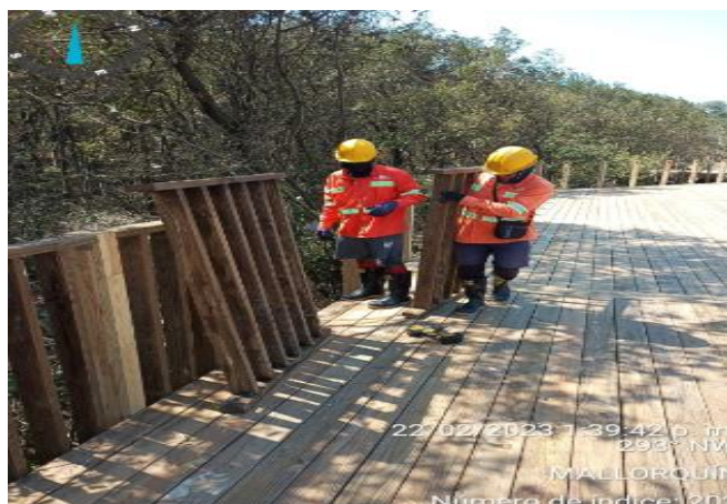
Imagen 6: Instalación de barandas.
