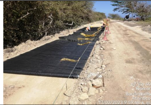
Instalación de Geotextil
