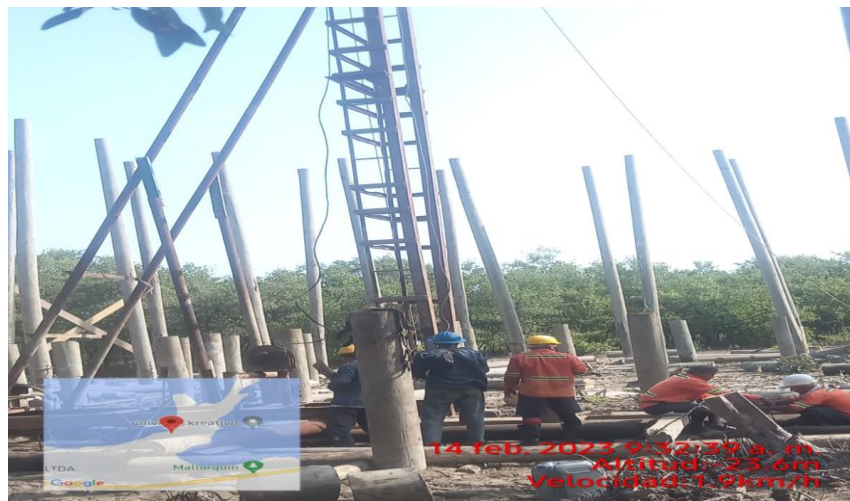
Imagen 2: Instalación columna de en cruz.
