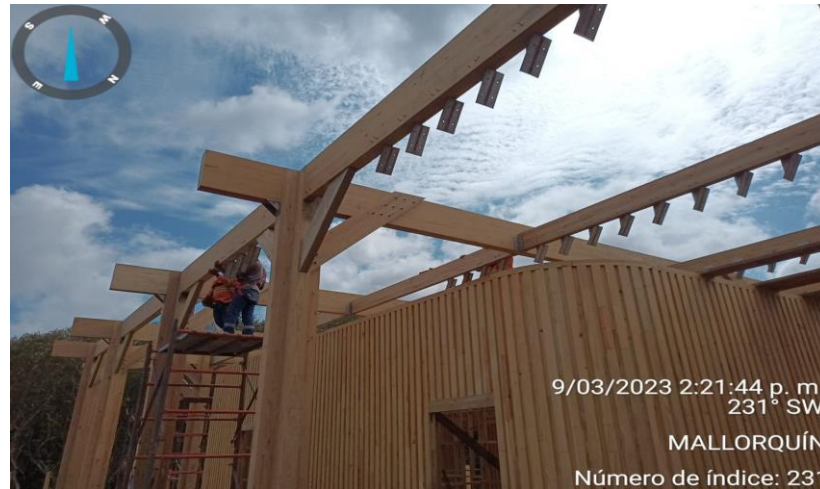
Imagen 15: vigas aéreas estación La Playa.
