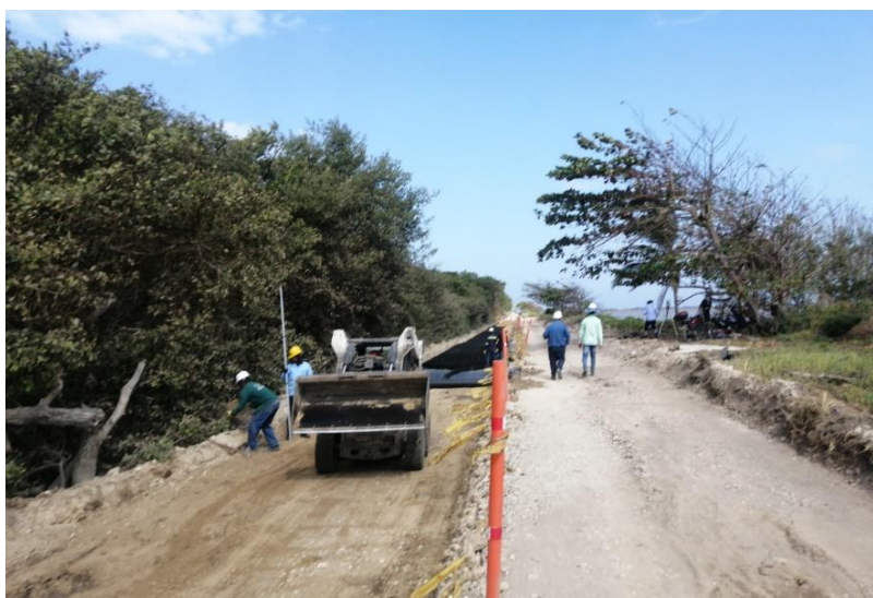
Imagen 32: instalación de geoceldas.
