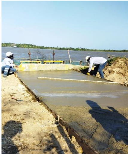
Imagen 28: vaciado concreto de solado
