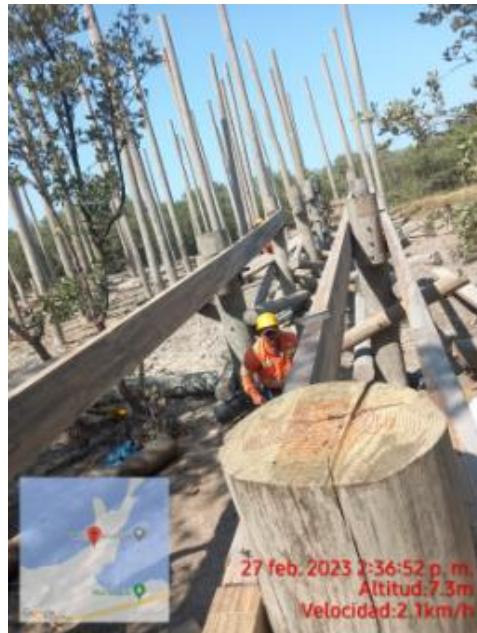
Imagen 11: Instalación de vigas laminadas.
