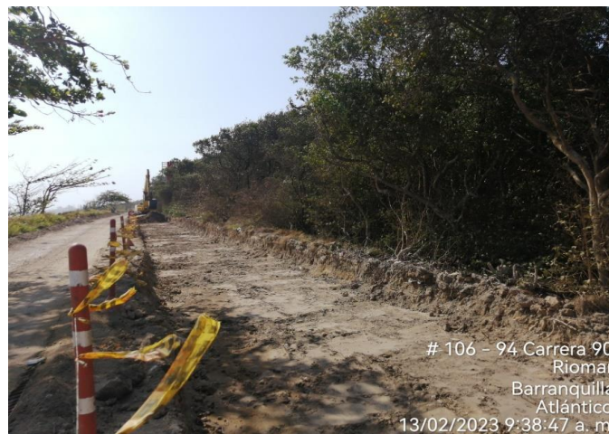
Imagen 22: Excavación para instalación de geoceldas.
