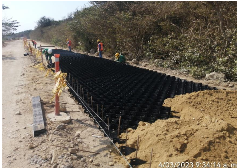
Imagen 29: instalación de geoceldas.
