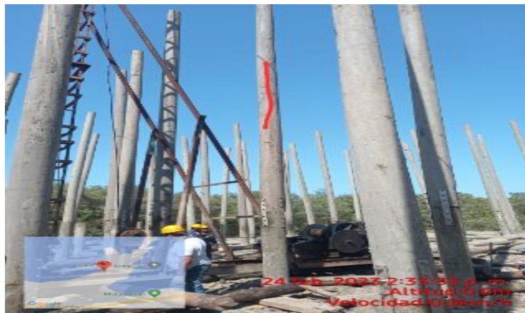
Imagen 8: Izado de pilotes.
