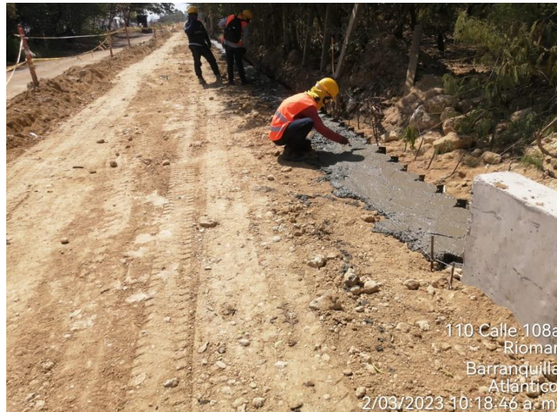
Imagen 30: vaciado de concreto de solado.
