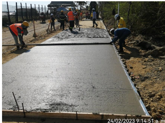
Imagen 27: vaciado concreto de solado
