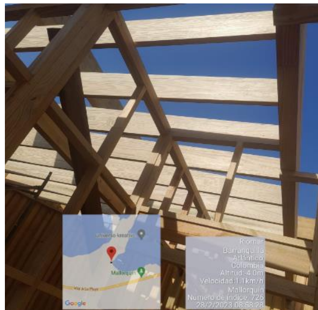
Imagen 10: Instalación de cubierta.
