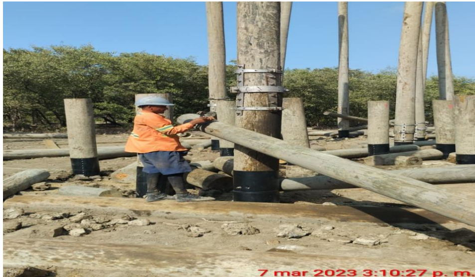
Imagen 16: Instalación de riostras
