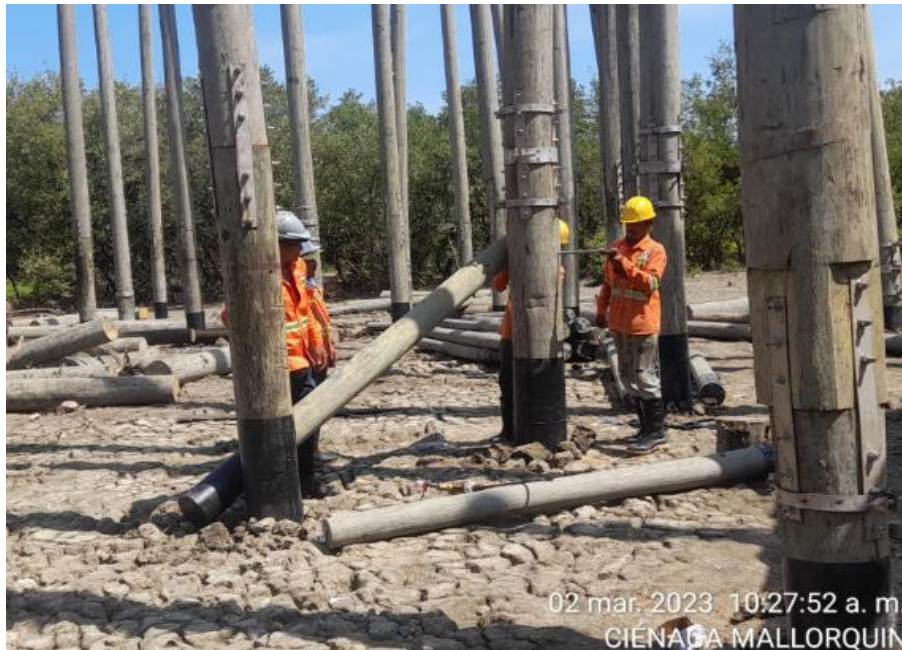
Imagen 13: Instalación de ríostros.
