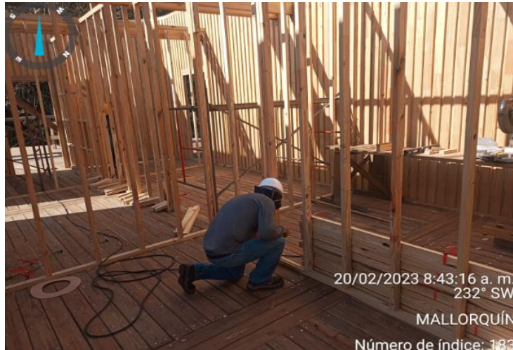
Imagen 7: instalación de marcos.
