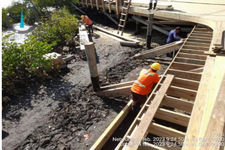
Imagen 9: Armado de gradería.
