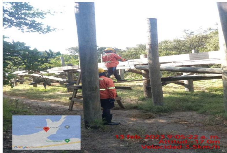
Imagen 1: Instalación de vigas laminadas.
