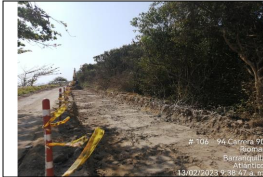
Excavación para instalación de geoceldas
