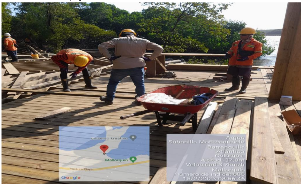
Imagen 4: Instalación de piso en deck.
