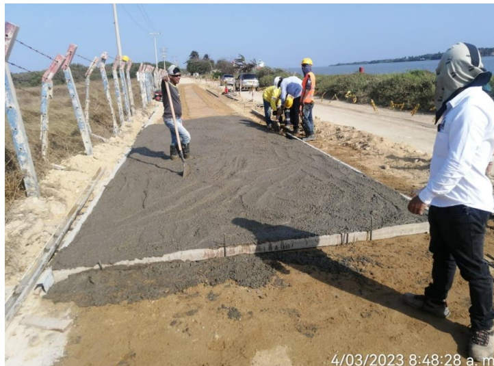
Imagen 31: vaciado concreto de solado.
