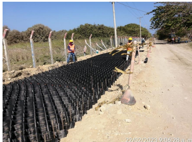
Imagen 25: Instalación de geocelda.
