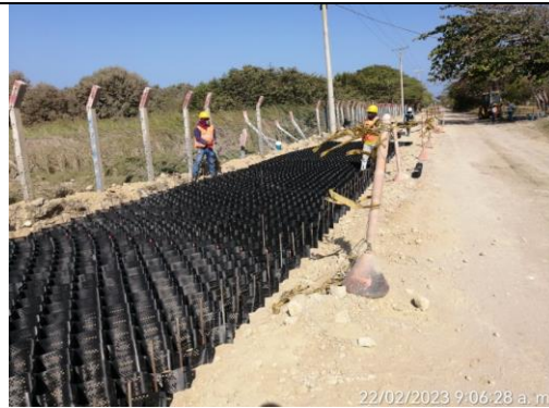
Excavación para instalación de geoceldas
