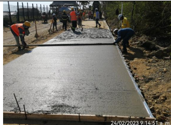
Vaciado de Concreto para Solado
