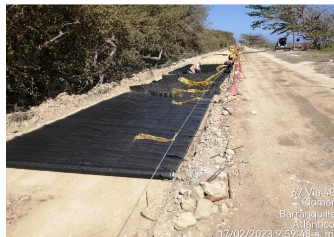
Imagen 23: Instalación de geotextil.
