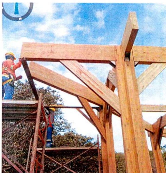
Ilustración 10 Vigas Instaladas – M13
