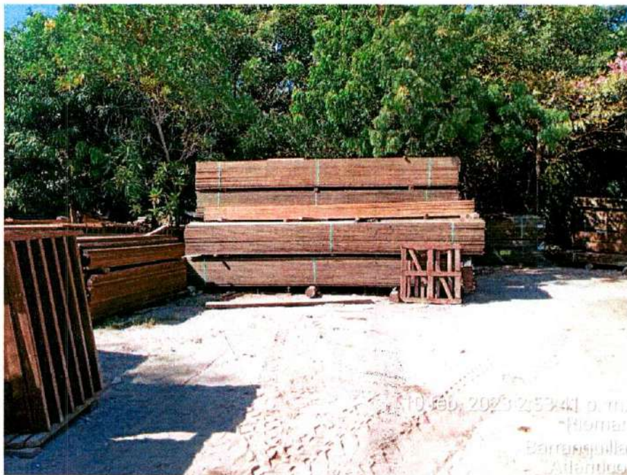
Fotografía 1. Acopio de Materiales de Construcción
