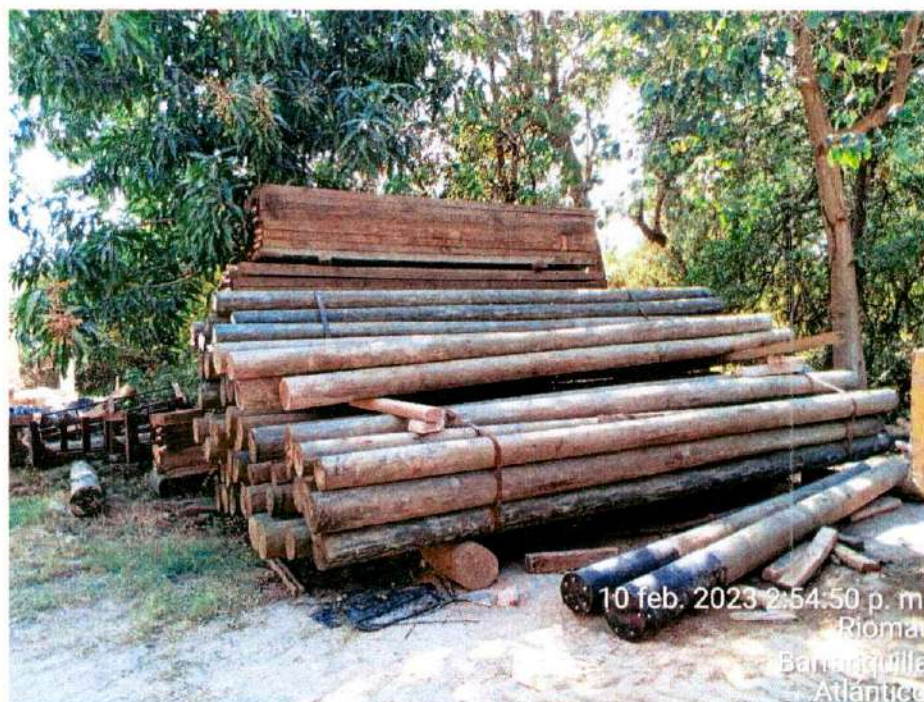
Fotografía 5. Acopio de Materiales Campamento
