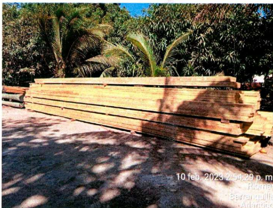
Fotografía 2. Acopio de Materiales de Construcción
