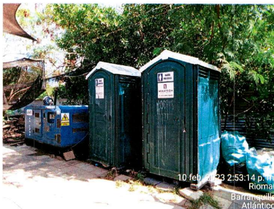
Fotografía 6. Baños Portátiles Campamento
