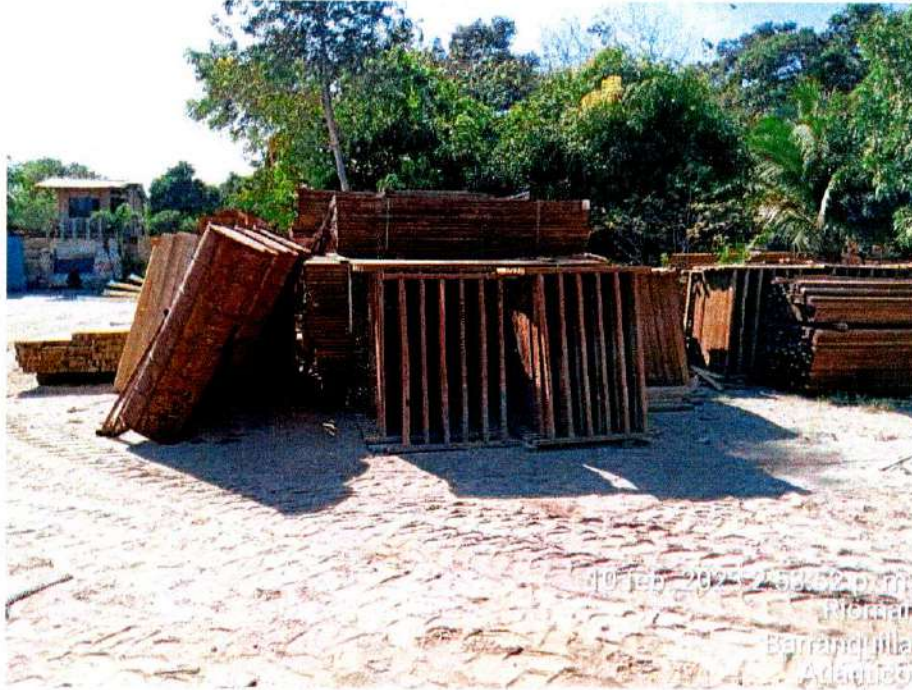
Fotografía 3. Acopio de Materiales Campamento
