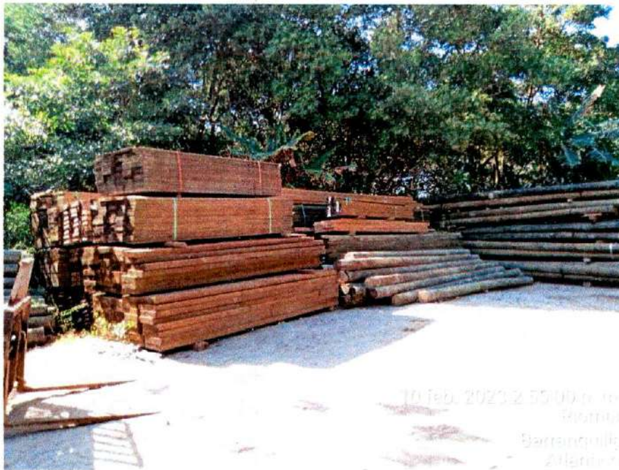
Fotografía 4. Acopio de Materiales Campamento
