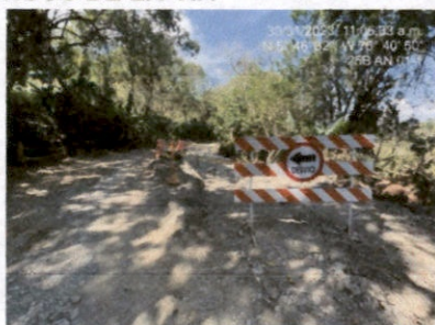
FOTO 5 SEÑALIZACIÓN PREVENTIVA PUNTOS CRÍTICOS DE LA VÍA
