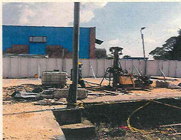
INSTALACIÓN DE PIEZÓMETROS
