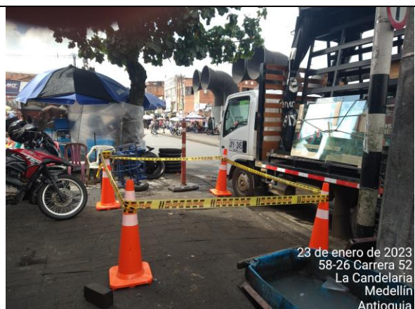
Frentes debidamente señalizados.
