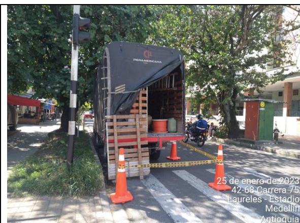
Señalización adecuada en obra.
