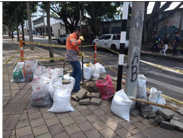
Demolición en sitio con almádana, protección de la zona con sarán
