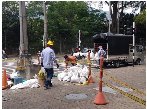
Recolección de residuos de demolición en costales para almacenaje en bodega.
