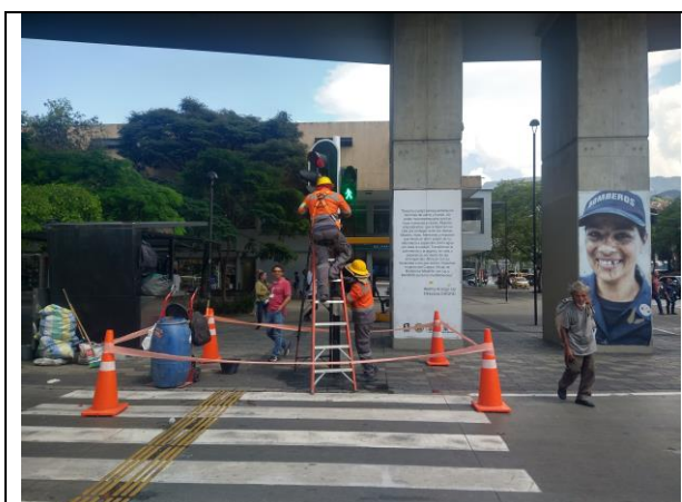
Actividad de lavado-caneca de 80 litros en el frente de trabajo.
