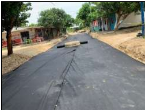
Fecha 12/07/2022: Se evidencia el extendido de Geotextil para separación de capas en vía calle 20.
