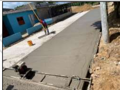
Fecha 29/07/2022: Se evidencia actividades de acabado en losas de pavimento rígido.
