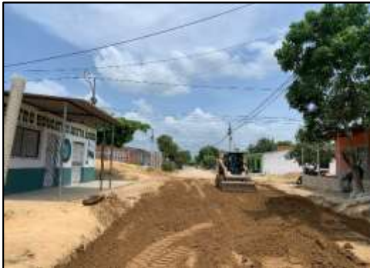
Fecha 06/07/2022: Conformación de capa de subbase granular en intersección calle 18 con carrera 47.
