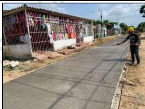
Fecha 29/07/2022: Acabados en losas de pavimento rígido intersección carrera 47 con calle 18.
