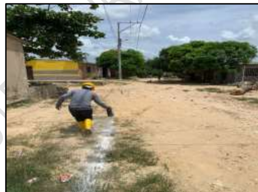
Fecha 15/07/2022: Trazado y demarcación de acuerdo a dimensiones de anchos de vía en carrera 47.
