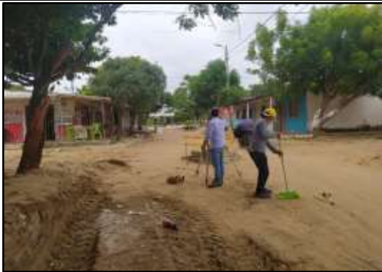
Fecha 21/07/2022: Nivelación topográfica a capa de material de afirmado en calle 20.
