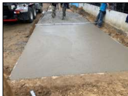
Fecha 28/07/2022: Actividades de vaciado en concreto para losas de pavimento rígido en vía calle 18.
