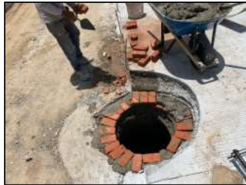
Fecha 26/07/2022: Realce de Manholes existentes en vía calle 18.
