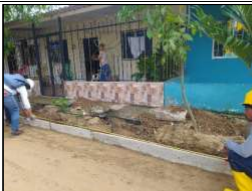
Fecha 28/07/2022: Demarcación de longitudes de losas de acuerdo a la modularción.
