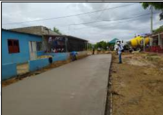
Fecha 28/07/2022: Actividades de losas de pavimento rígido en calle 18, carril derecho.
