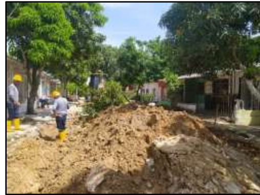
Fecha 14/07/2022: Actividades de excavaciones varias sin clasificar en la carrera 47.
