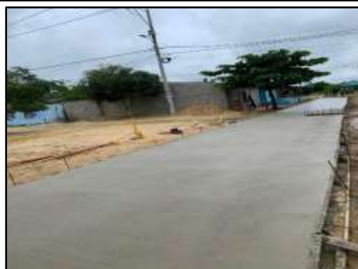
Fecha 29/07/2022: Se evidencia el vaciado en concreto para pavimento rígido.
