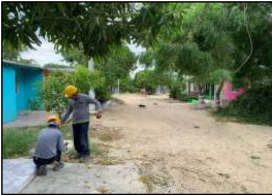
Fecha 13/07/2022: Colocación de estacas para demarcar vía carrera 47.
