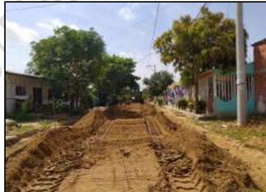
Fecha 07/07/2022: Se realizó el extendido del material de subbase granular en la longitud de la carrera 47.
