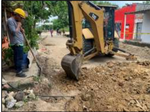
Fecha 06/07/2022: Se evidencia las actividades de excavaciones varias sin clasificar en vía calle 20.
