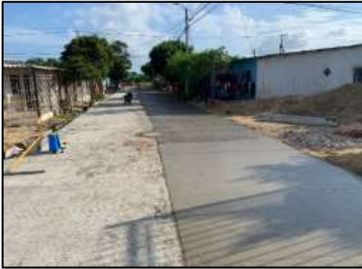
Fecha 29/07/2022: Estado de vía calle 18 con el vaciado en concreto rígido para estructura de pavimento.
