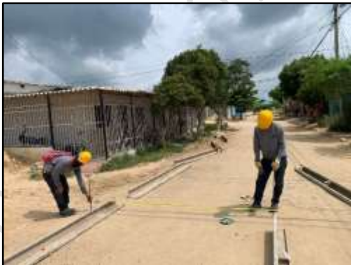
Fecha 19/07/2022: Verificación de anchos de losas de pavimento de acuerdo a los diseños del proyecto.
