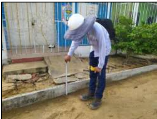
Fecha 27/07/2022: Chequeo de espesores de estructura de pavimento rígido.
