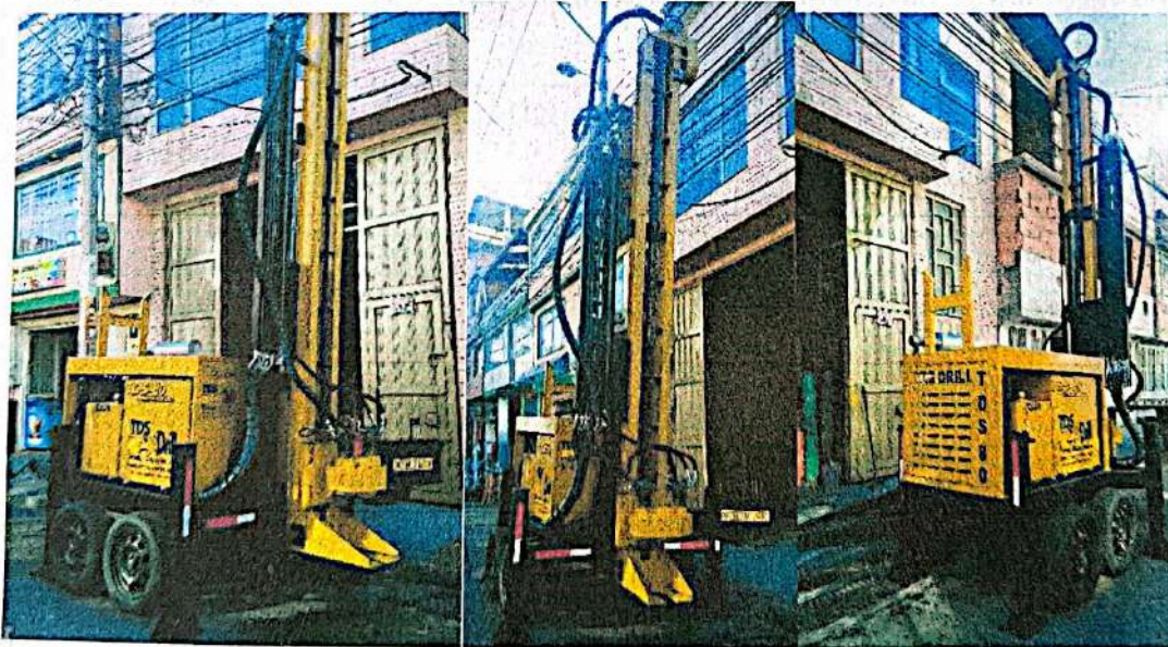
Imagen 1. Equipo de perforación TDS 100 POWER HYDRAULICS
